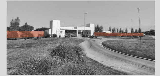
Portal de Ingreso
