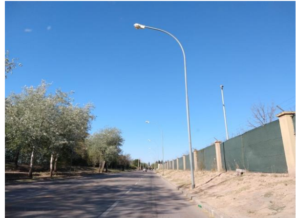
Fig. 97. [Vista perímetro Norte de Manantiales Country, sobre Av. de acceso] Liborio, 2018
