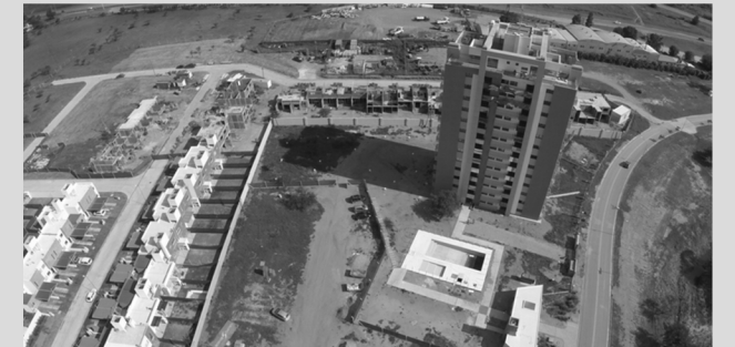
Vista Aérea de 1° torre construída
