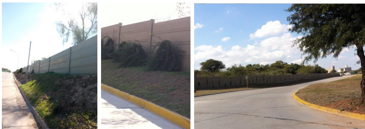
Fig. 93, 94 y 95. [Vistas de distintos tramos del muro sobre vías del ferrocarril] Liborio, 2016
