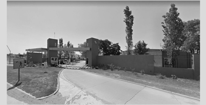
Portal de Ingreso
