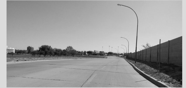
Delimitación Perimetral sobre calle San Antonio
