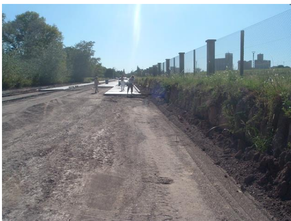
Fig. 61. [Pavimentación en proceso. Ingreso al sector] Liborio, 2009
