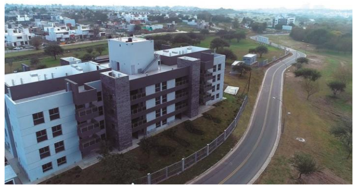
Fig. 107. [Vallado perimetral del conjunto de viviendas colectivas Casonas de los Arcos] Captura de Pantalla de http://bit.ly/2v0AOiM .
