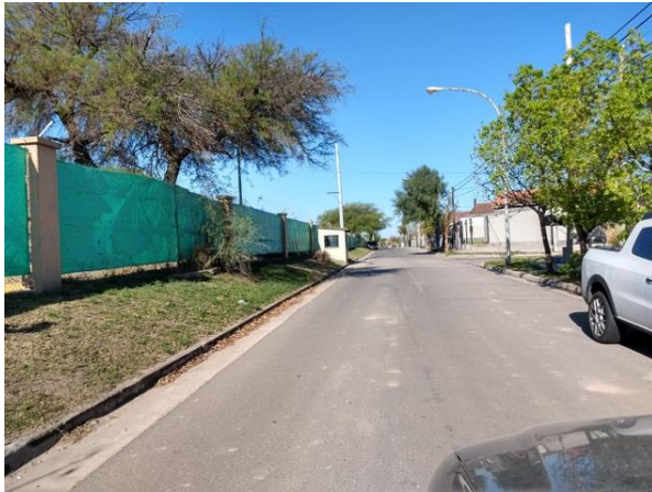
Fig. 96. [Vista perímetro Sur de Manantiales Country, sobre calle H. Juárez en relación con el barrio existente] Liborio, 2018
