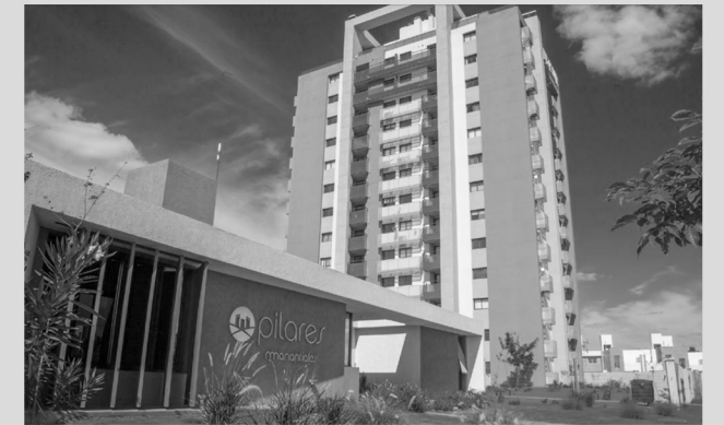
Portal de Ingreso
