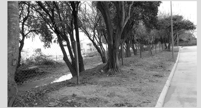
Delimitación Perimetral sobre Canal Maestro Sur
