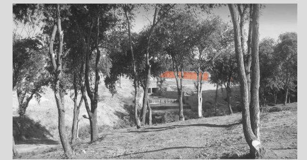
Delimitación Perimetral sobre Canal Maestro
