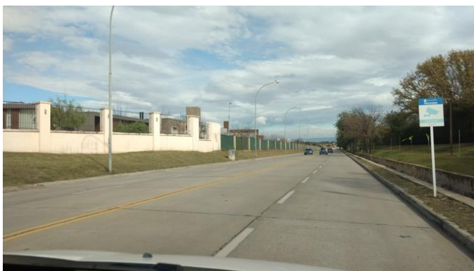
Fig. 98. [Vista perímetro Norte de Manantiales Country, sobre Av. de acceso] Liborio, 2018
