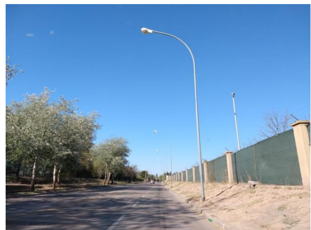
Fig. 62. [Pavimentación, iluminación y securitización de la av. de ingreso al sector] Liborio, 2016
