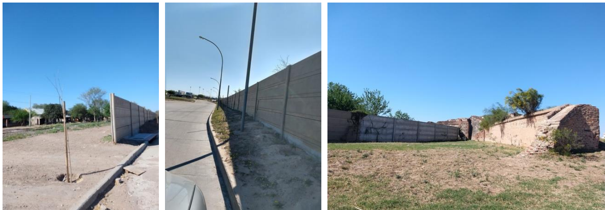
Fig. 90, 91 y 92. [Vistas de distintos tramos del muro sobre vías del ferrocarril] Liborio, 2018
