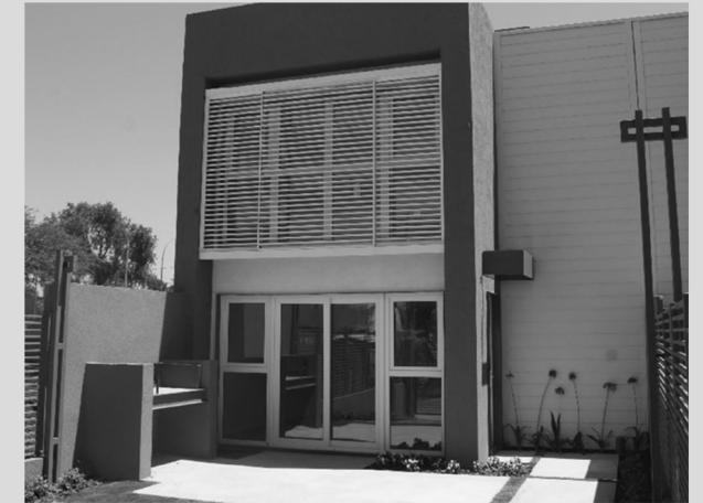
Patio Casas E
