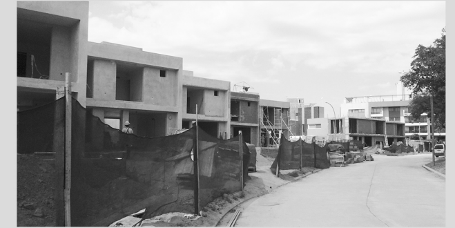
Casas Patio en Obra
