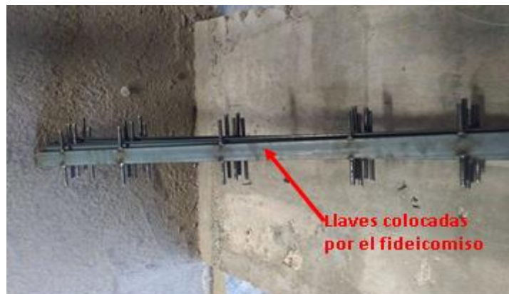
Figura 3.44. Llaves para sellar fisuras
