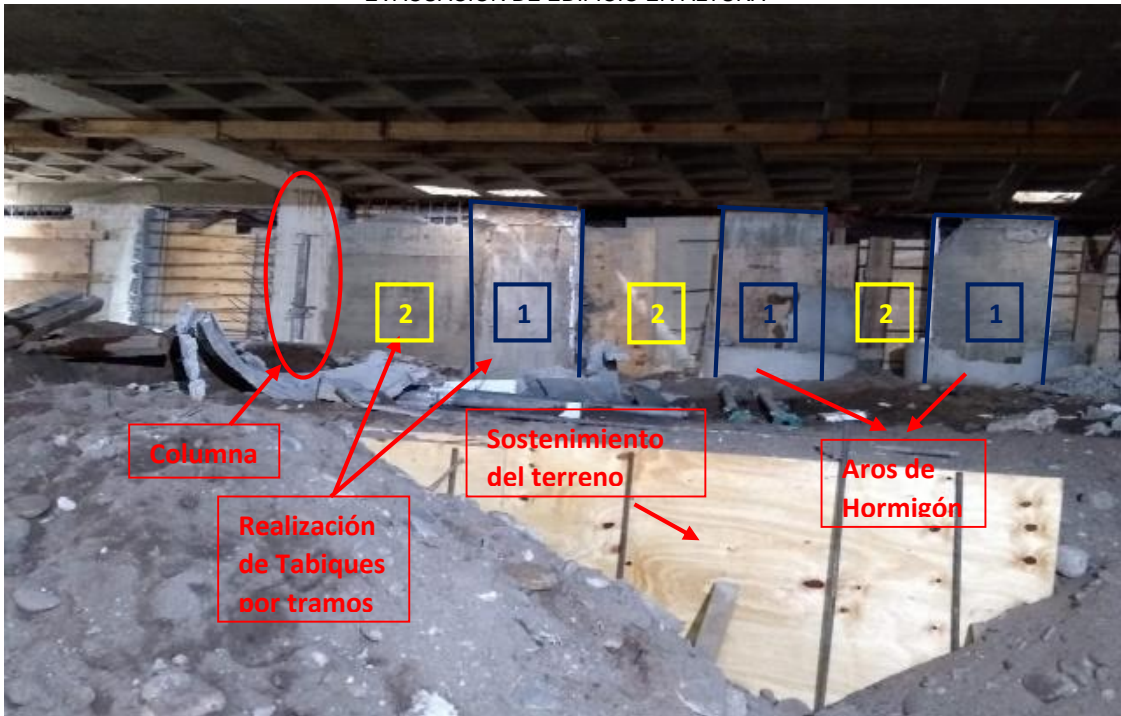
Figura 3.58. Ejecución de Tabiques
