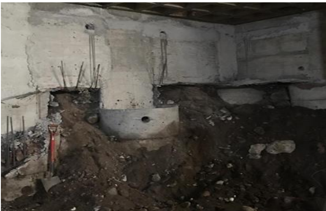
Figura 3.55. Excavación con aros de hormigón
