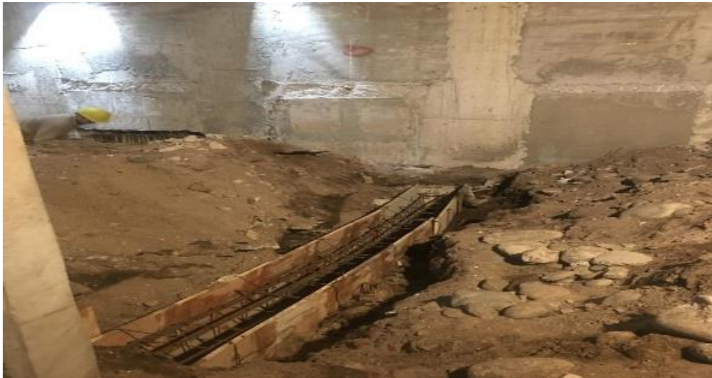
Figura 3.66. Encofrado Vigas Riostras. Hormigonado
