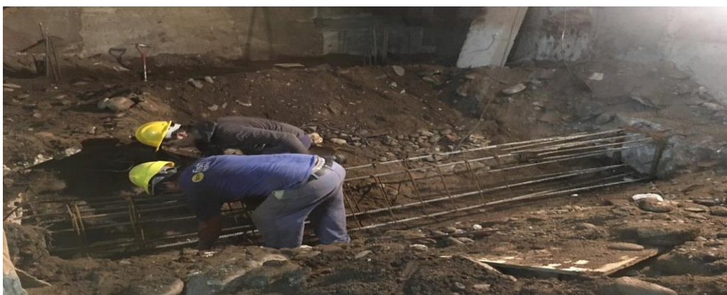
Figura 3.65. Armadura Vigas Riostras
