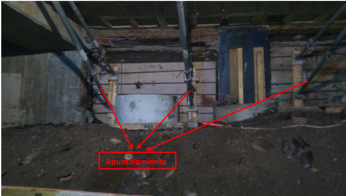
Figura 3.50. Apuntalamientos en Subsuelo LOBOS IV
