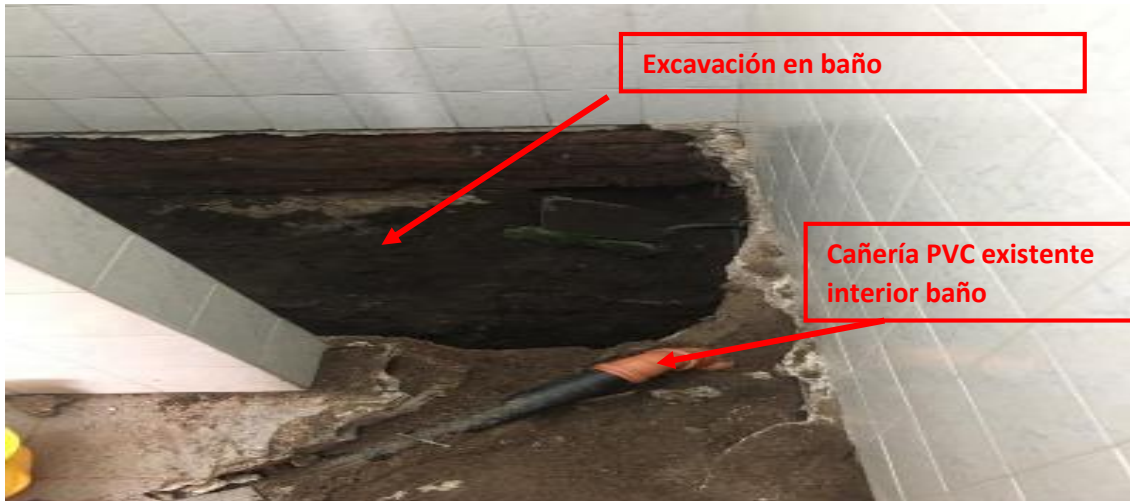
Figura 3.90. Excavación en baño iglesia. Submuración
