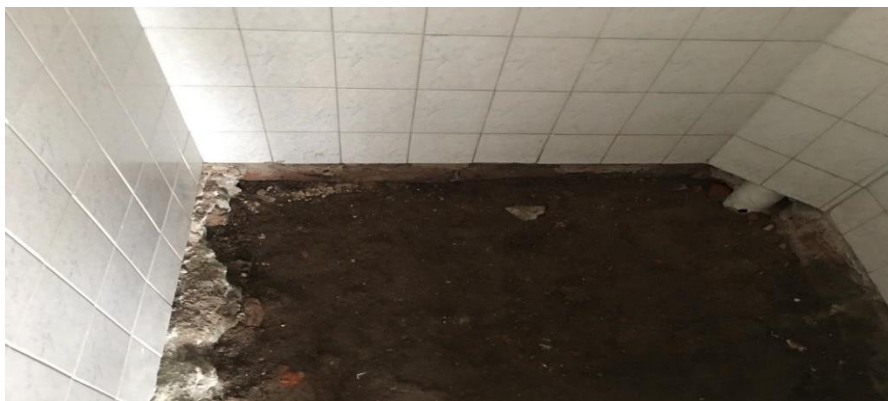
Figura 3.92. Relleno con suelo cemento. Compactación
