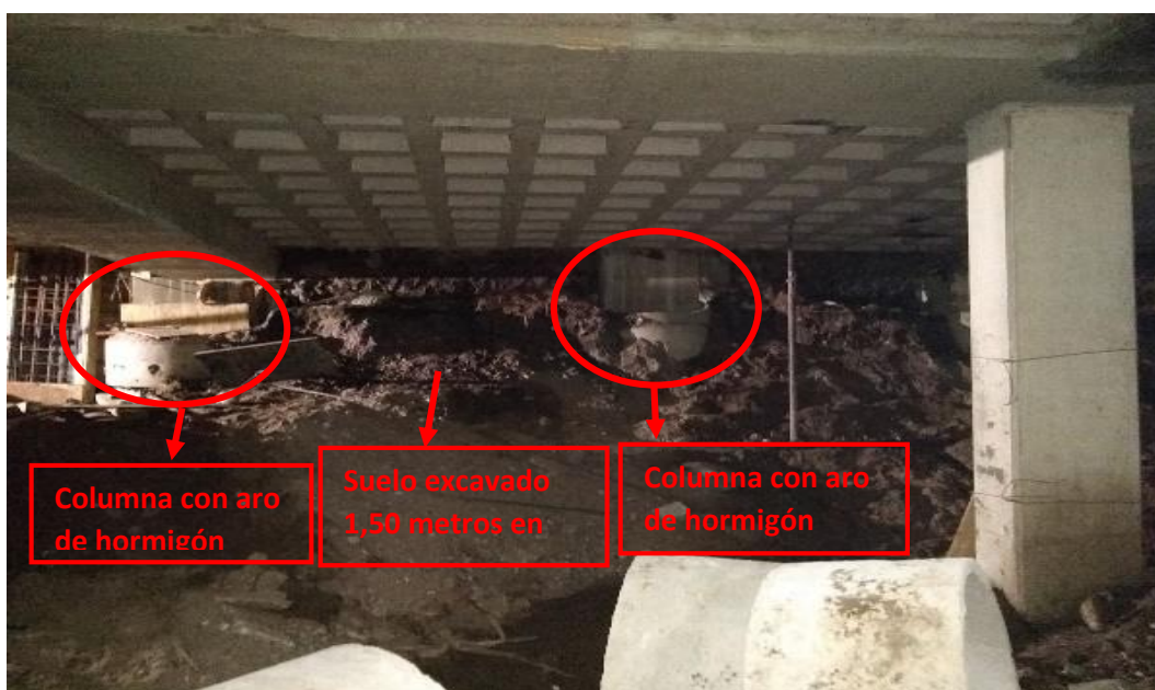
Figura 3.20. Situación previa a la realización de Tabiques.
