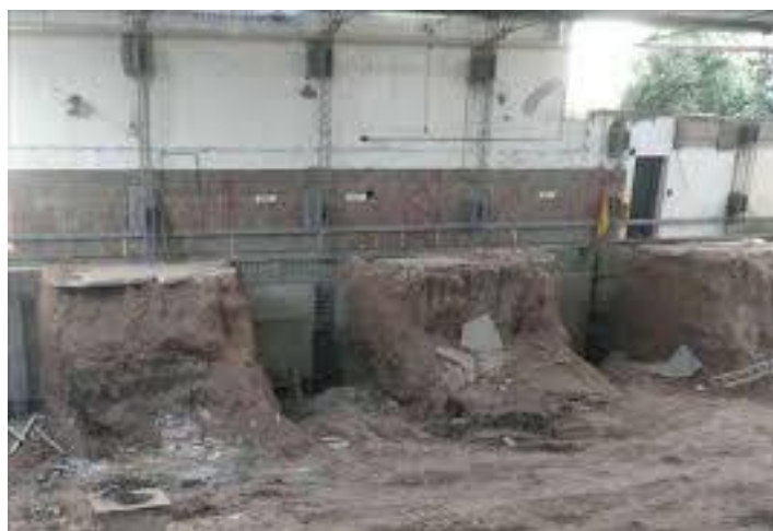
Figura 3.6. Excavación mediante Trincheras
