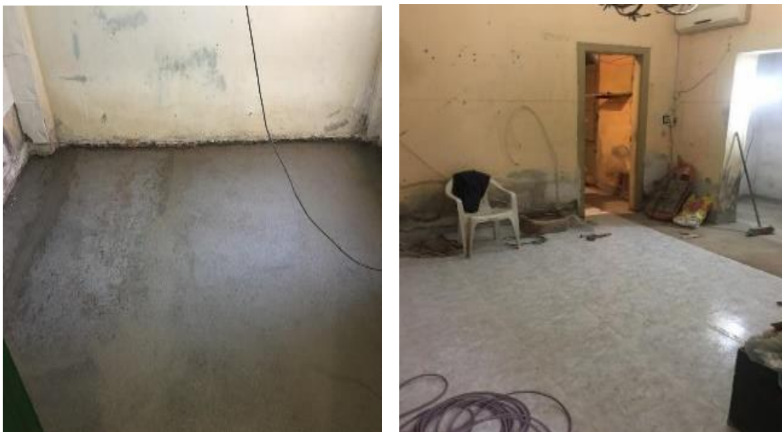
Figura 3.118. Contrapiso, carpeta y colocación de piso en Ambiente 1 y 2
