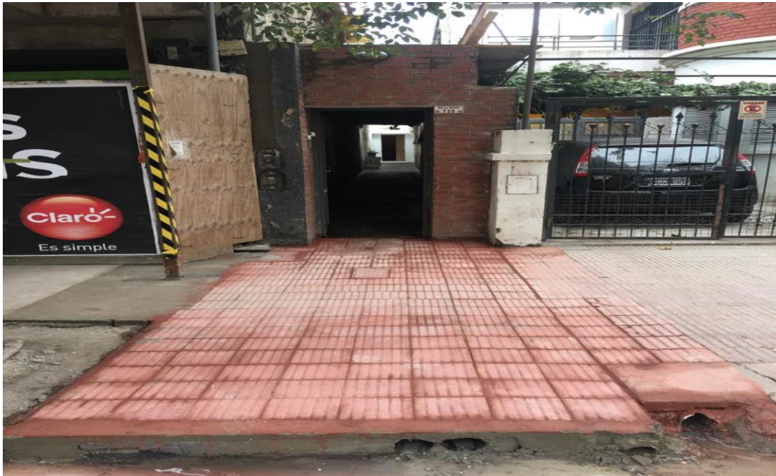
Figura 3.130. Colocación de Baldosas en vereda
