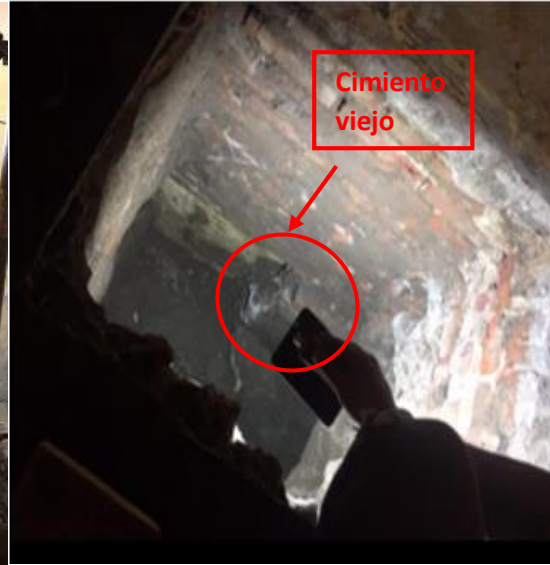
Figura 3.102. Excavación en esquina Amb.2 Farre
