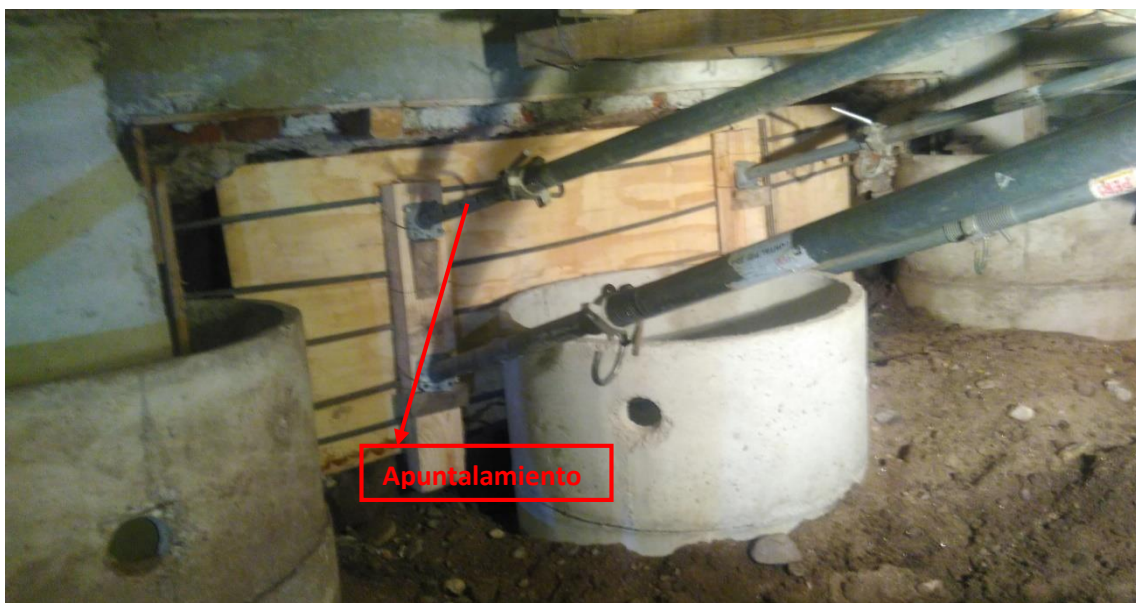
Figura 3.52. Apuntalamientos en Subsuelo LOBOS IV
