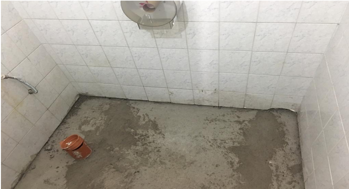
Figura 3.96. Realización de piso y contrapiso en baño
