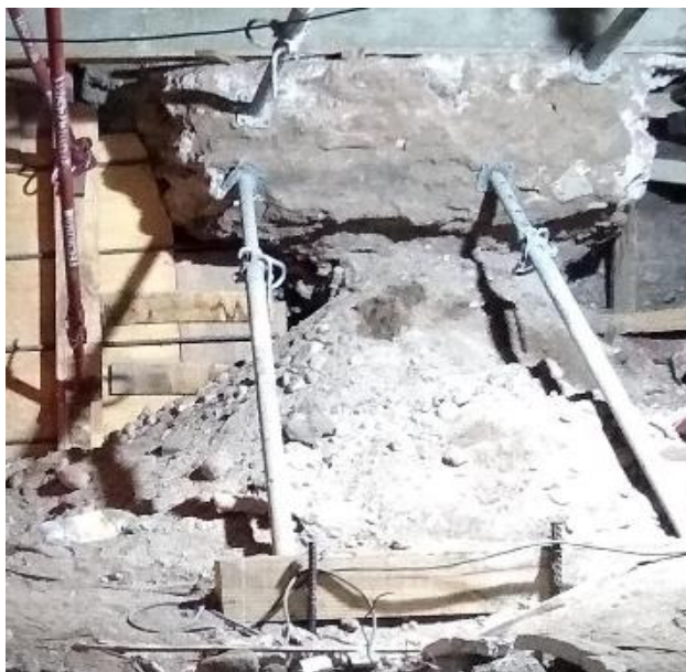
Figura 3.62. Cimiento existente apuntalado
