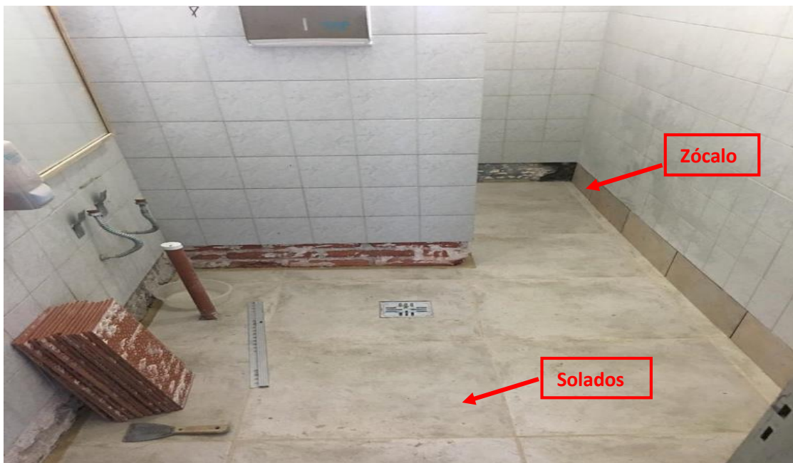
Figura 3.95. Solados y Zócalos en baño
