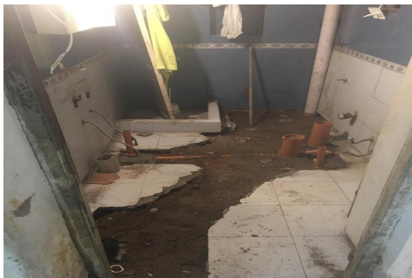
Figura 3.112. Cambio de cañerías. Relleno y compactación
