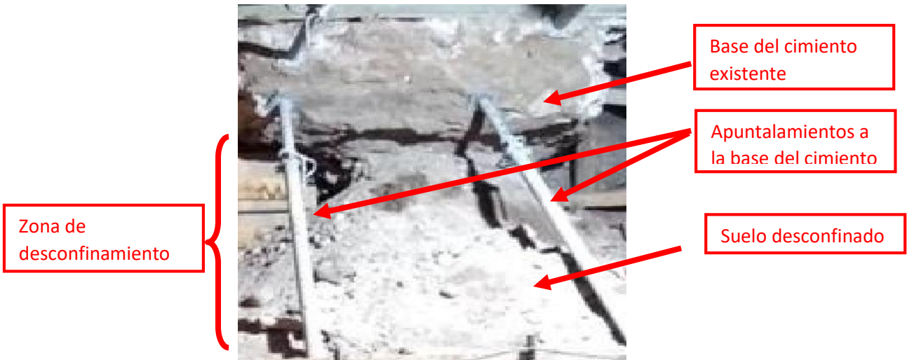
Figura 3.18. Desconfinamiento de suelos
