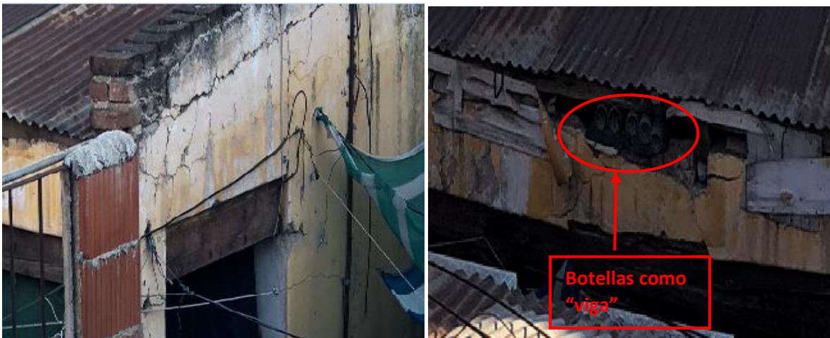
Figura 3.120. Situación previa a excavación en obra LOBOS IV
