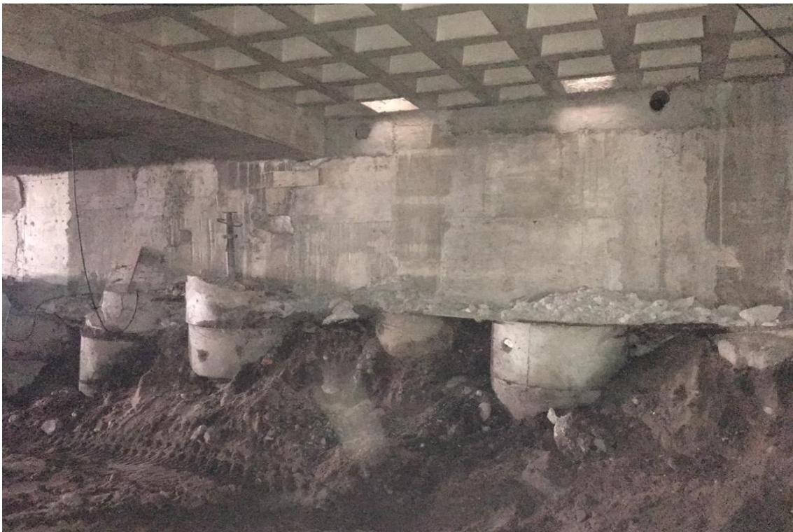
Figura 3.59. Primera etapa de Hormigonado de Tabiques
