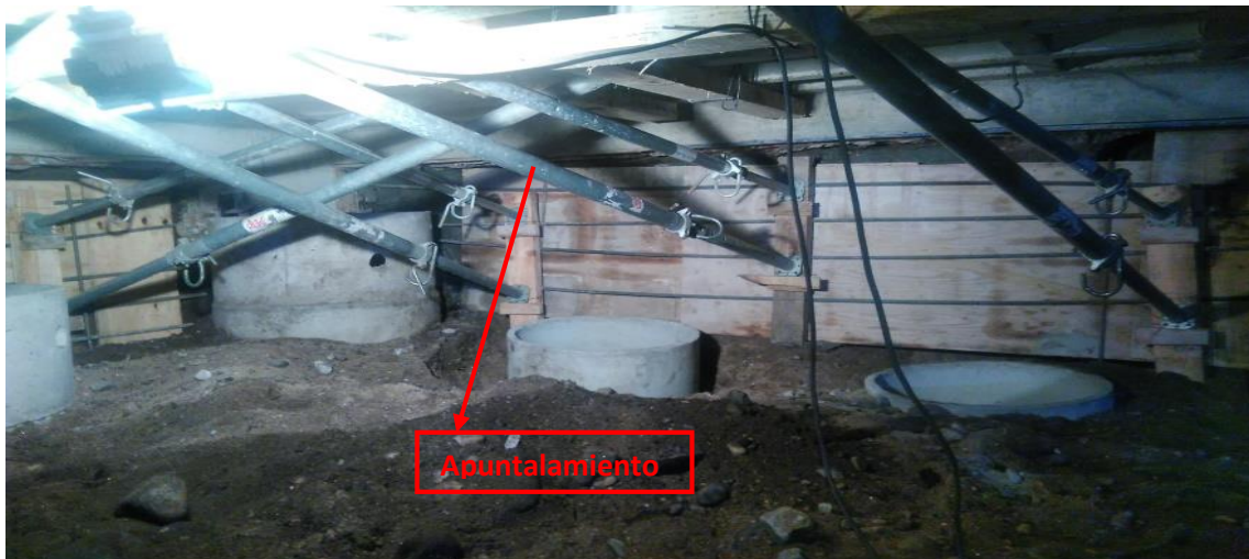
Figura 3.51. Apuntalamientos en Subsuelo LOBOS IV
