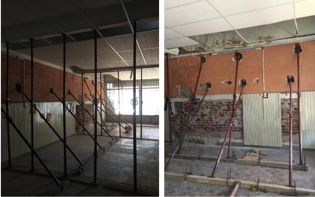
Figura 3.46. Apuntalamiento en Iglesia
