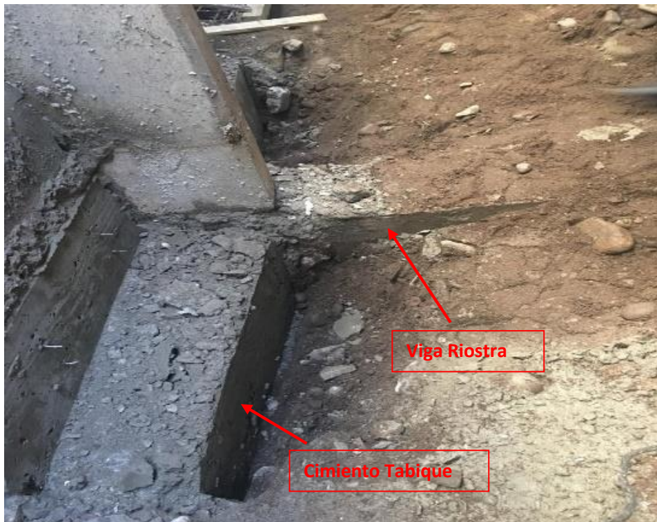
Figura 3.67. Viga Riostra hormigonada. Cimiento Tabique
