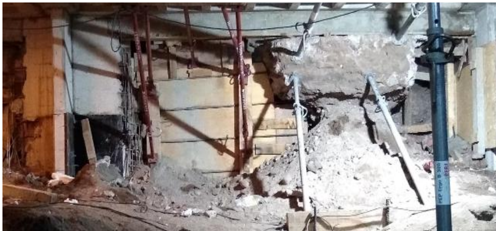
Figura 3.17. Desconfinamiento de suelos
