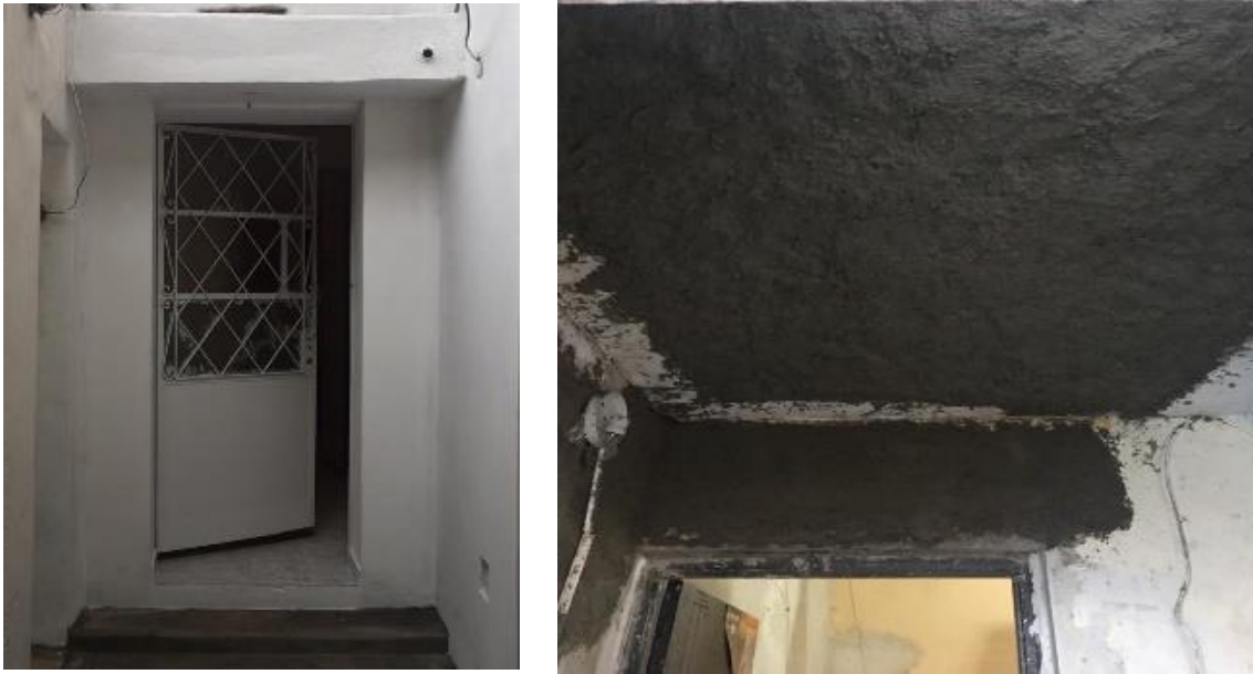
Figura 3.115. Reparaciones vivienda Farre
