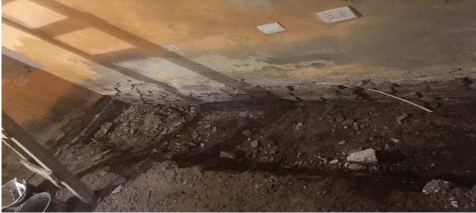
Figura 3.108. Relleno con suelo cemento en zona trabajada
