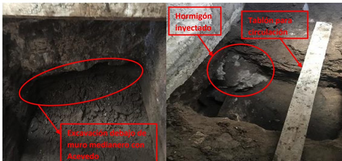
Figura 3.126. Excavación pasillo
