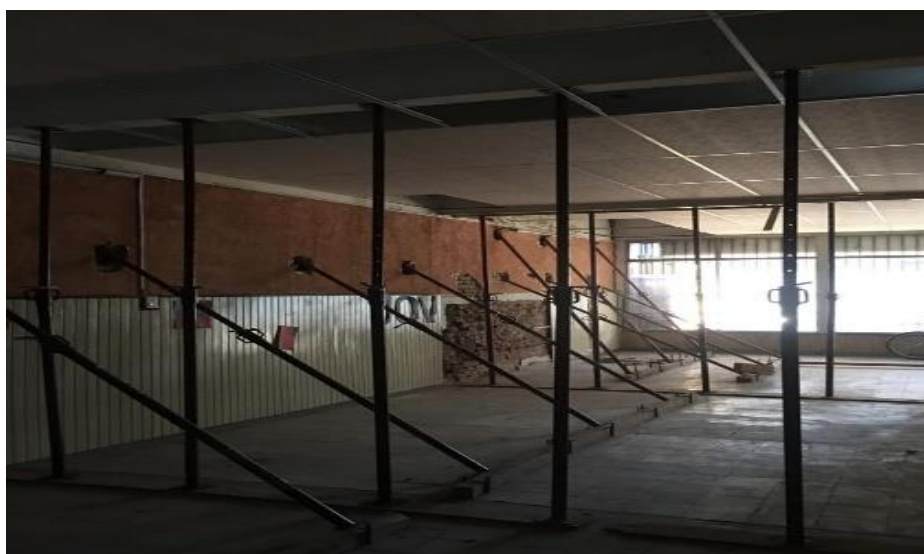
Figura 3.70. Primer Ambiente de Iglesia previo a submurarse
