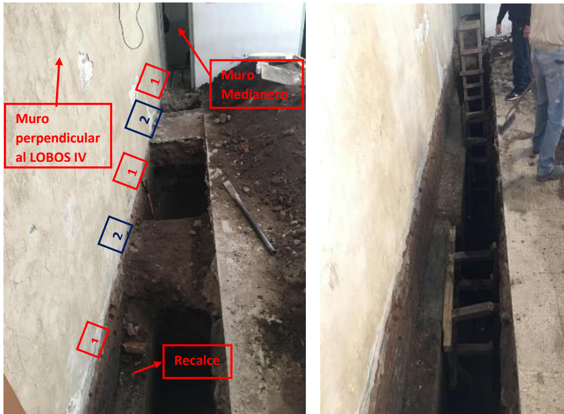
Figura 3.87. Submuración por tramos en Salón de Iglesia
