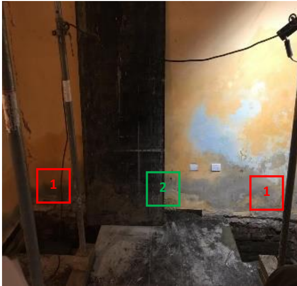
Figura 3.103. Excavación por tramos Amb.2 Farre
