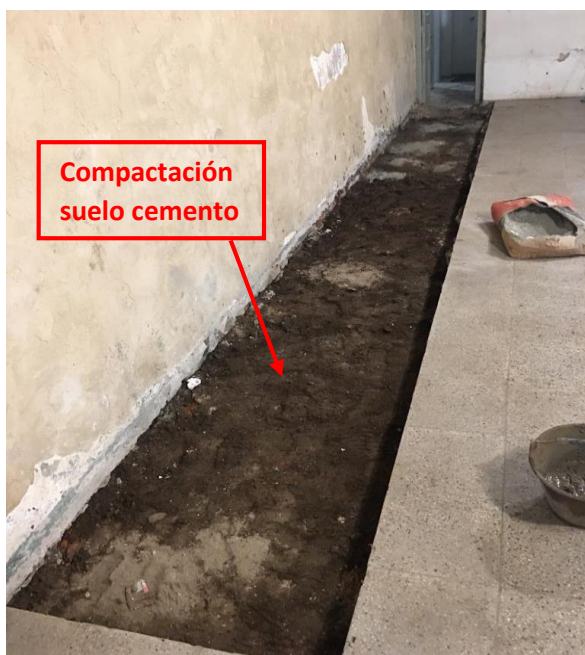
Figura 3.89. Relleno con suelo cemento. Compactación
