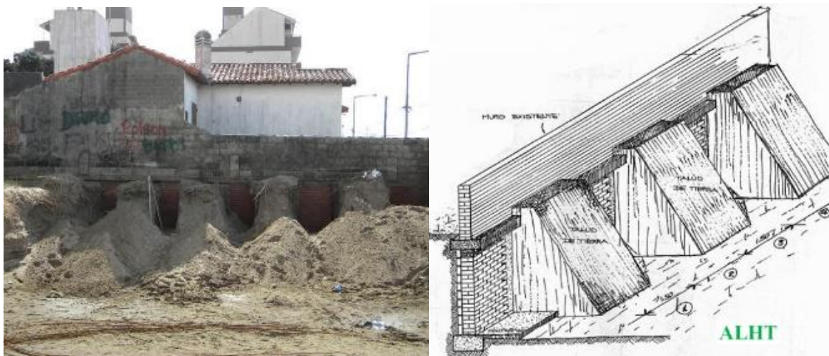
Figura 3.5. Excavación mediante Trincheras
