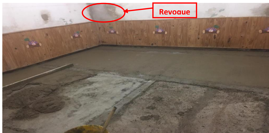
Figura 3.82. Ejecución de piso y Contrapiso en Ambiente 2
