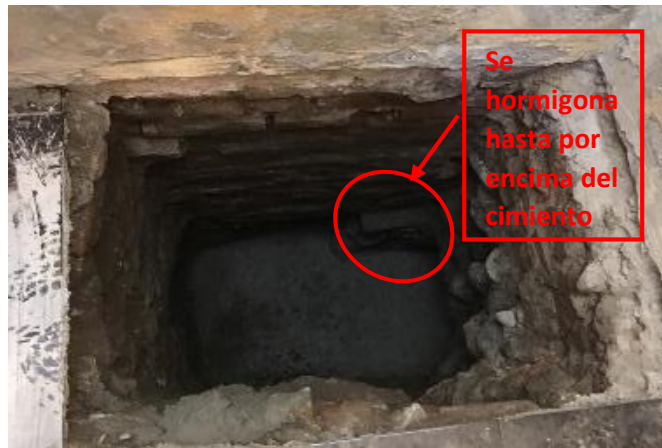
Figura 3.104. Etapa de Hormigonado
