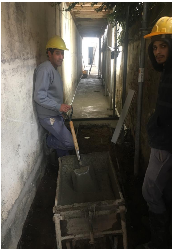
Figura 3.129. Ejecución de piso en pasillo de ingreso
