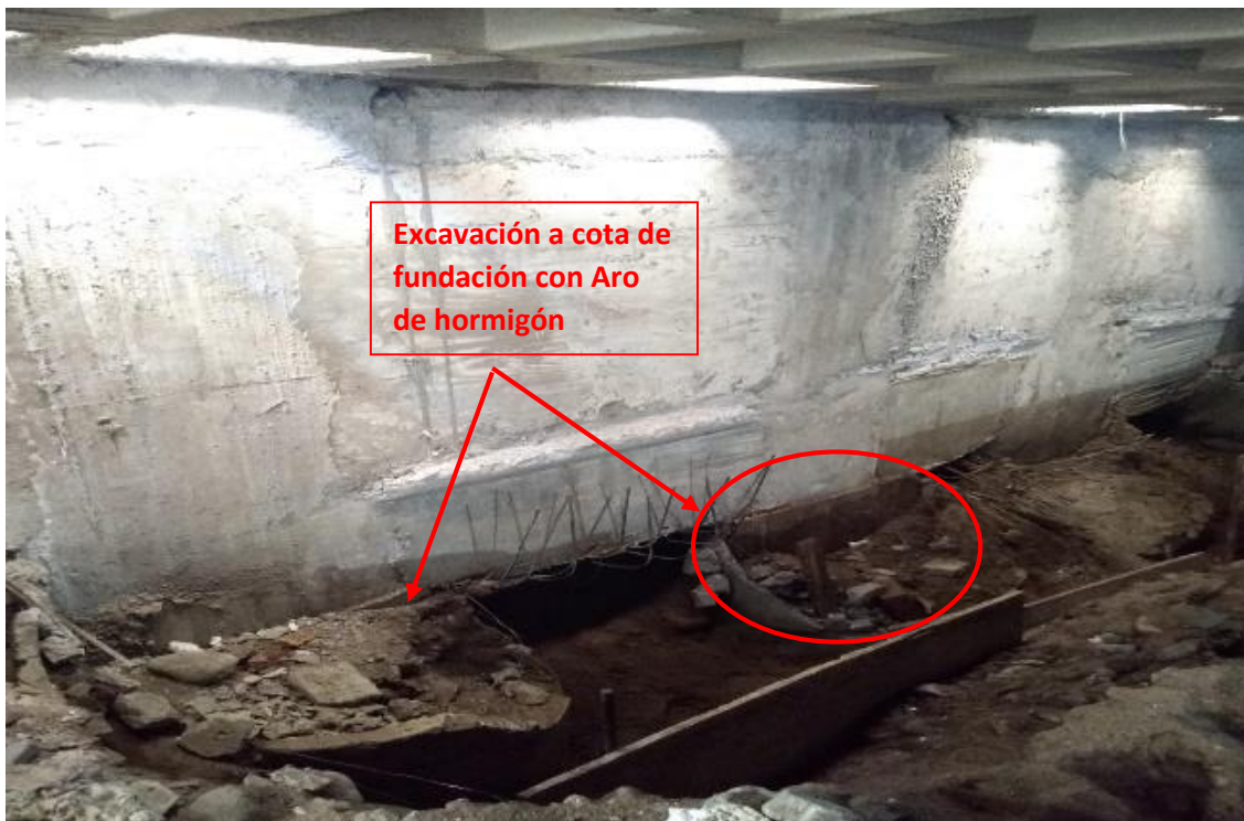
Figura 3.54. Excavación a cota de fundación
