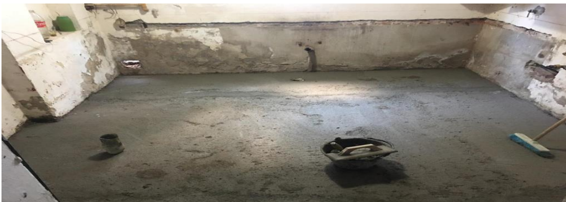
Figura 3.100. Trabajos en cocina
