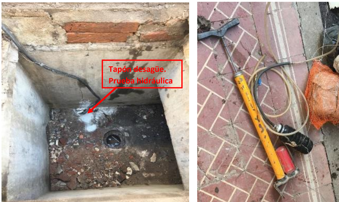
Figura 3.94. Prueba Hidraulica
