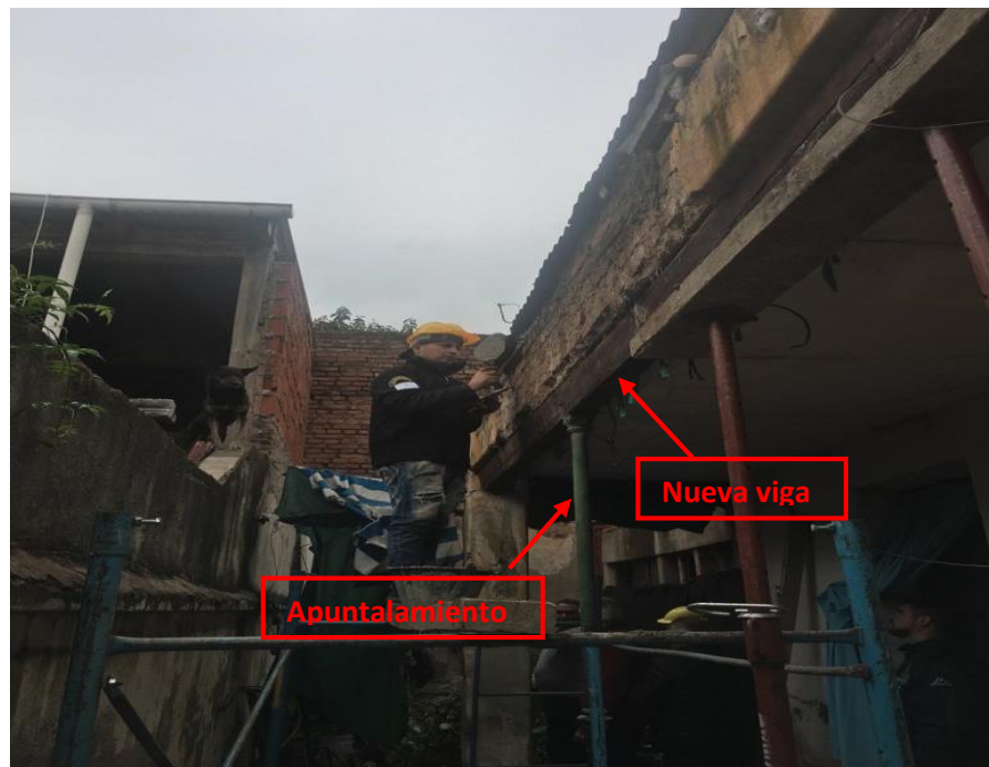
Figura 3.119. Trabajos en galería Mendoza
