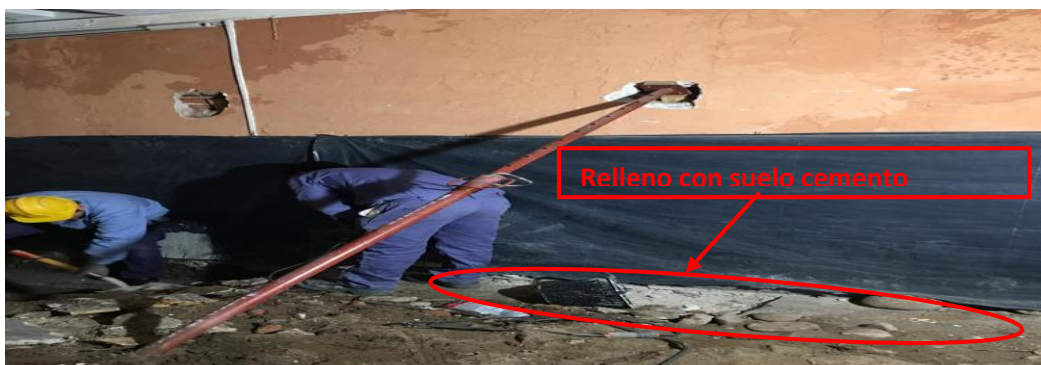
Figura 3.77. Relleno con suelo cemento
