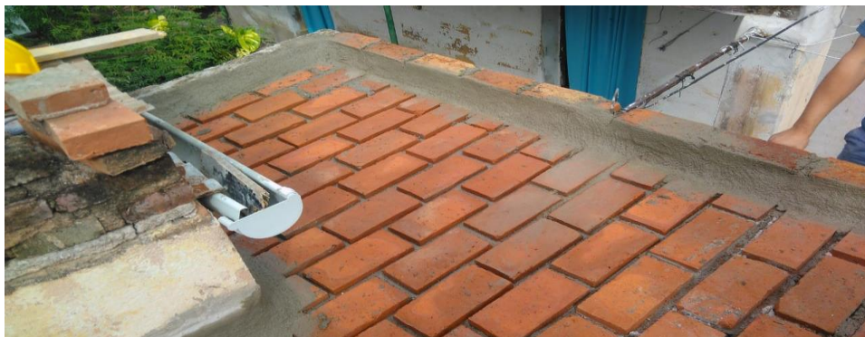
Figura 3.116. Cubierta de techo Farre
