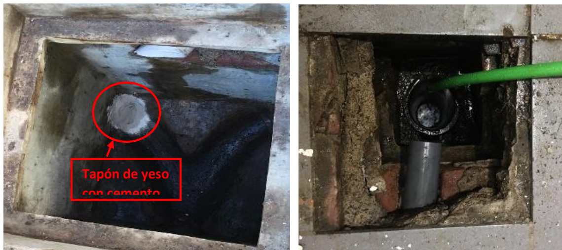
Figura 3.110. Prueba Hidraulica
