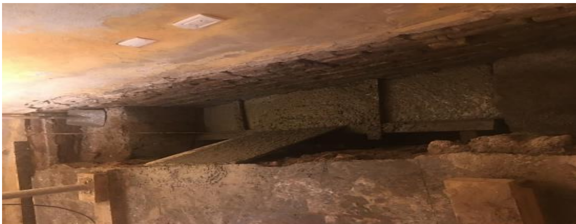
Figura 3.107. Hormigonado de la zona 2 en Ambiente. 2
