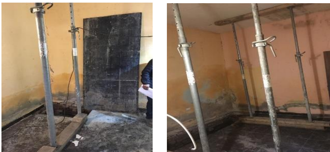
Figura 3.49. Apuntalamiento interior de vivienda Mirta Farre
