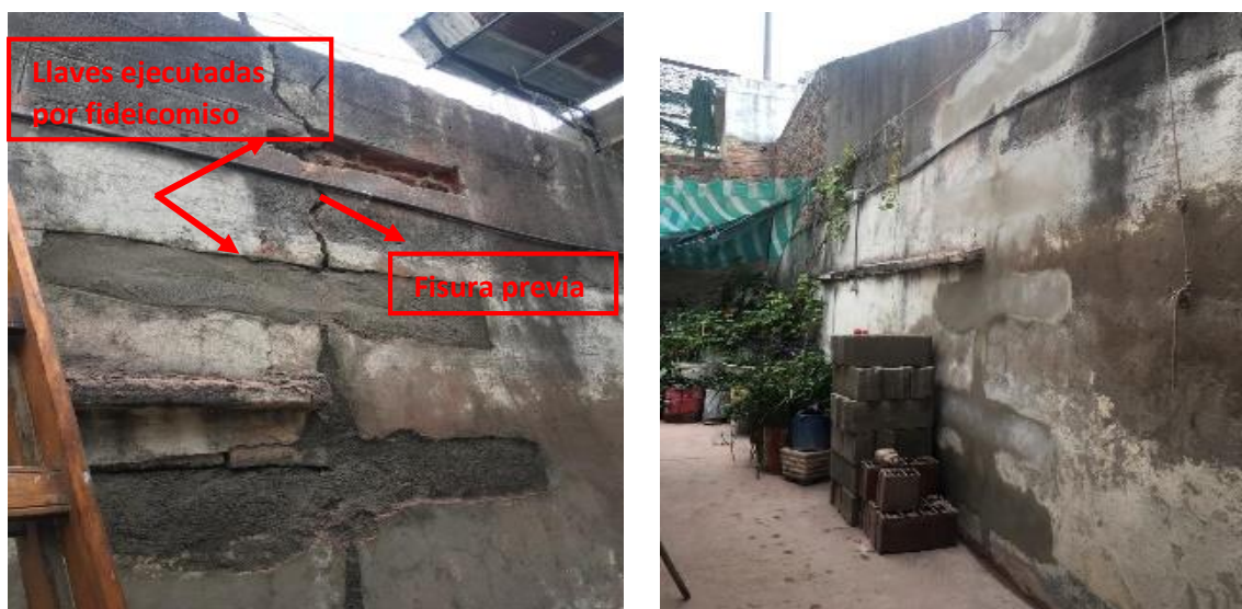
Figura 3.122. Colocación de llaves
