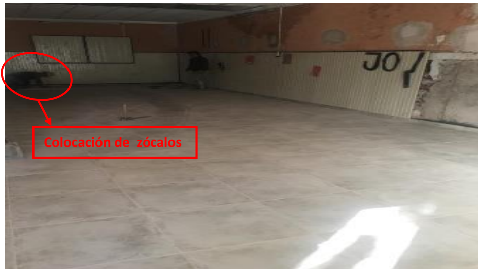
Figura 3.80. Pisos y zócalo Ambiente 1 iglesia
