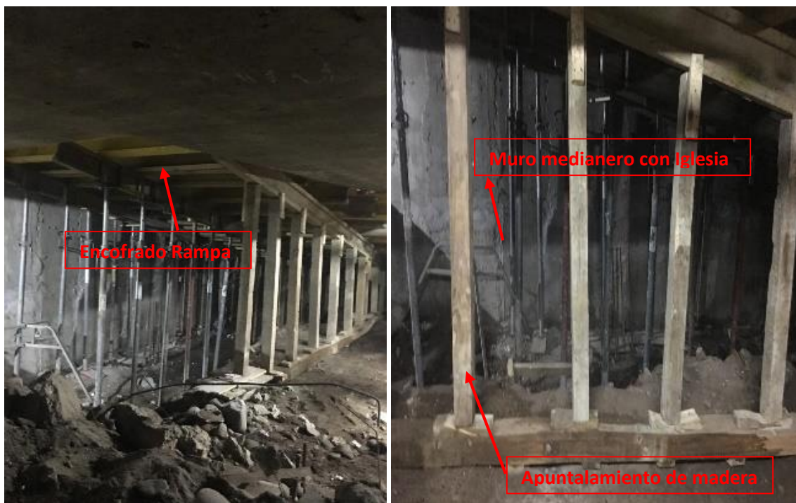
Figura 3.68. Rampa de vehículos
