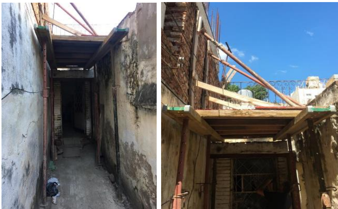
Figura 3.48. Apuntalamiento en Vivienda de Mirta Farre
