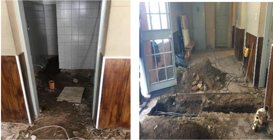
Figura 3.93. Trabajos en Baños y pasillo. Excavación
