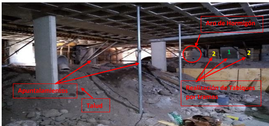
Figura 3.57. Ejecución de tabiques
