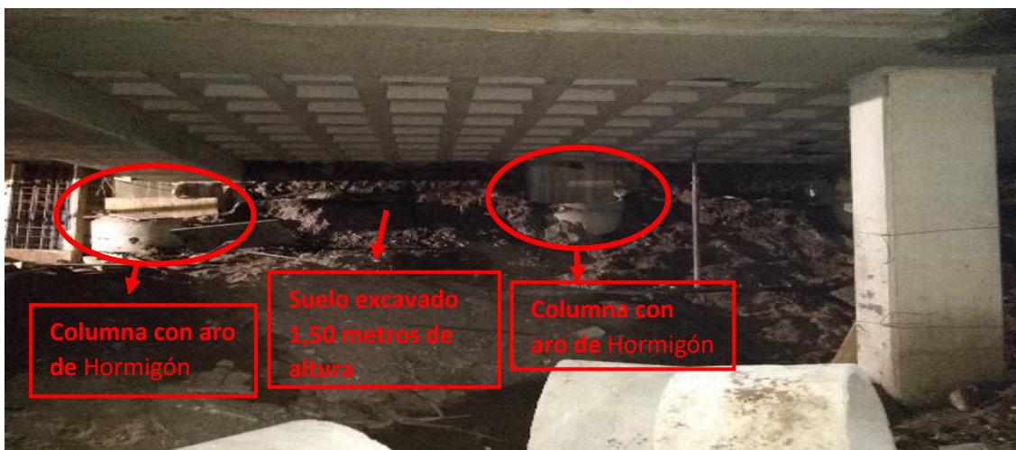
Figura 3.45. Situación previa a la realización de Tabiques.
