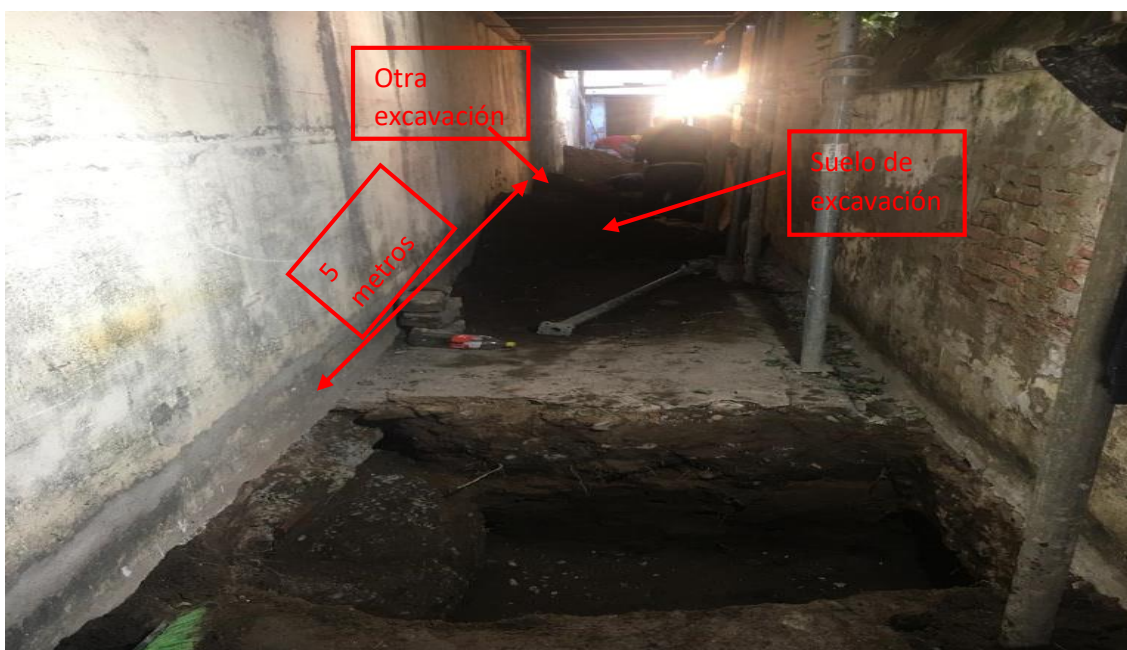
Figura 3.125. Excavaciones Pasillo de ingreso
