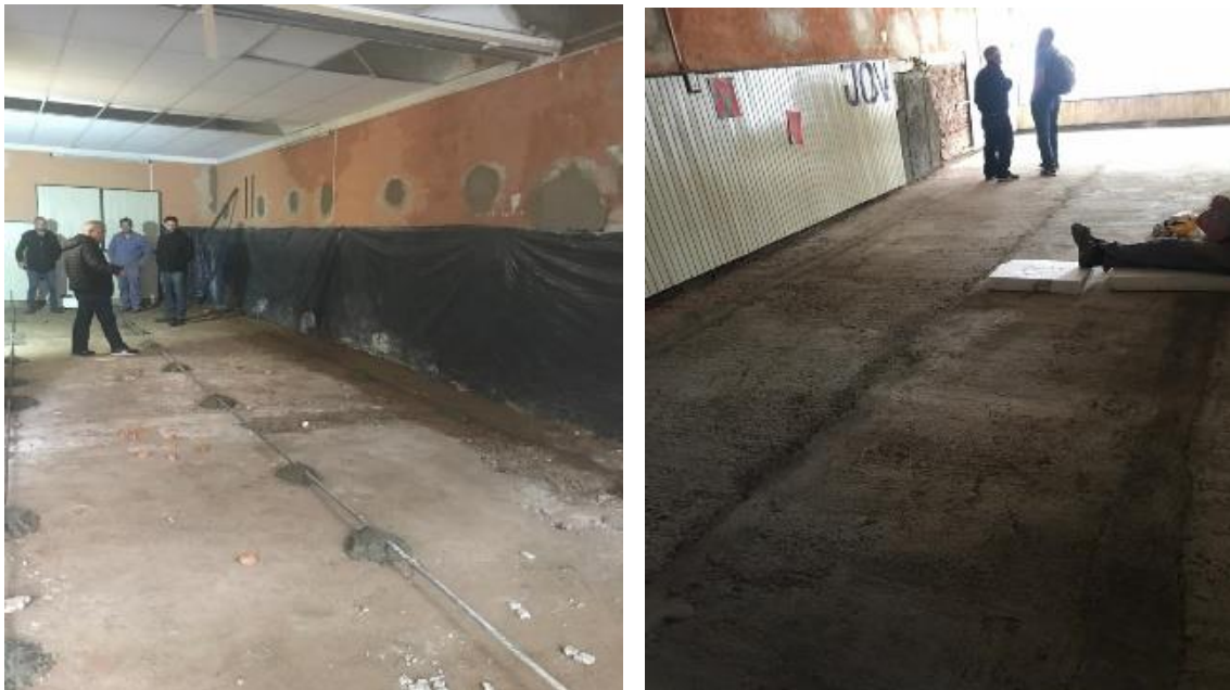
Figura 3.81. Ejecución de Contrapiso en Ambiente 1
