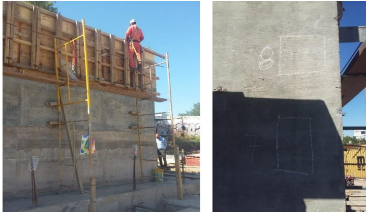
Figura 14: Estructura ensayada con el esclerómetro.
