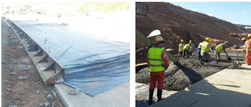
Figura 13: Hormigonado de calzadas.
