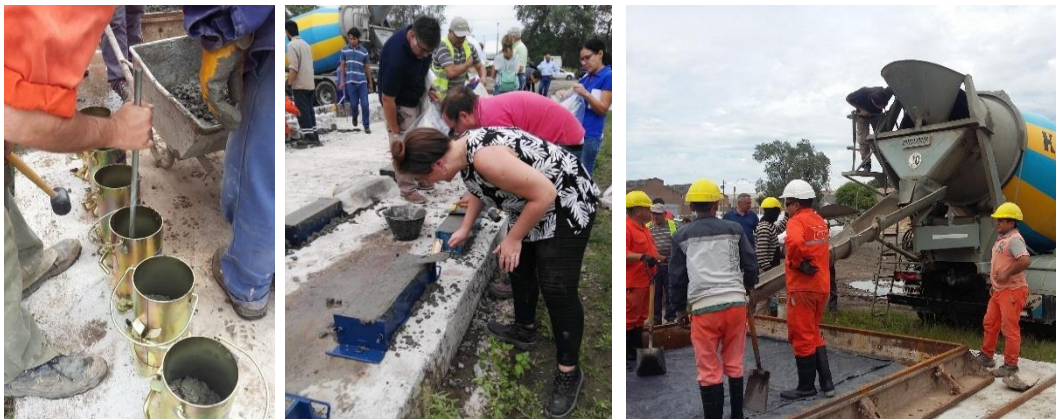
Figura 16: Moldeo de probetas cilíndricas y prismáticas. Hormigonado de calzada de 3m x 3m.
