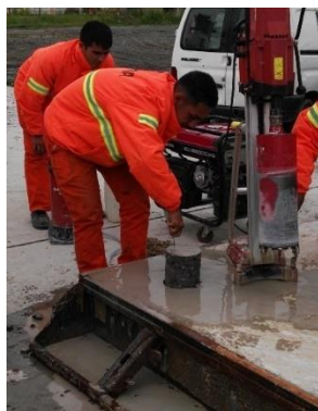
Figura 17: Extracción de testigos de hormigón
