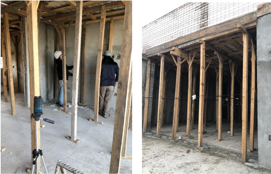
Figura N° 43 - Disposición final de puntales, previo a hormigonado.
