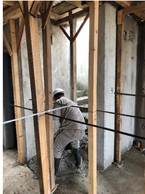
Figura N° 24 - Bombeado de hormigón a losa, distribución de hormigón en escalera.
