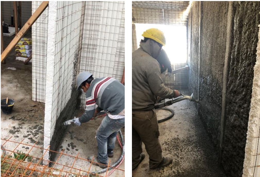
Figura N° 47 - Prueba de maquinaria ofrecida por Weber y continua por vía.
