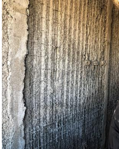
Figura N° 29 – Fajas guía para revoque.
