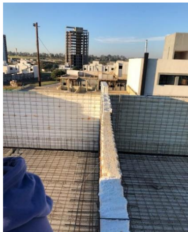
Figura N° 25 - Paneles previamente y posteriormente al llenado de capa de compresión.
