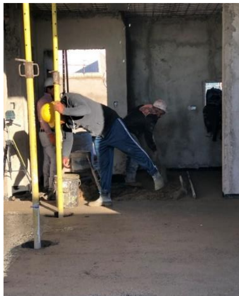
Figura N° 22 - Distribución de la mezcla sobre contrapiso.
