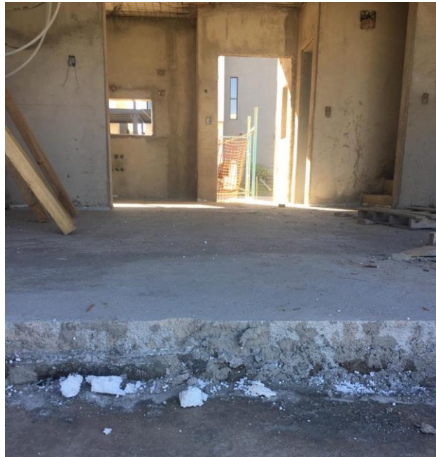
Figura N° 27 - Carpeta de nivelación terminada.
