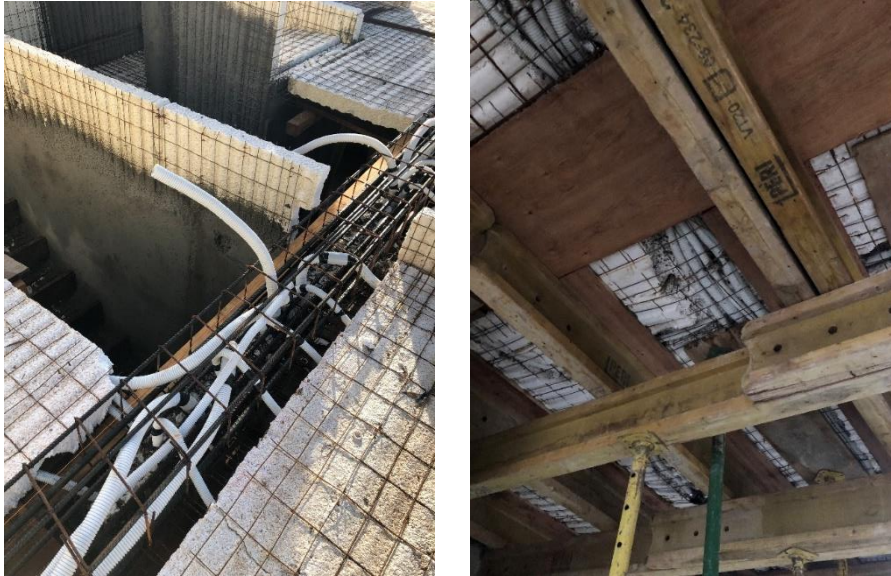
Figura N° 38 - Control de paso de cañerías corrugadas por losa.
