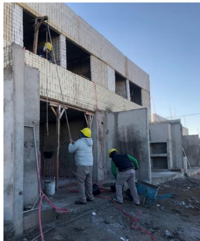
Figura N° 28 – Izado de mezcla al primer piso.
