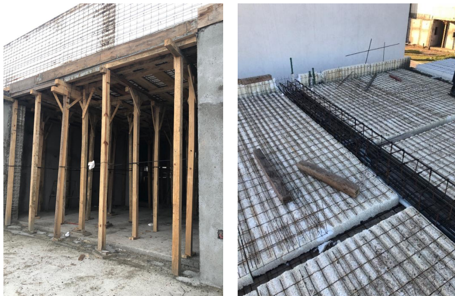
Figura N° 23 - Disposición de puntales y armado de viga.
