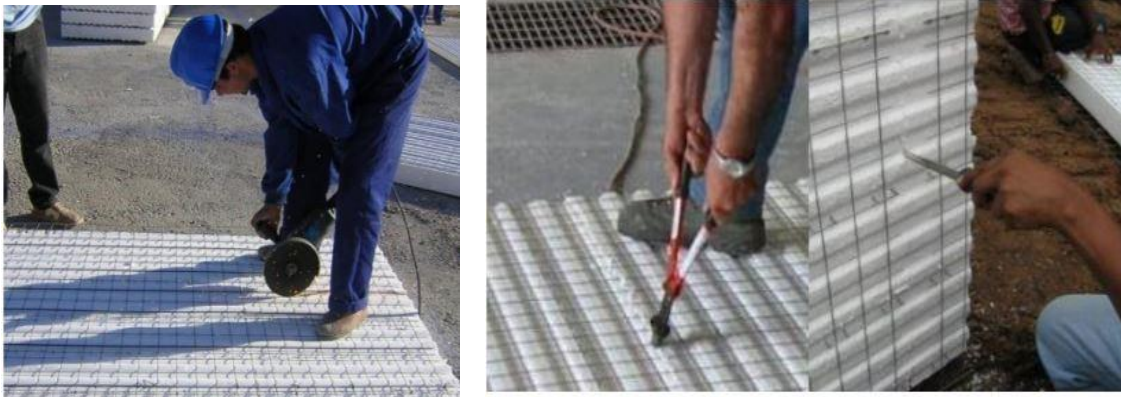
Figura N° 14 - Corte de panel con distintas herramientas.
