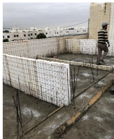
Figura N° 25 - Paneles previamente y posteriormente al llenado de capa de compresión.
