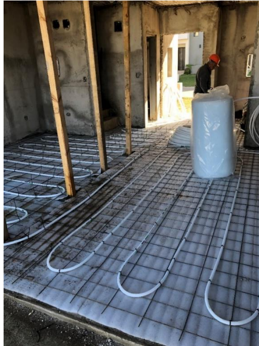
Figura N° 26 - Disposición inicial de losa radiante.
