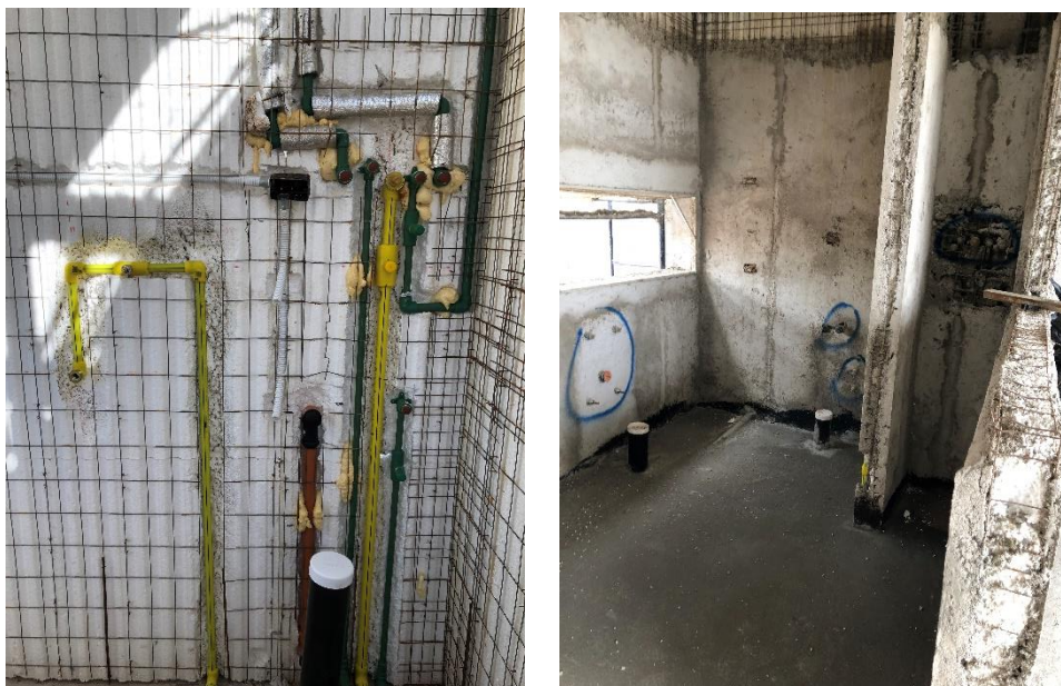
Figura N° 36 - Control de instalaciones de agua y gas.
