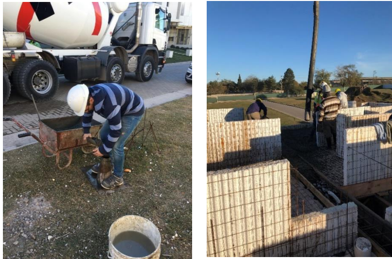
Figura N° 44 - Control de cono de Abrams y control de llenado de losa.
