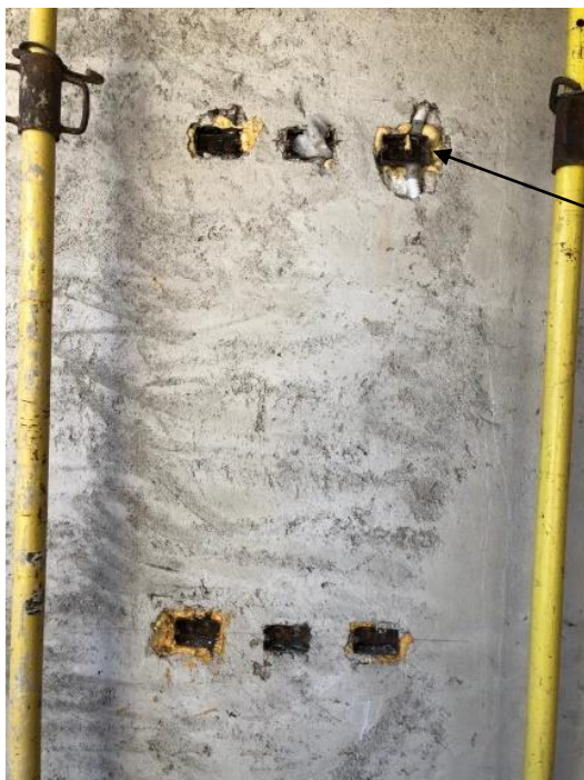
Figura N° 39 - Tomacorrientes corregidos con Sikaboom.
