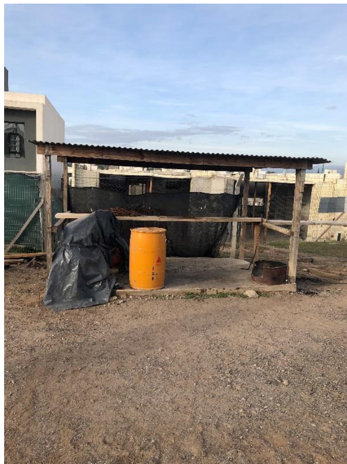
2 - Mesa de doblado de barras de acero.
