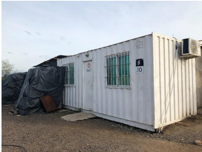
1 - Oficina técnica en obrador.
