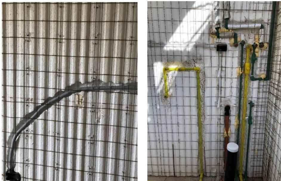
Figura N° 17 - Disposición de cañerías corrugadas y rígidas.
