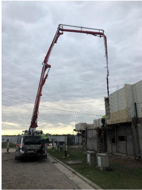
Figura N° 24 - Bombeado de hormigón a losa, distribución de hormigón en escalera.
