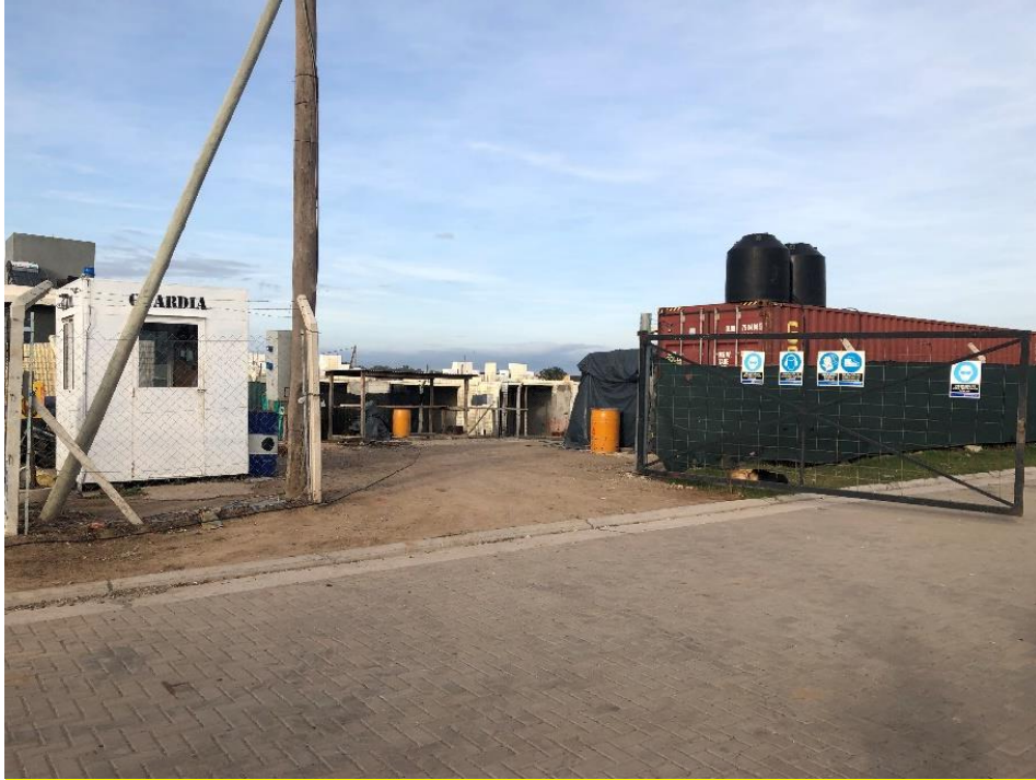
5 - Entrada al obrador, casilla de seguridad.
