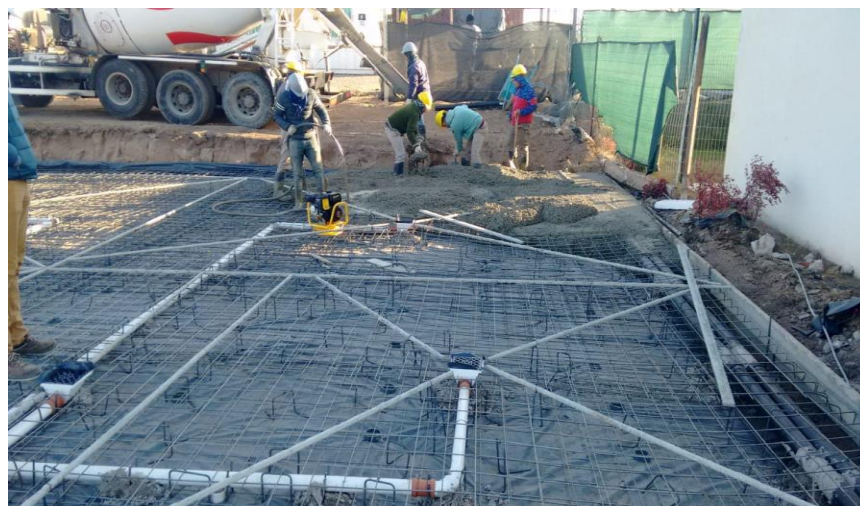
Figura N° 11 - Hormigonado de platea.
