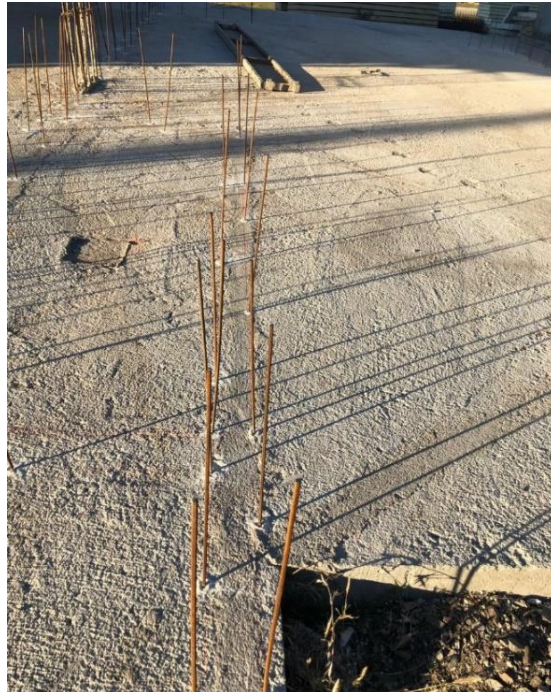
Figura N° 12 - Varillas de anclaje en platea.
