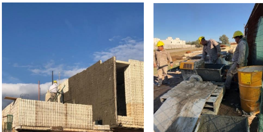
Figura N° 49 - Operarios proyectando cara externa de vivienda con maquinaria Turbosol.
