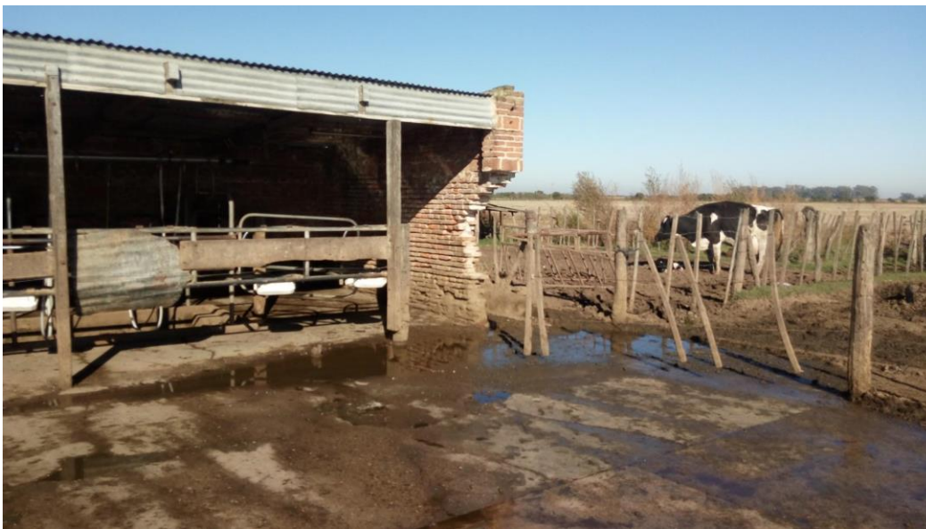
Figura 20. Corral de espera tambo N° 2 (piso de cemento, no ranurado, corrales de boyero eléctrico, sin ventilación, sombra, ni aspersión y mala condición general).
