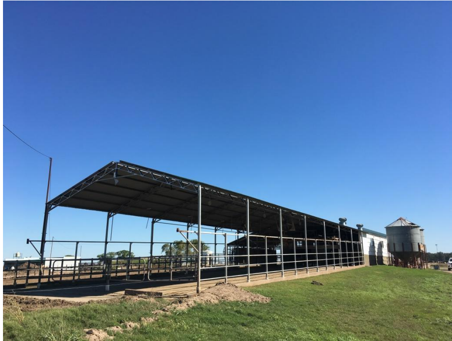
Figura 21. Corral de espera tambo N° 6 (piso de cemento, ranurado, con sombra, corrales de caño galvanizado, con ventilación, con aspersion y puerta arreadora automática).
