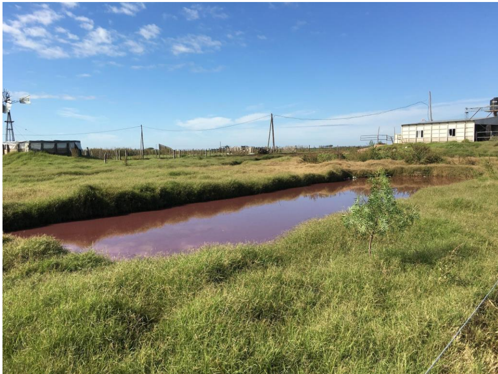
Figura 8. Distancia no adecuada entre la sala de ordeño y el sistema de tratamiento de efluentes en el establecimiento N° 14.
