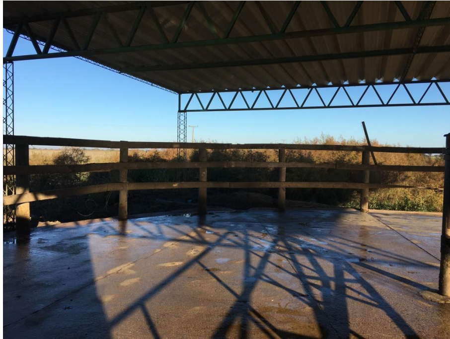
Figura 19. Corral de espera tambo N° 1 (piso de cemento, no ranurado, con sombra, corrales de madera, sin ventilación, ni aspersión).
