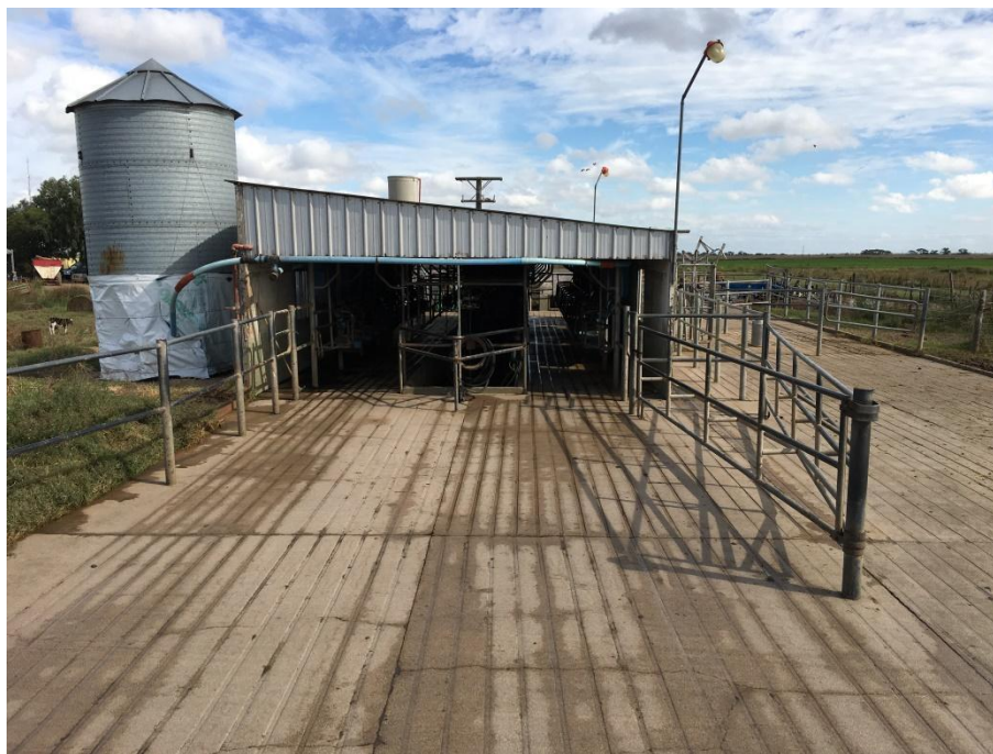
Figura 18. Corral de espera tambo N° 10 (piso de cemento, ranurado, corrales de caño galvanizado, sin sombra, ventilación, ni aspersión).
