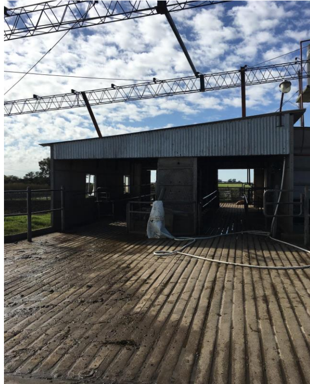
Figura 17. Corral de espera tambo N° 14 (piso de cemento, ranurado, corrales de caño galvanizado, sin sombra, ventilación, ni aspersión).
