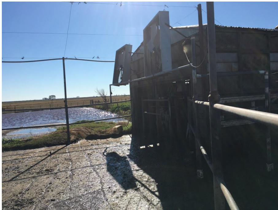
Figura 22. Sistema de ventilación en el corral de espera (tambo N° 3).
