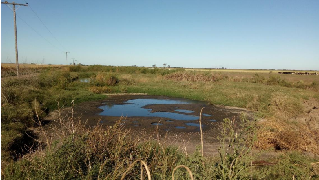
Figura 25. Lagunas de estabilización en tambo N° 8.
