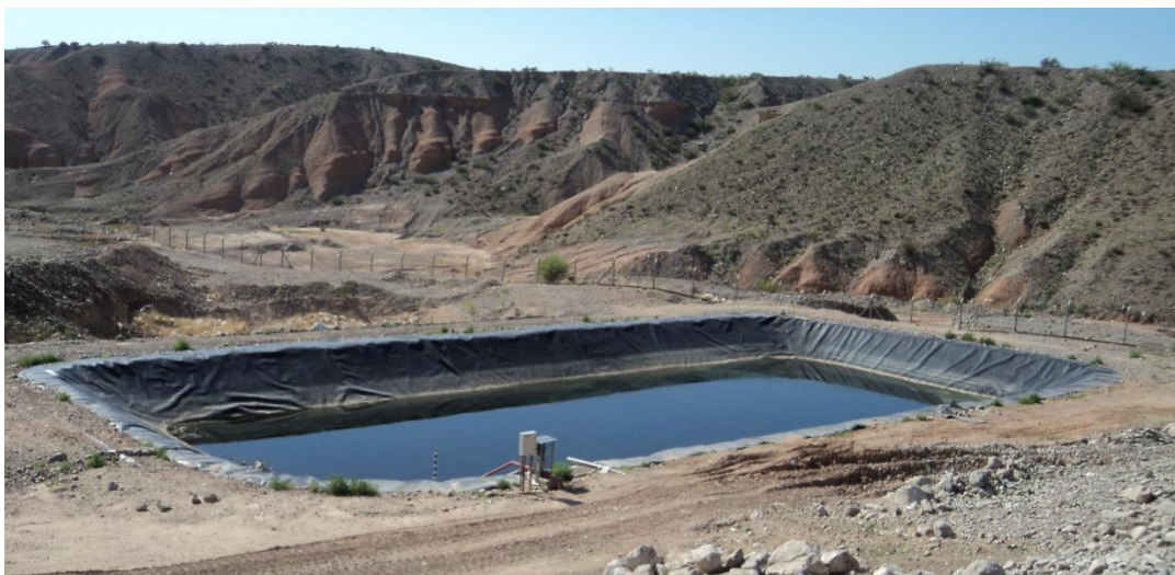
Imagen 4.29. Pileta de recolección de lixiviados.
