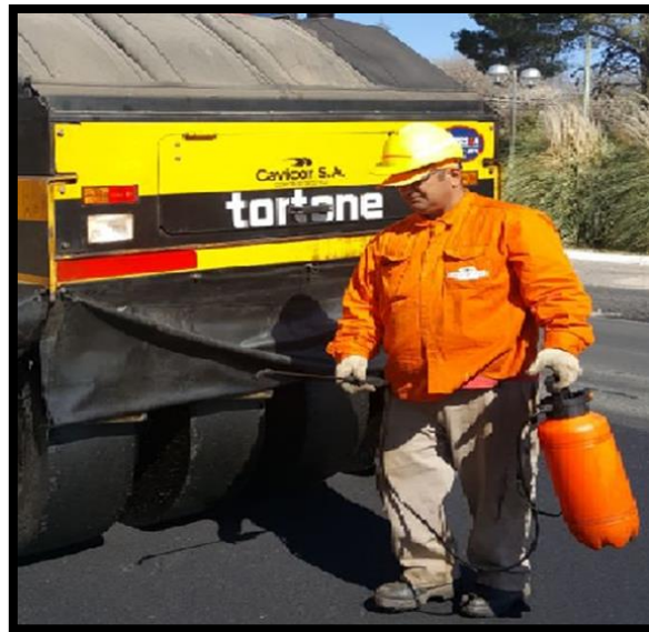
Imagen 4.26-Control de rodados de compactación
