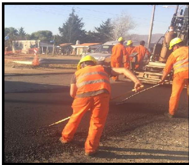
Imagen 4.25-Distribucion de mezcla asfáltica con rastrillado
