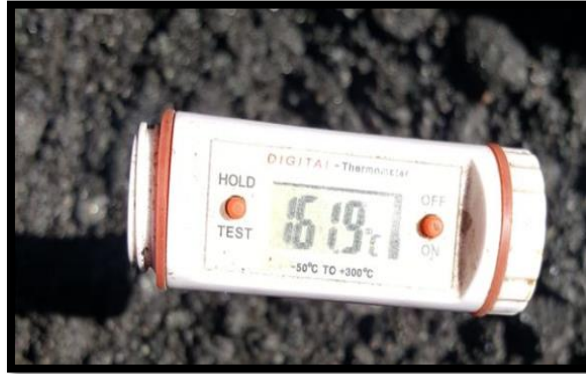
Imagen 4.23- Control de temperatura en obra
