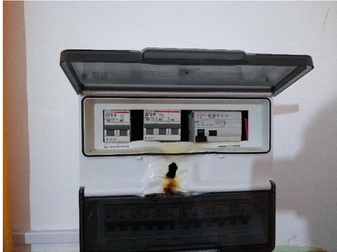
Tablero Seccional de Aires Acondicionados. Se quemó por dos posibles causas:
