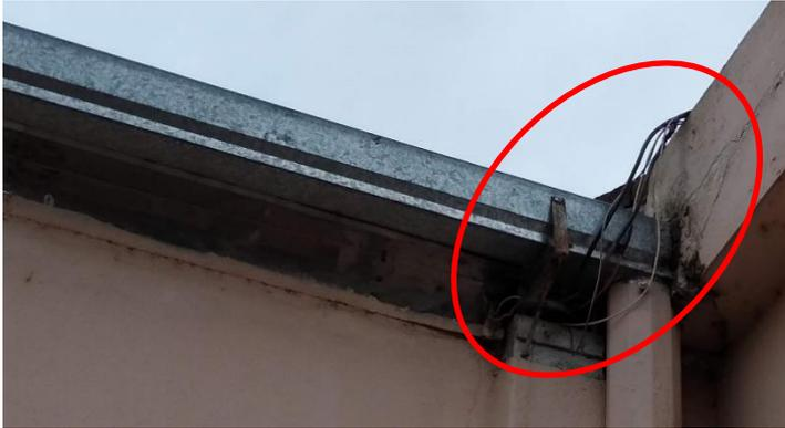
Cables exteriores sin canalización en contacto con elementos metálicos. Mayor deterioro de los cables. Probabilidad de electrocución a la hora de hacer limpieza/mantenimiento de canaletas.
