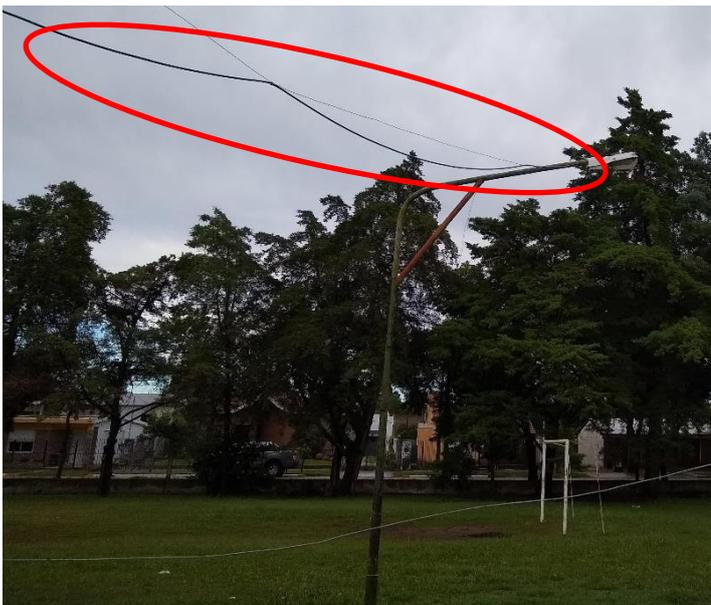
Cable aéreo que alimenta a una farola en el patio. Debería ser subterráneo para mayor seguridad. No cuenta con canalización. La farola se va a cambiar por un reflector, ya que cualquier fallo en la aislación del conductor, puede causar "masa" en el poste metálico. El farol se encuentra en una zona de circulación a la hora de jugar en el patio.
