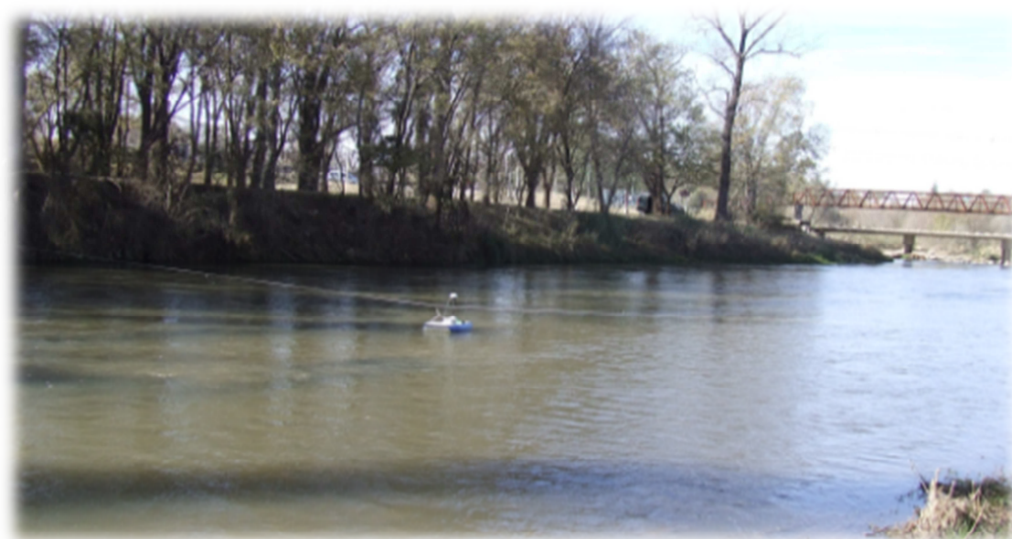
Figura 3.3. Balneario de la ciudad de Río Tercero.
