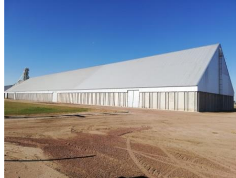
Figura 4: Celda de almacenamiento Vista Externa.
