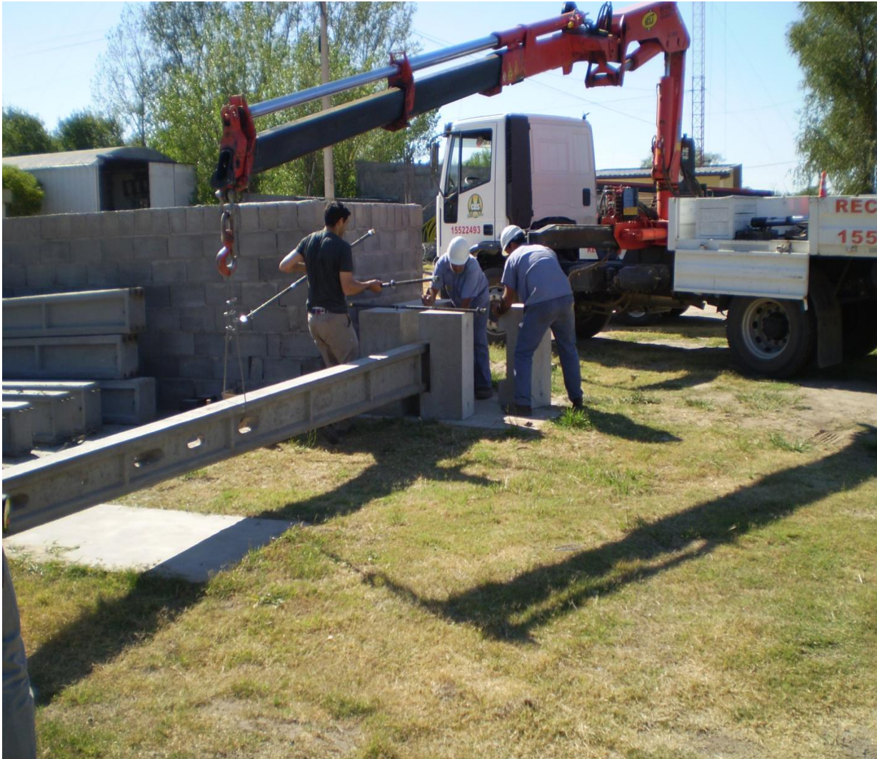
Figura 5.3 Fijación de los postes en la base de empotramiento.
