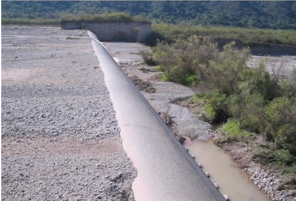
Figura 6. Fotografía dique fijo.
