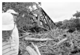
Ayer comenzaron los trabajos para remover el puente ferroviario, arrastrado por la crecienta.
