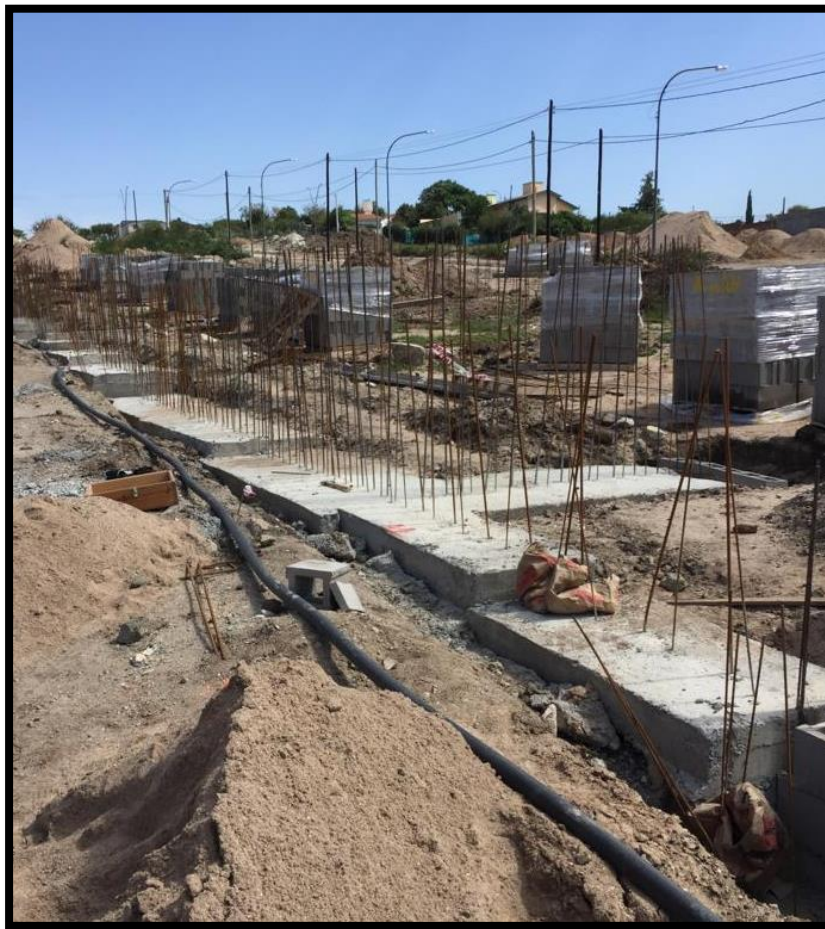
Figura 16. Fundación de muros de contención no portante.
