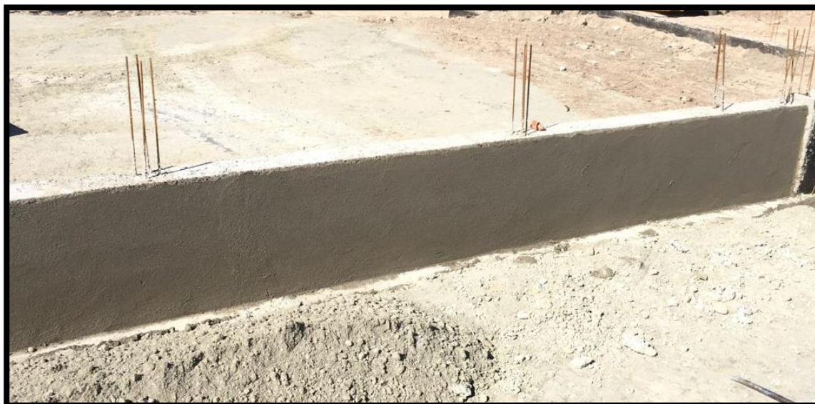
Figura 40. 2° Paso de aislación hidrófuga vertical "Jaharro impermeable".
