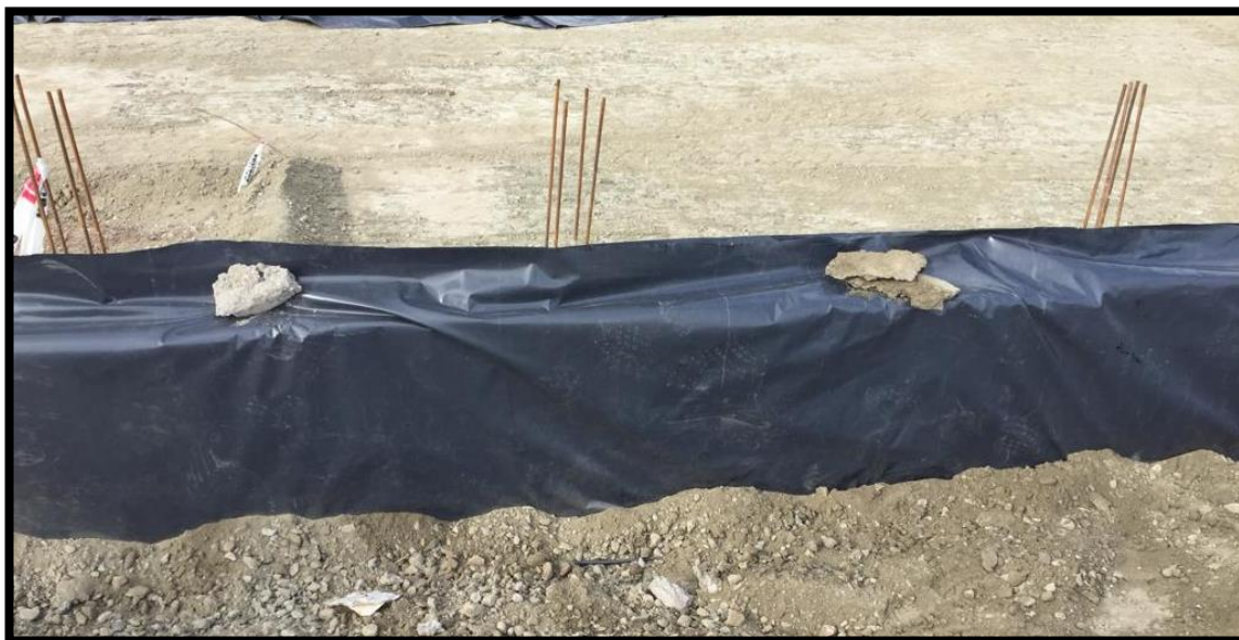
Figura 41. 3° Paso de aislación hidrófuga vertical "Pintado y colocación de film"
