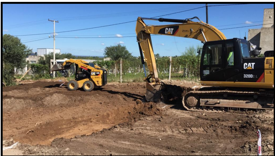
Figura 46. Retroexcavadora excavando y mini cargadora nivelando.
