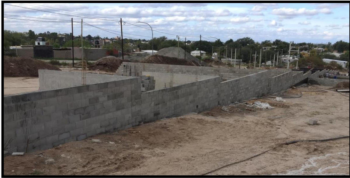
Figura 26. Mampostería de muros de contención no portante terminada.
