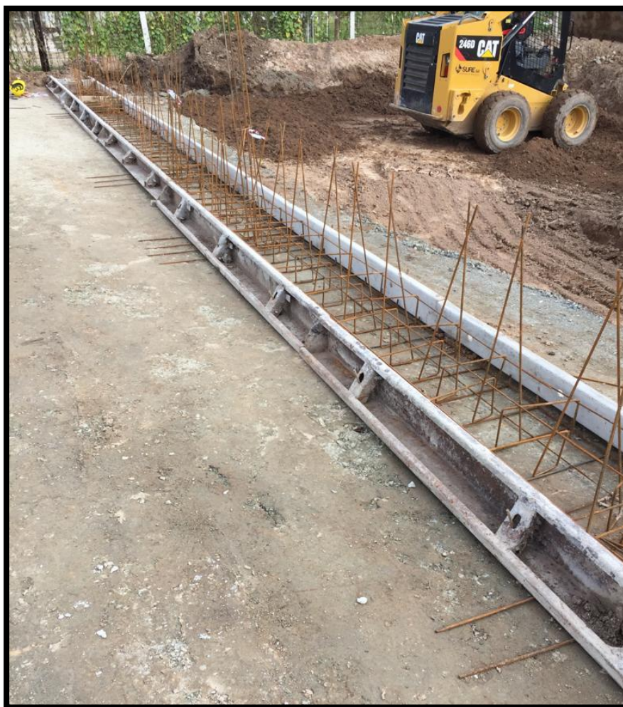
Figura 36. Encofrado de fundación de muro portante.
