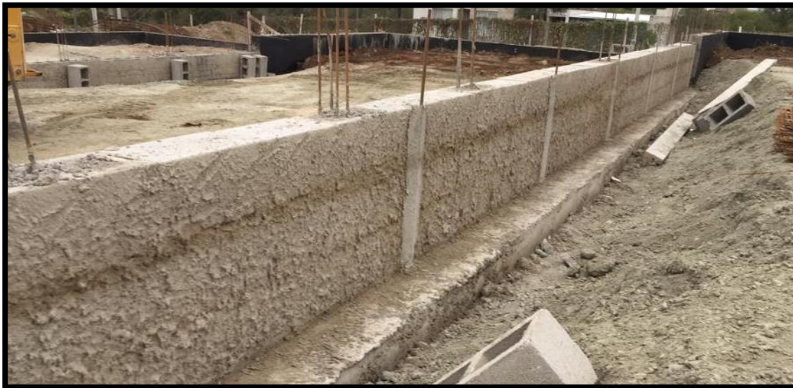
Figura 39. 1° Paso de aislación hidrófuga vertical "Base impermeable".
