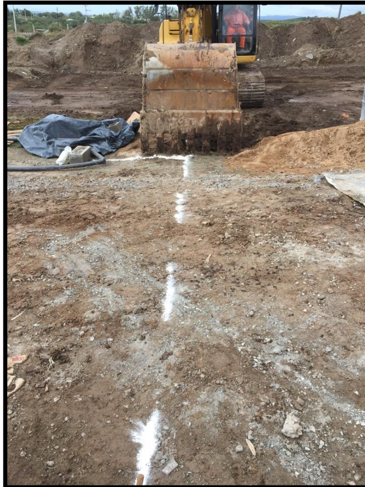
Figura 18. Retroexcavadora excavando fundación de muro no portante.
