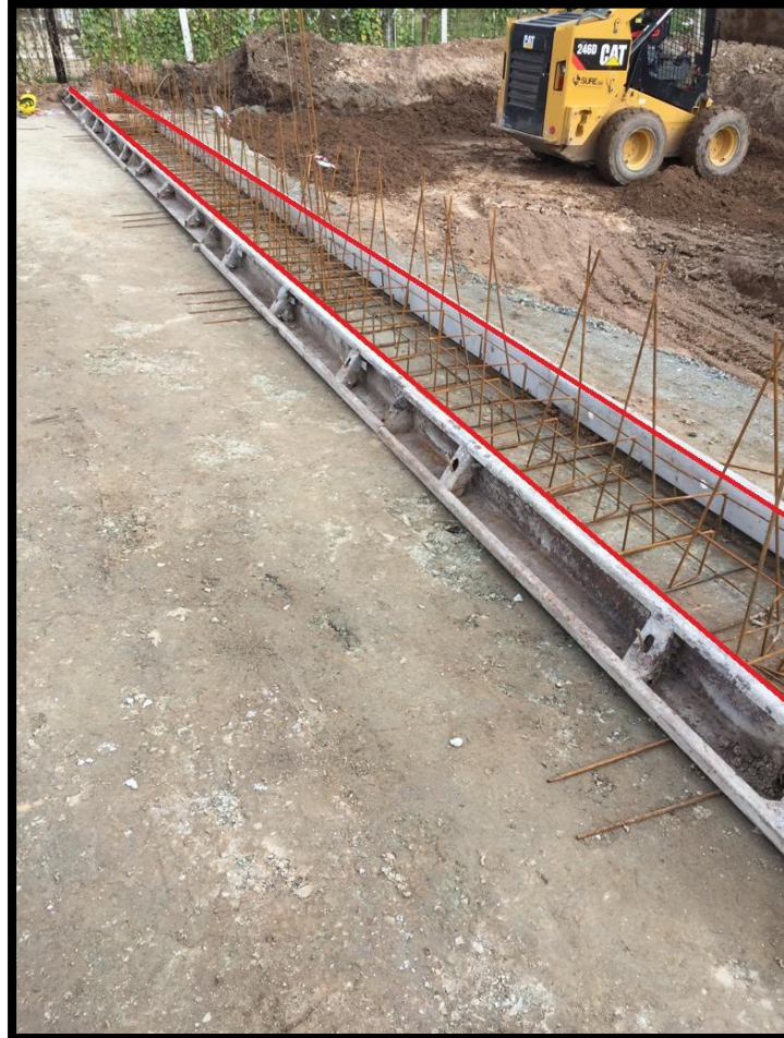
Figura 32. Líneas de encofrado de la fundación de MCP
