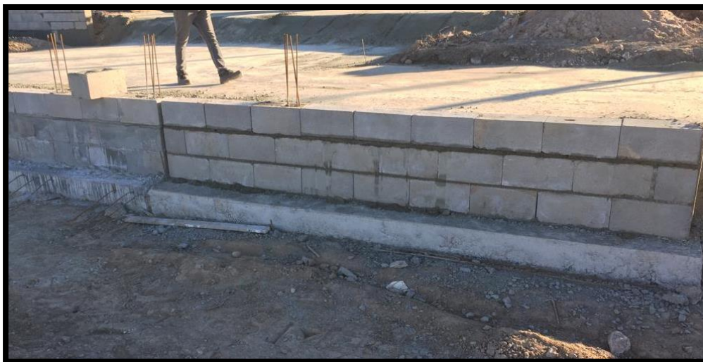
Figura 38. Mampostería de muros de contención portante terminada.
