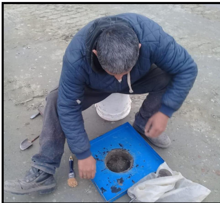
Figura 58. Ensayo de cono de arena en suelo granular 0-20.
