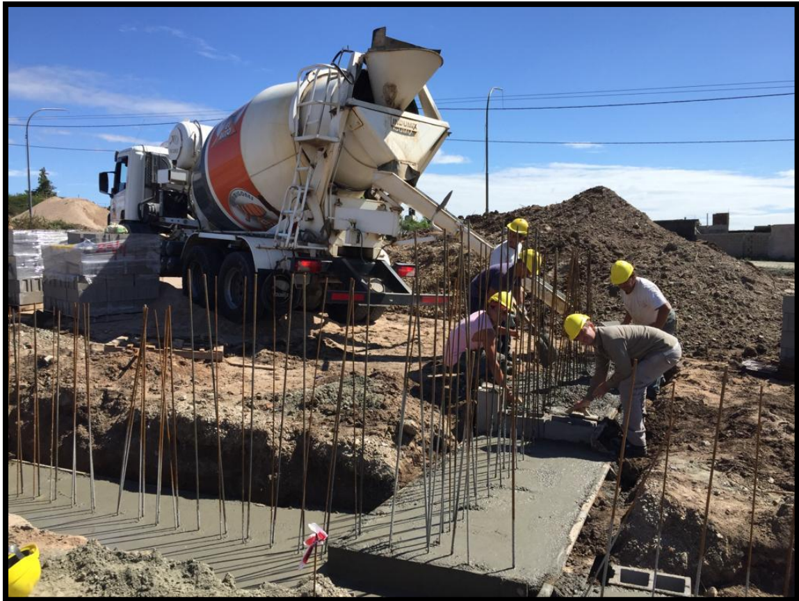
Figura 24. Proceso de hormigonado de fundación de muro no portante.
