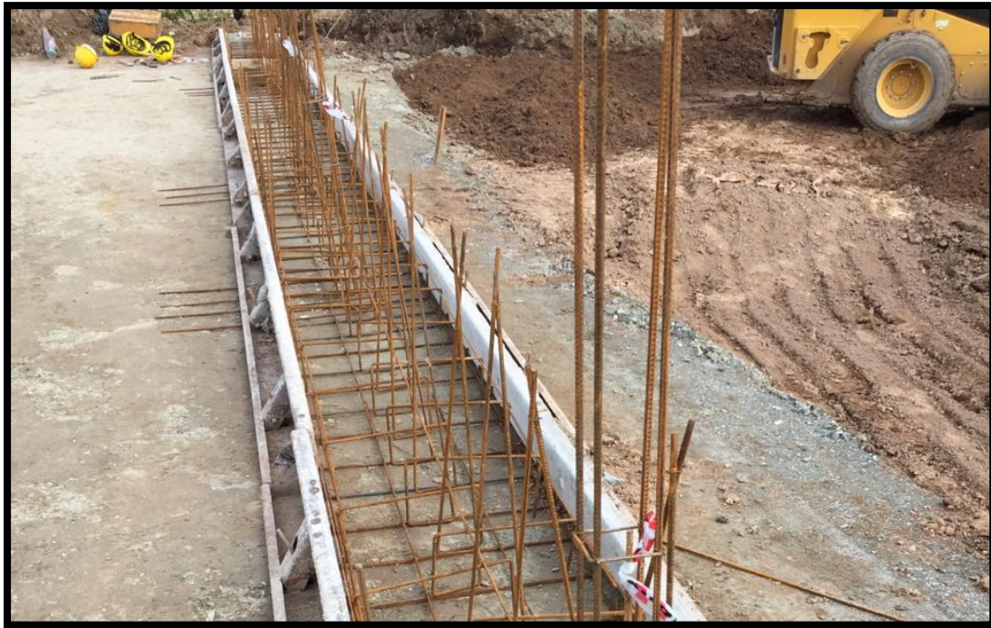
Figura 35. Armadura de fundación de muro de contención portante.
