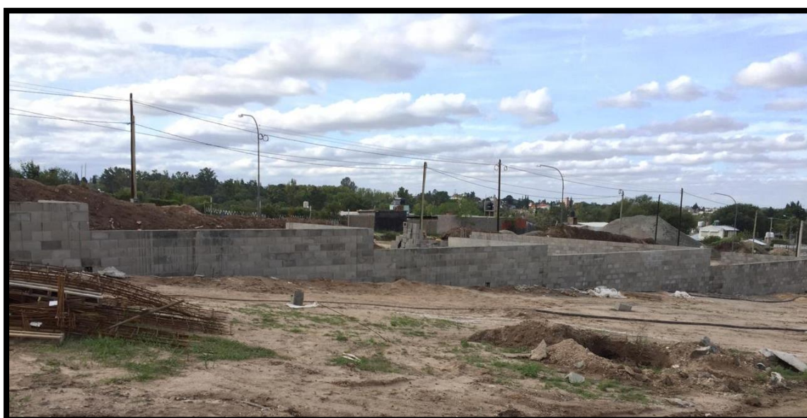
Figura 7. Muros de Contención no portantes a nivel de bandeja terminada.
