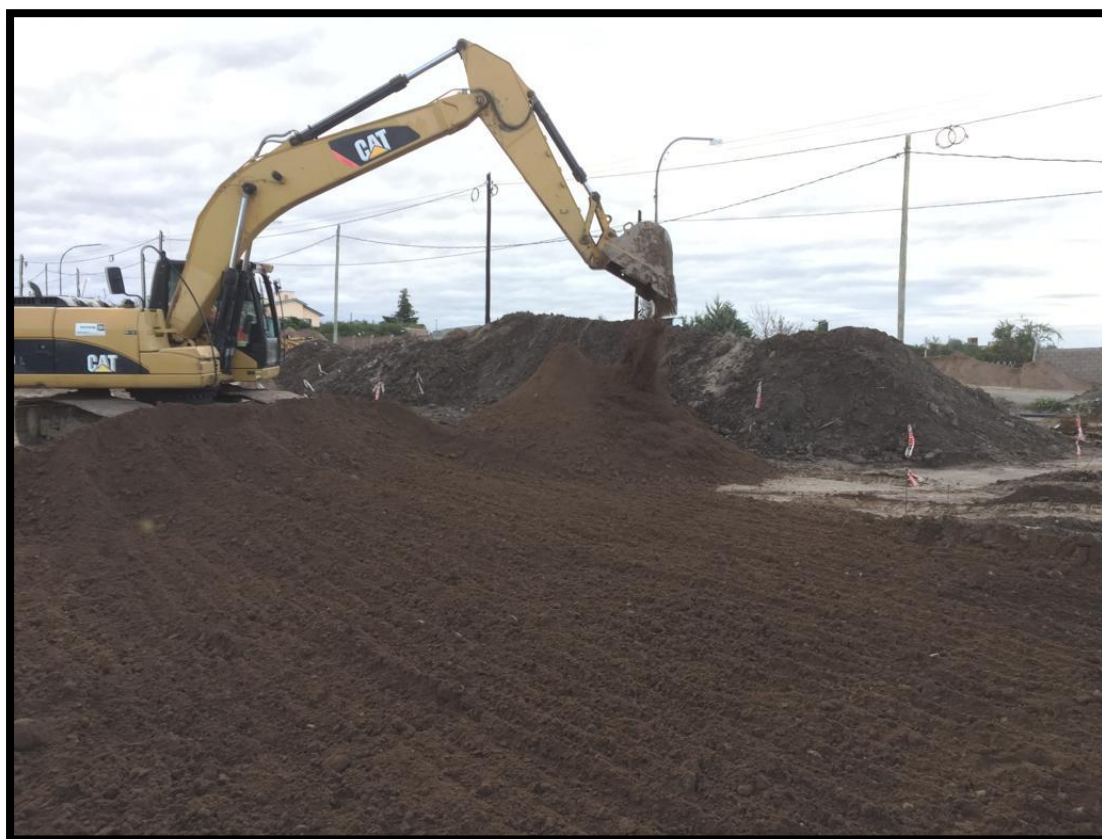
Figura 45. Retroexcavadora realizando la excavación del manto vegetal.
