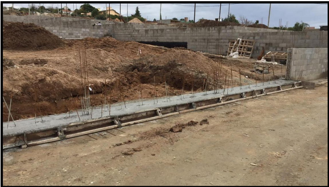
Figura 31. Fundación de muro de contención portante.
