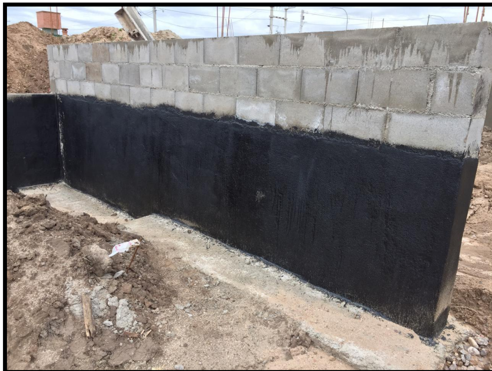
Figura 28. 2° Paso de aislación hidrófuga vertical "Pintado con pintura asfáltica".
