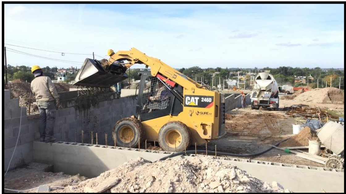
Figura 25. Llenado de muros con hormigón.
