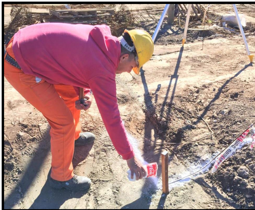
Figura 53. Operario referenciando las estacas con líneas de cal salientes de la silueta.
