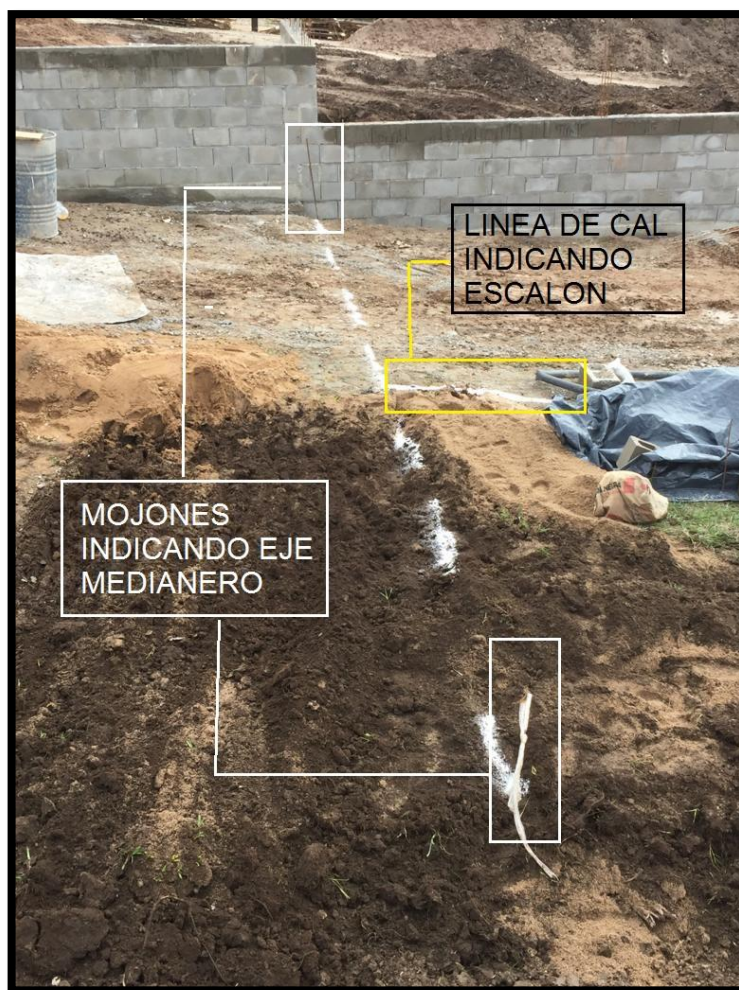
Figura 17. Replanteo de excavación de muro de contención no portante.
