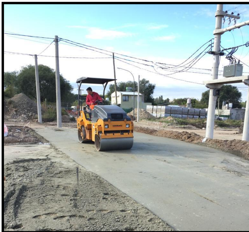
Figura 57. Equipo compactando material granular 0-20.
