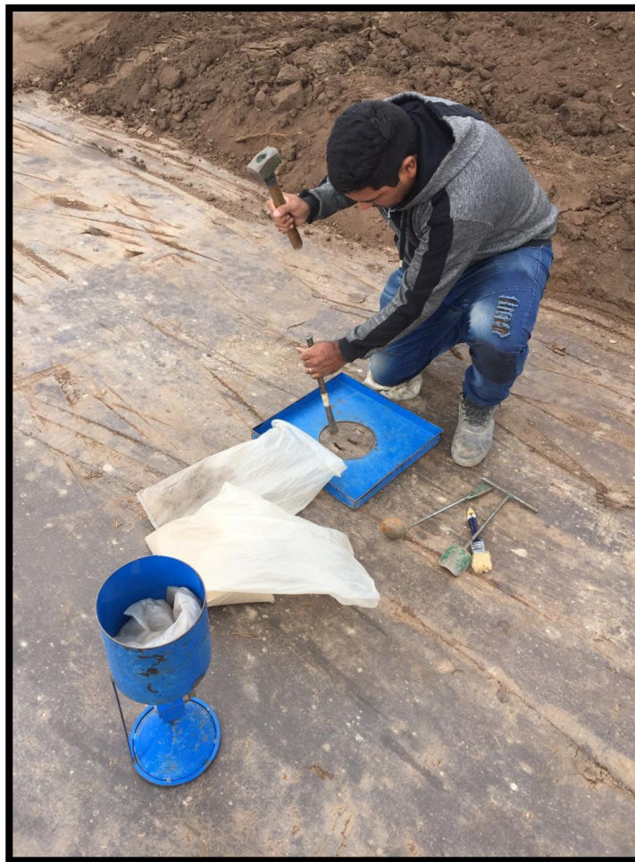
Figura 49. Ensayo de cono de arena en subrasante.
