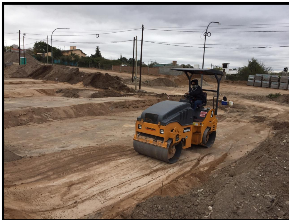
Figura 54. Equipo compactando suelo arena.
