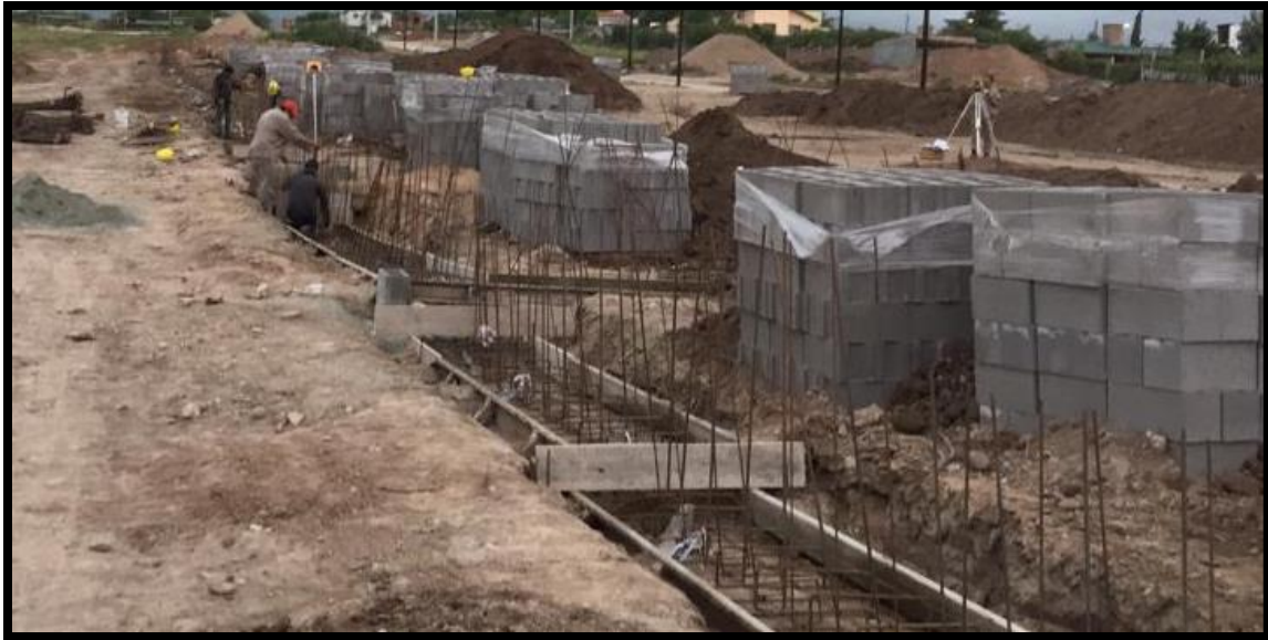
Figura 22. Armadura de fundación de muro de contención no portante.
