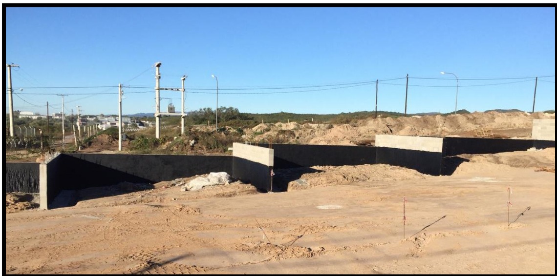
Figura 15. Muros de contención no portante (MMF y MMP).
