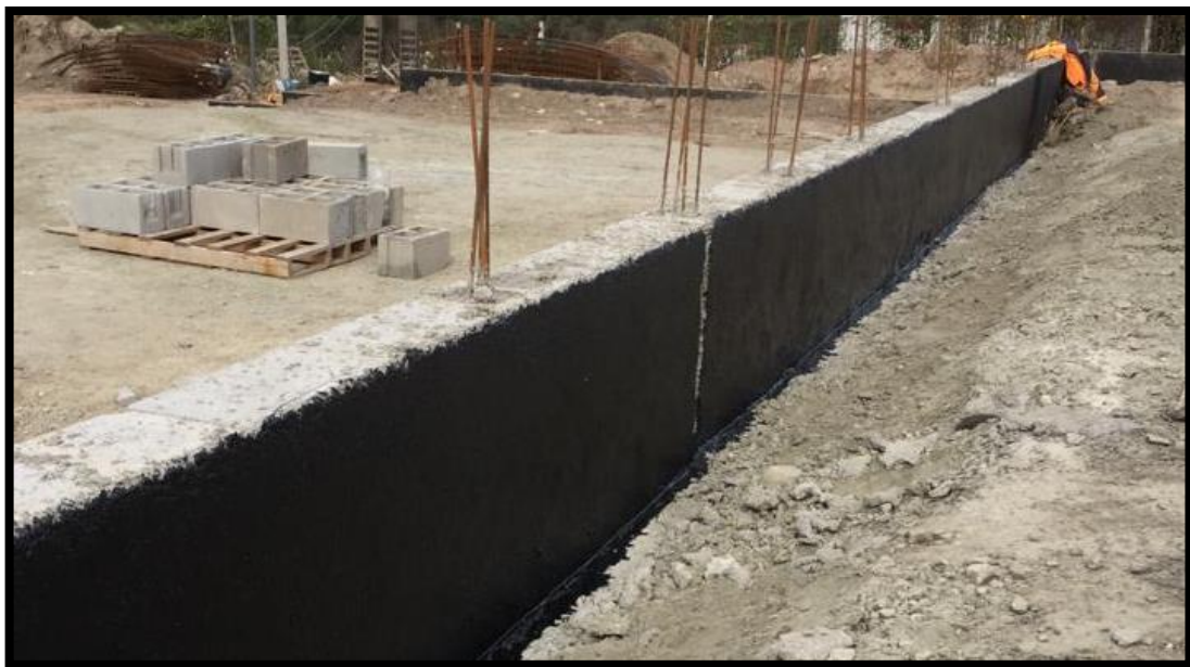
Figura 30. Muro de contención Portante.
