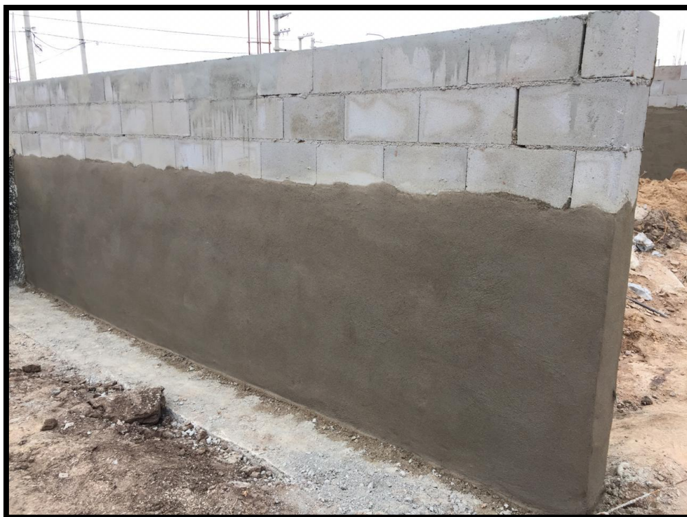
Figura 27. 1° Paso de aislación hidrófuga vertical "Base impermeable".
