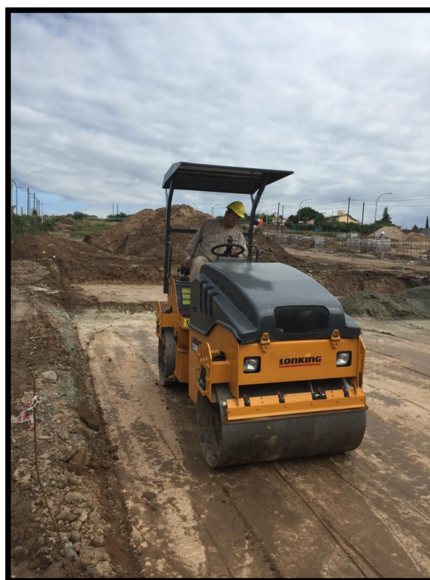
Figura 48. Equipo compactando subrasante.
