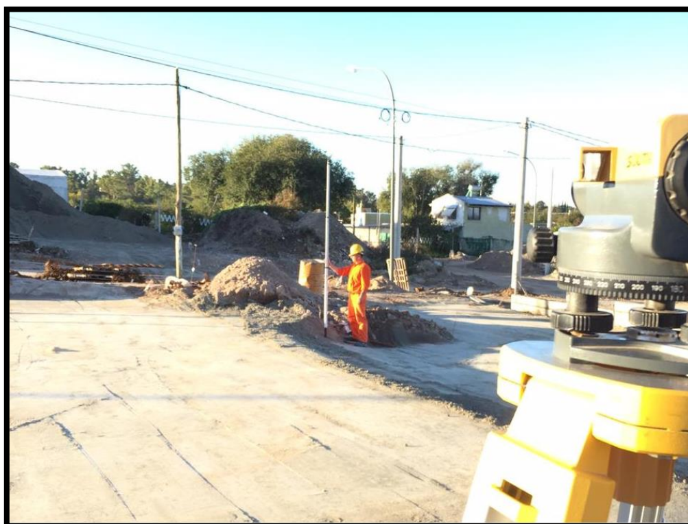
Figura 52. Operario plantando estacas a nivel.
