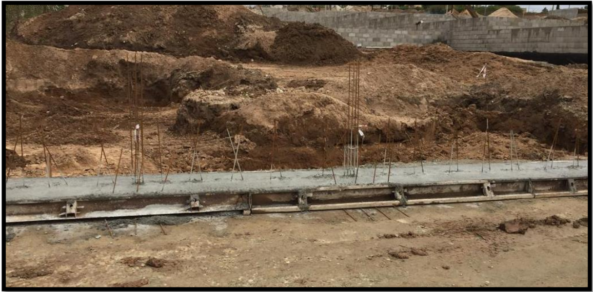
Figura 37. Fundación de muro portante hormigonada.
