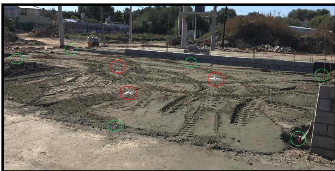
Figura 56. Estacas extras para terminación de última capa.
