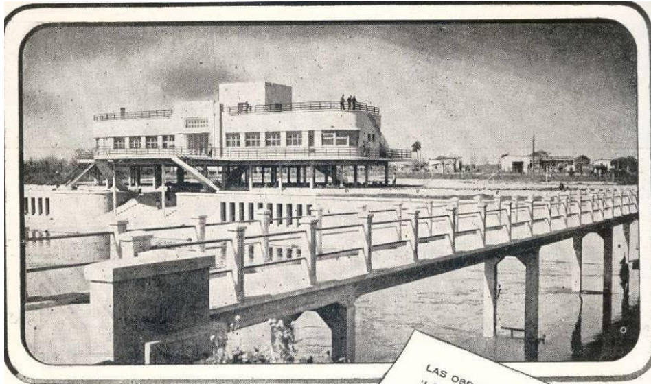
Edificio del Bañero de Marcelino Ugarte (Salto) — Al frente la pasarela de hormigón construida sobre columnas del mismo material, cuyo largo es de 60 metros, ancho 3 mts. y alto, desde el nivel normal de las aguas, 4 mts
