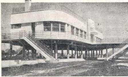
Detalle que permite apreciar el edificio del Bañero construido totalmente sobre columnas de hormigón, cuyo acceso se efectúa por medio de escalinatas con truidas igualmente con hormigón de cemento portland.
