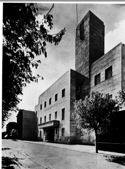
FACHADA PRINCIPAL SOBRE LA CALLE BARTOLOME MITRE
