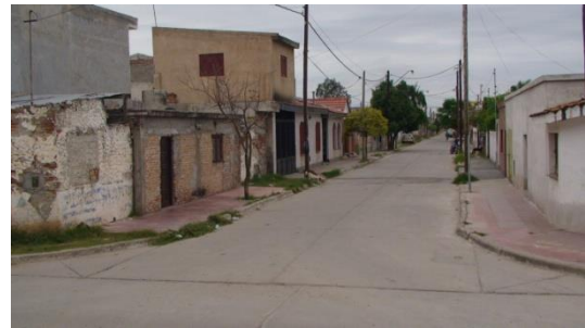
Imagen 9: Calle Rio Negro, perpendicular a la Av. Lugones Sur
