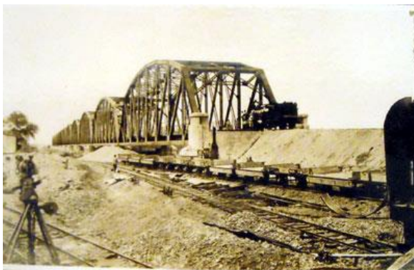
Imagen 2. Puente carretero que comunica a la ciudad de La Banda, durante su construcción entre los años 1926-1927.
