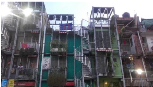
Figura 4. Vista del sistema de fachadas del plan piloto de mejoramiento.
