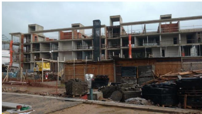
Figura 6. Vista del conjunto nuevo en construcción.
