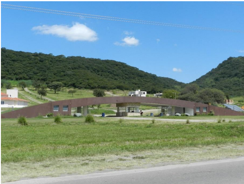
Imagen 5: Pérdida de espacios productivos.
