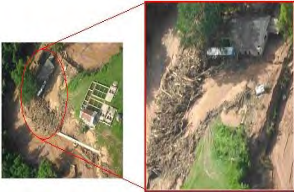
Figura 24. Vista aérea de la planta potabilizadora de agua del Aguay. Se observan los depósitos de troncos y sedimentos sobre la terraza circundada por el río Tartagal (Baumann et al. , 2009).
