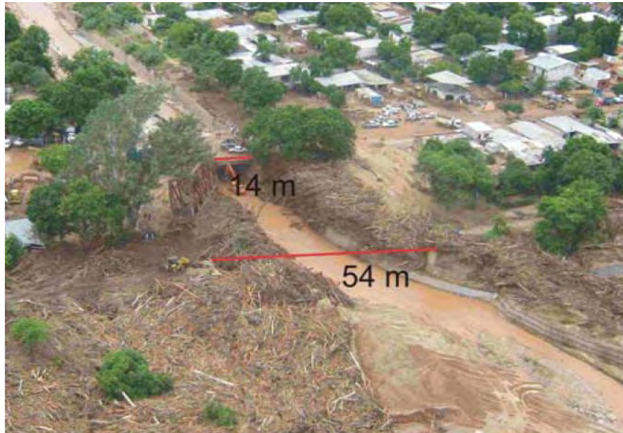
Figura 20. Vista de los de sedimentos, ramas y troncos que llegaron desde la cuenca alta hasta el puente de la avenida principal de la ciudad de Tartagal, ubicada en la cuenca baja del río homónimo. Se observa el ancho del antiguo puente de ferrocarril (14 m) y del puente de la avenida (54 m). (Baumann et al. , 2009).
