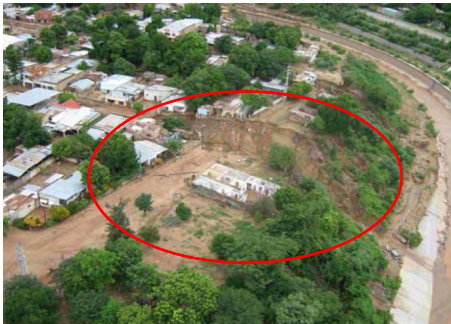
Figura 21. Vista de una de las cárcavas producidas por la erosión en el río Tartagal en el momento de la crecienete (Baumann et al. , 2009).
