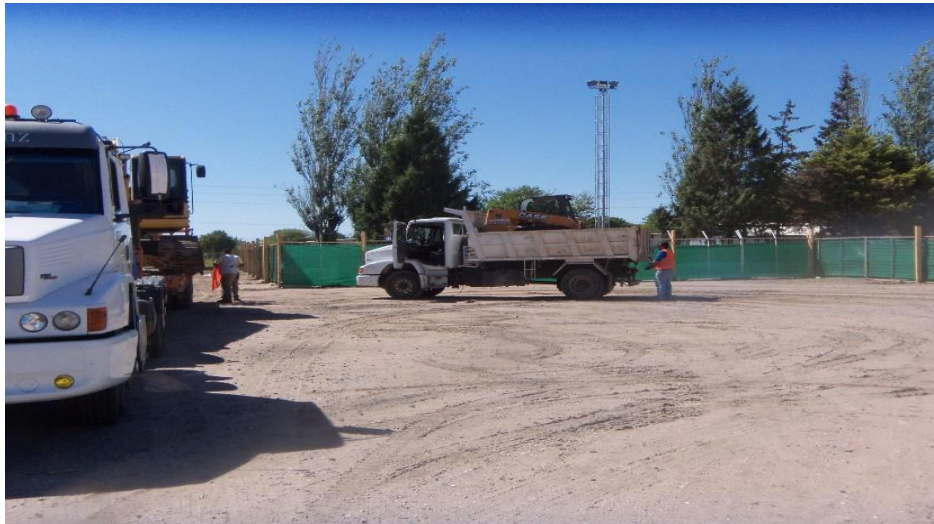
Figura 4.1.4: Sector de acopio de materiales y equipos
