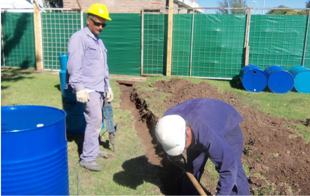
Figura 4.1.12: Construcción de zanjas y canal de desagüe
