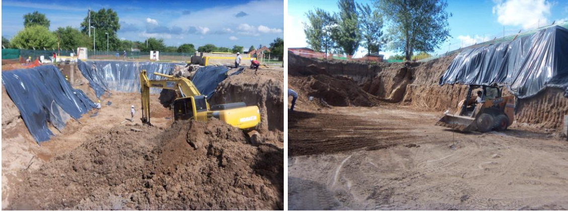
Figura 4.1.27: Colocación de Nylon 200 \mu en taludes norte y sur
