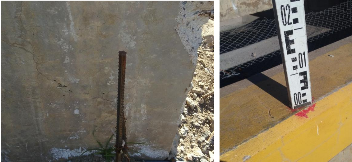
Figura 4.1.21: Puntos fijos altimétricos dentro del sector de obra
