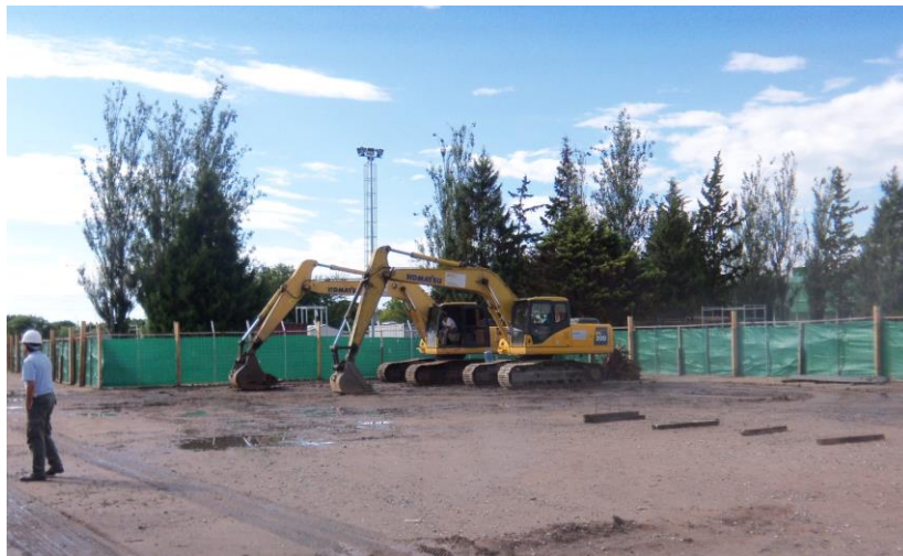
Figura 4.1.16: Prevención de accidentes a través del orden y limpieza en obra
