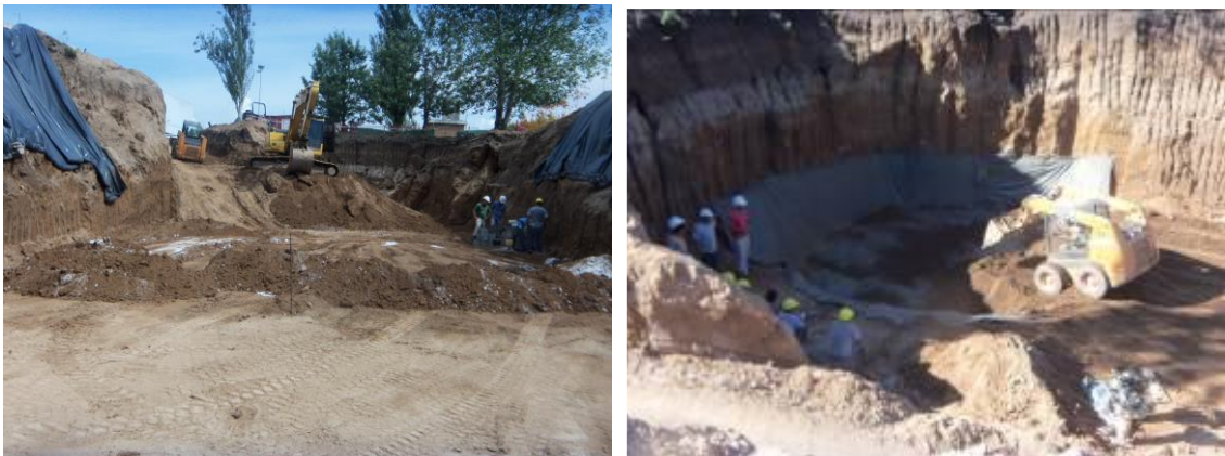
Figura 4.1.28: Excavación final de rampa de acceso y sedimentador
