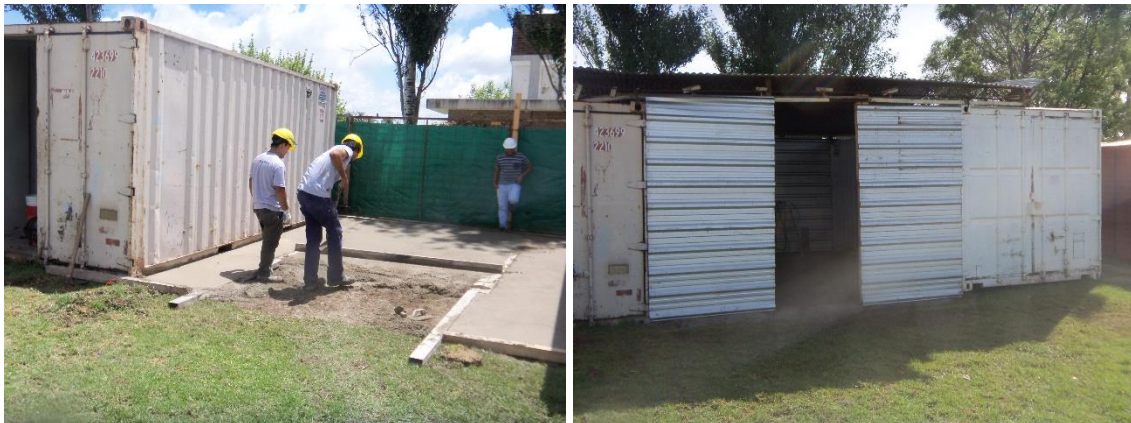
Figura 4.1.2: Obrador – Herramientas y Equipos
