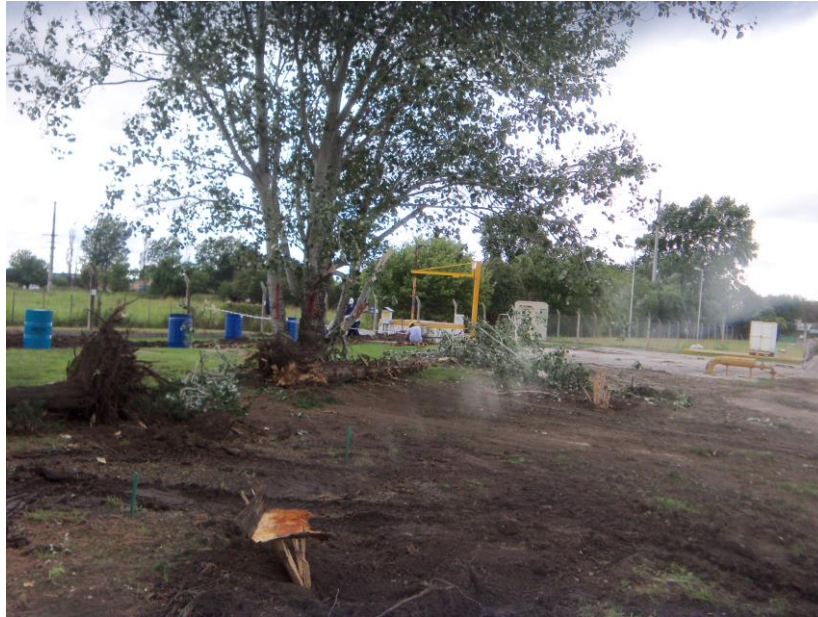
Figura 4.1.18 bis: Eliminación de manto vegetal
