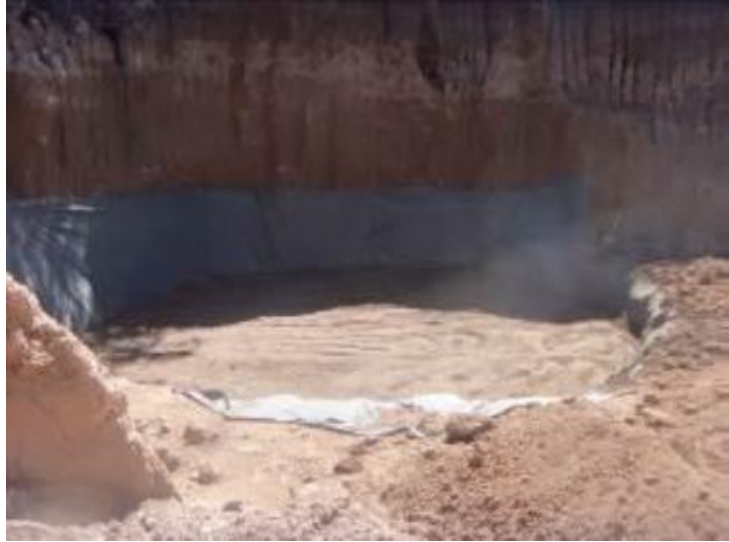
Figura 4.1.31: En Sedimentador: relleno con destape granular
