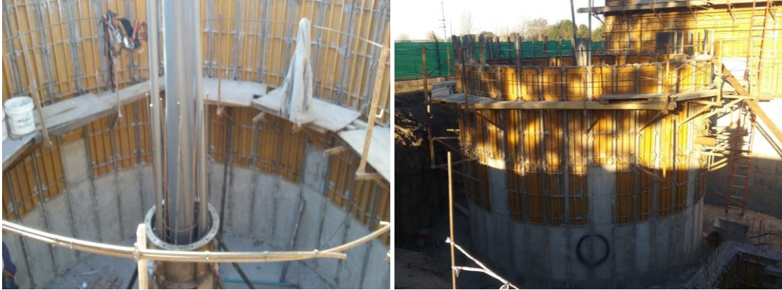
Figura 4.1.48: Hormigonado última etapa tabiques de Sedimentador y columna central
