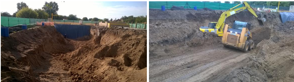
Figura 4.1.26: Excavación fina y perfilado de taludes
