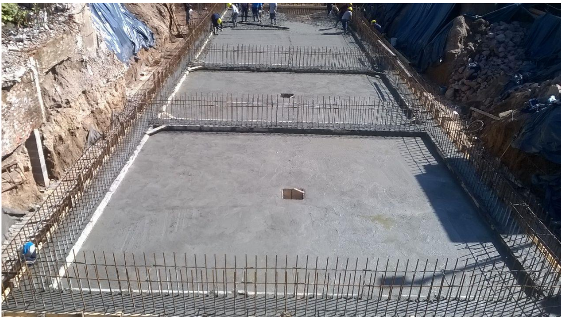
Figura 4.1.41: Hormigón en solera y arranque de tabique de Cámara de Reactores
