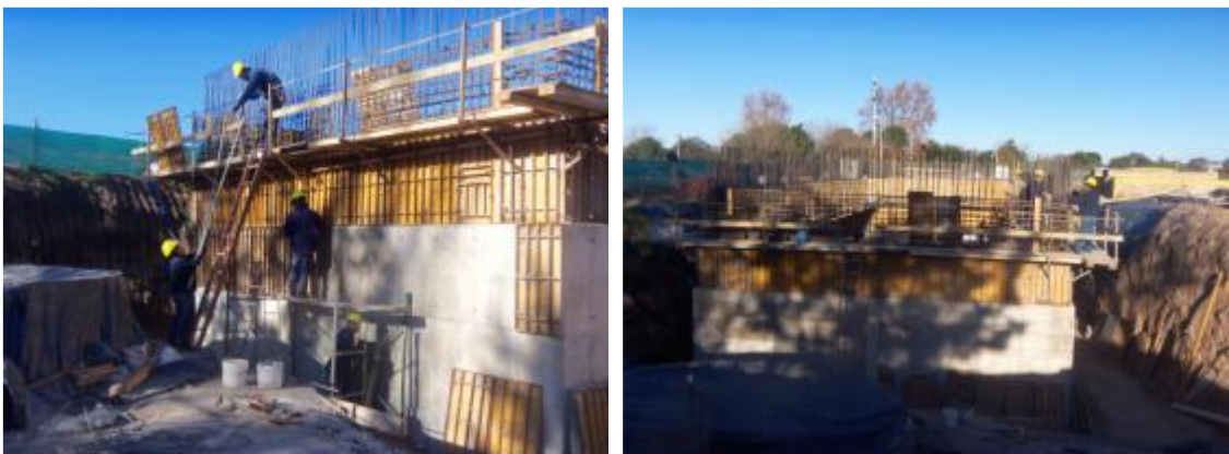
Figura 4.1.44: Hormigonado de tabiques de Cámara de Reactores, hasta altura final
