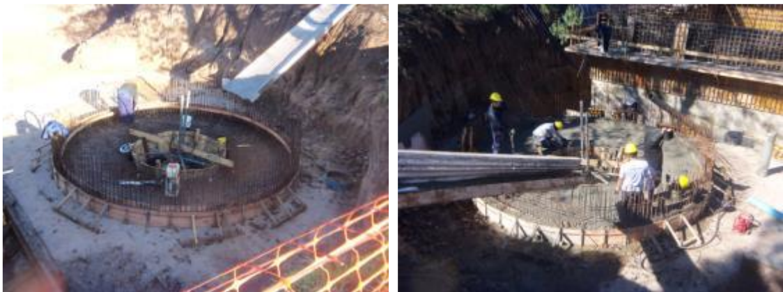
Figura 4.1.46: Hormigonado parte inferior de Sedimentador
