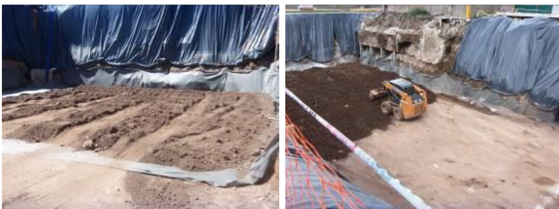
Figura 4.1.30: En Cámara B.A.-MBBR-D.: colocación de Geotextil y relleno con destape granular
