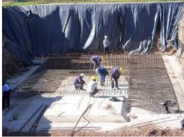
Figura 4.1.40: Hormigón de Limpieza, armadura y encofrado para hormigonar solera y arranque de tabique de Cámara de Reactores
