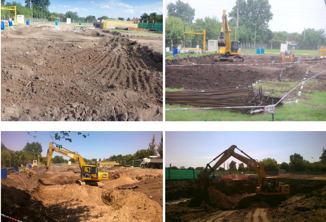
Figura 4.1.25: Excavación unificada de cámaras B.A.-MBBR-D. y Digestor
