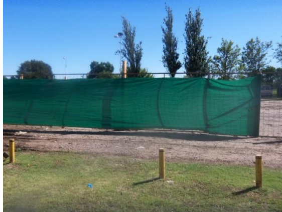
Figura 4.1.8: Cerco de obra tipo rejilla
