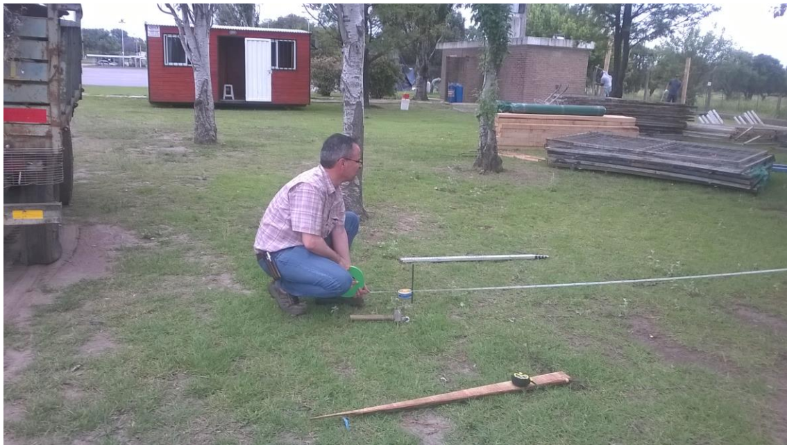
Figura 4.1.23: Replanteo de cámaras B.A.-MBBR-D. y Digester
