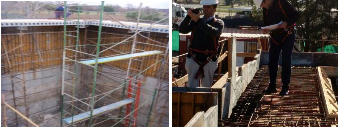
Figura 4.1.45: Armadura de pasarelas de Cámara de Reactores
