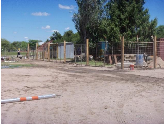
Figura 4.1.7: Cerco de obra tipo rejilla
