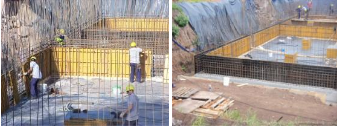
Figura 4.1.42: Encofrado EFCO para tabiques de Cámara de Reactores. Primera etapa.
