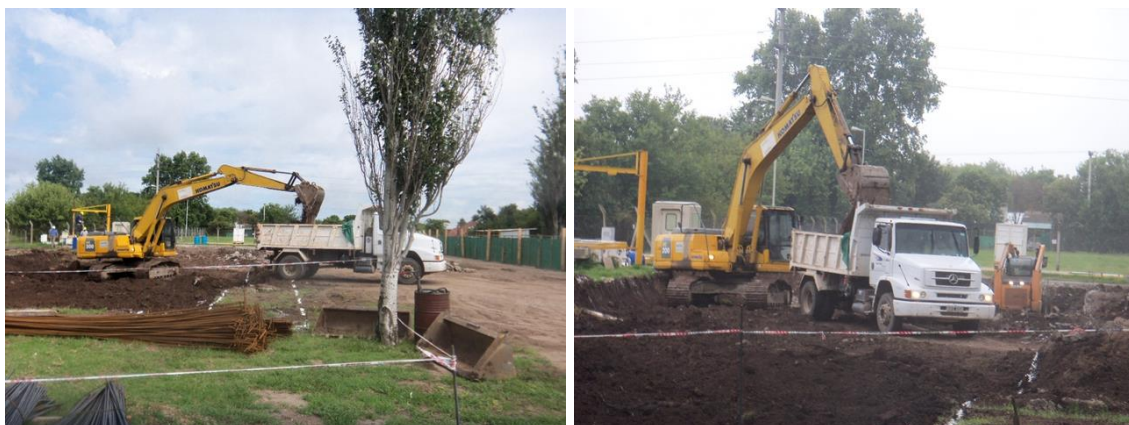
Figura 4.1.24: Excavación unificada de cámaras B.A.-MBBR-D. y Digester
