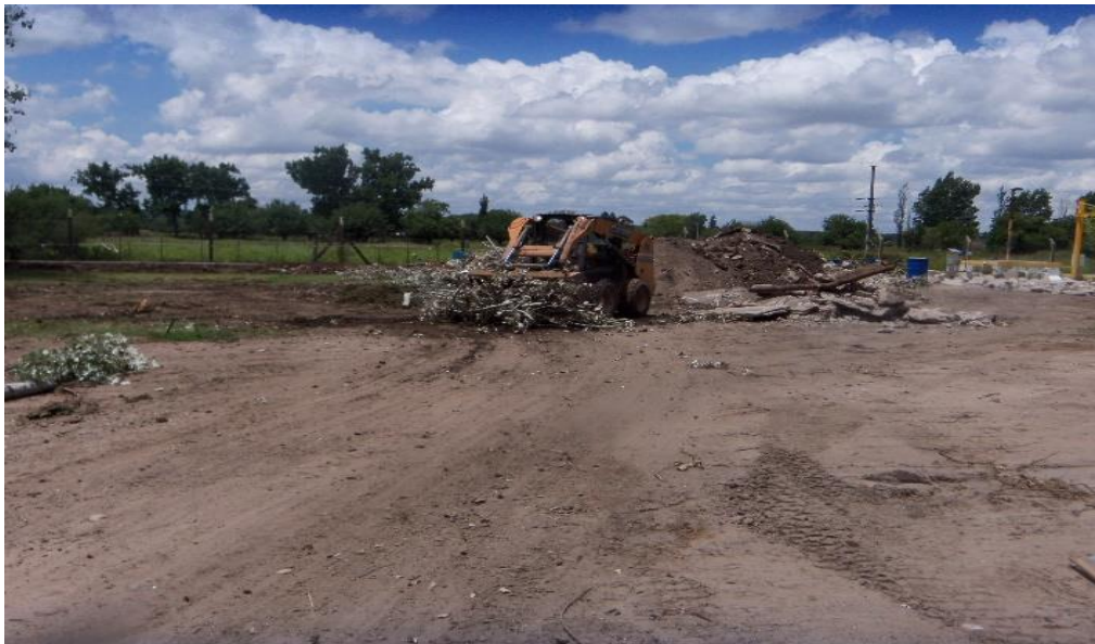
Figura 4.1.11: Limpieza y nivelación del terreno
