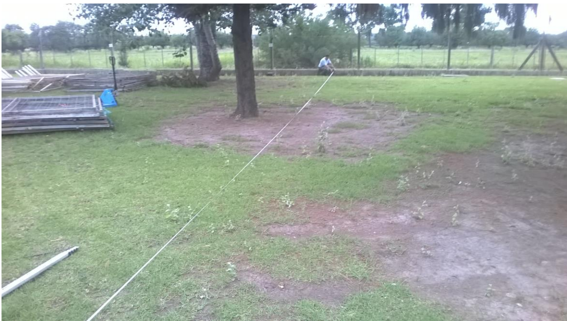
Figura 4.1.22: Replanteo de cámaras B.A.-MBBR-D. y Digestor
