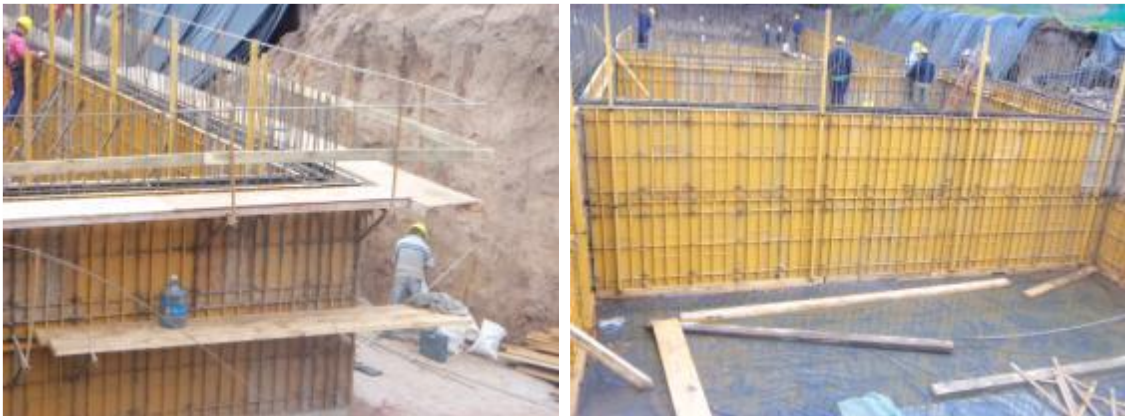
Figura 4.1.43: Hormigonado de tabiques de Cámara de Reactores, hasta los 2.40 m de altura
