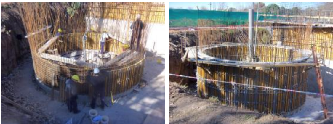
Figura 4.1.47: Hormigonado tabiques de Sedimentador
