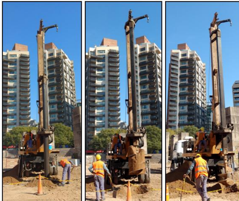
Fig. 3.28. Pilotera realizando la excavación de los pilotes.
