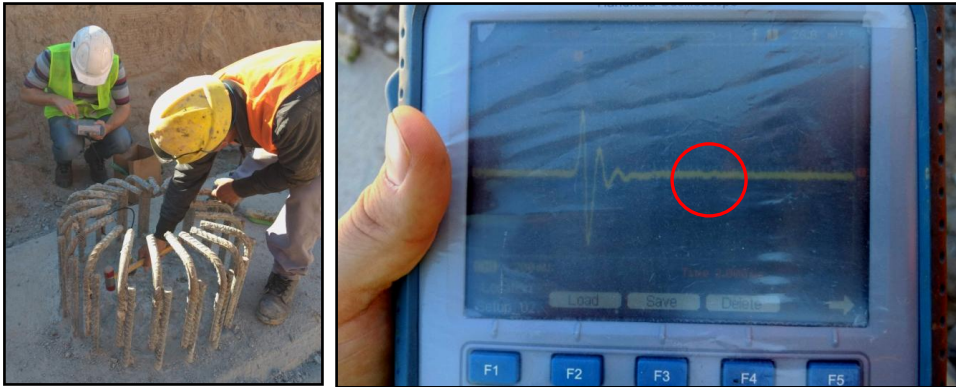
Fig. 3.37. Realización del ensayo de continuidad de los pilotes.
