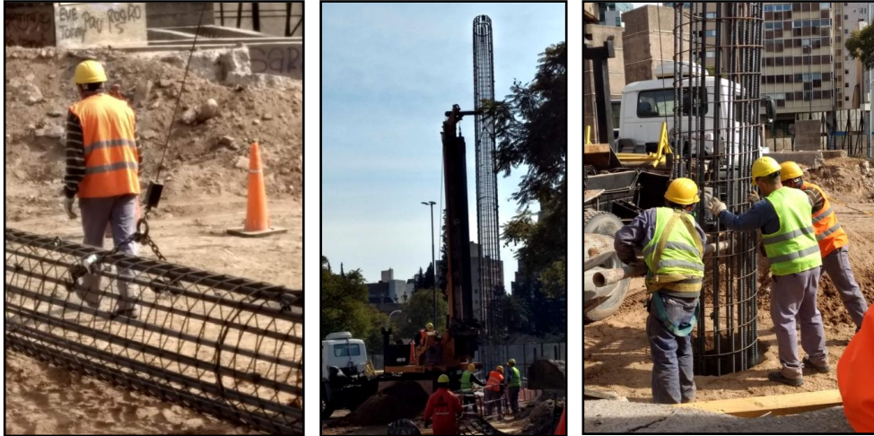
Fig. 3.31. Colocación de armadura con auxilio de la pilotera. Fuente: Elaboración propia.
