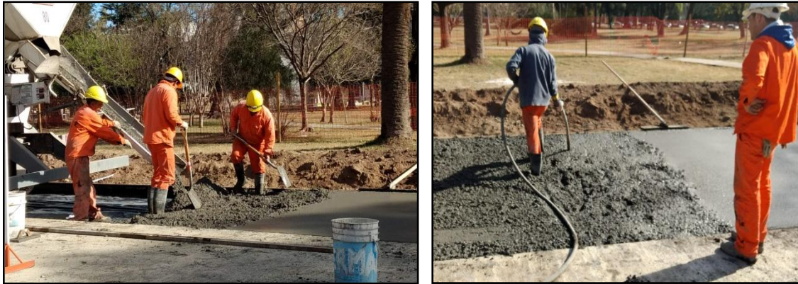
Fig. 3.39. Hormigonado de la dársena de calle conexión sur.
