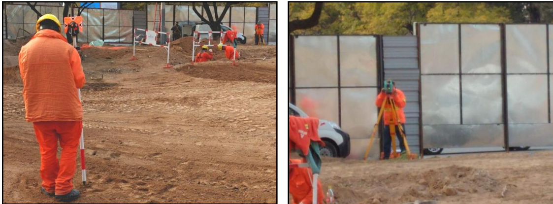
Fig. 3.27. Ingeniero agrimensor y operario realizando el replanteo de pilotes.
