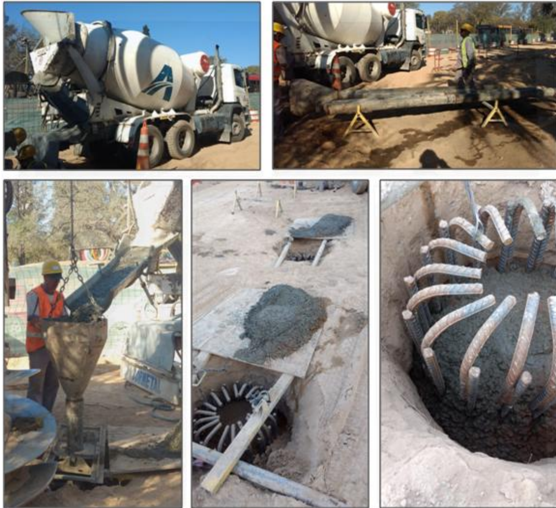
Fig. 3.35. Tareas para el hormigonado de los pilotes.
