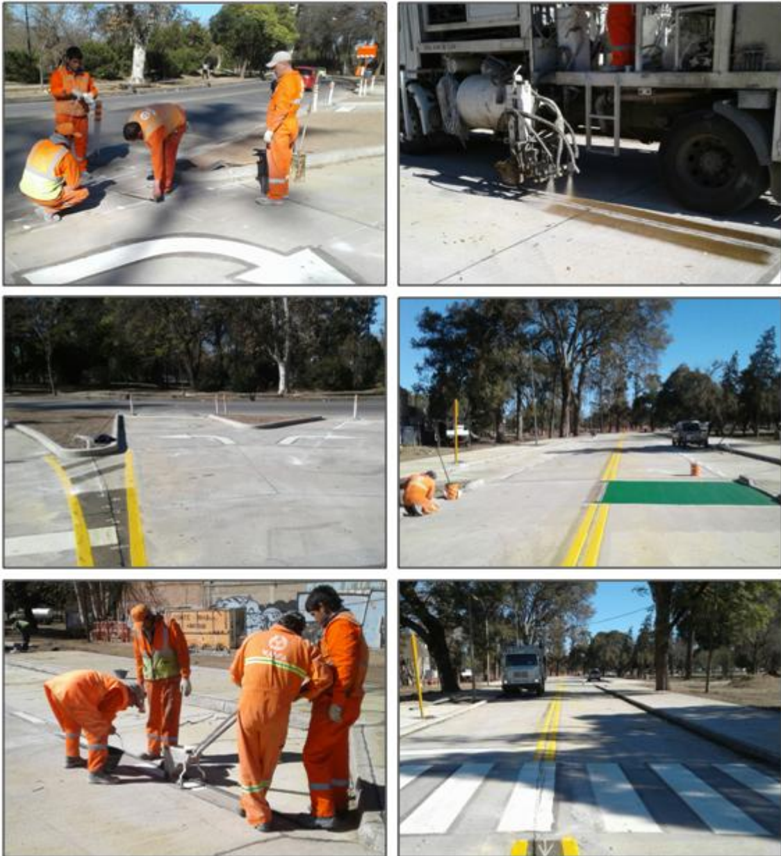
Fig. 3.43. Tarea de pintado de la demarcación horizontal.
