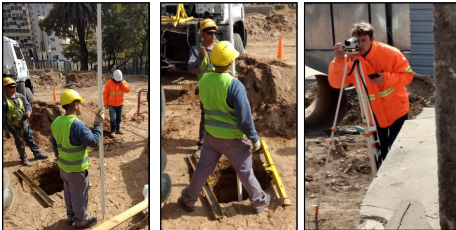
Fig. 3.33. Tareas de agrimensura para nivelación de armadura. Fuente: Elaboración propia.
