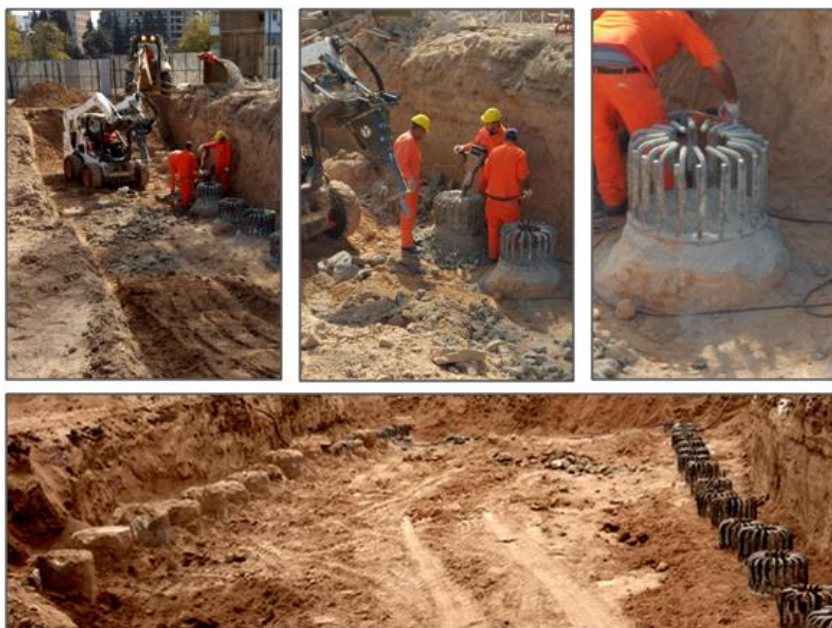
Fig. 3.36. Rotura de hormigón para dejar pelos libres.
