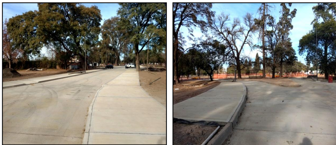
Fig. 3.40. Calle conexión sur finalizada.
