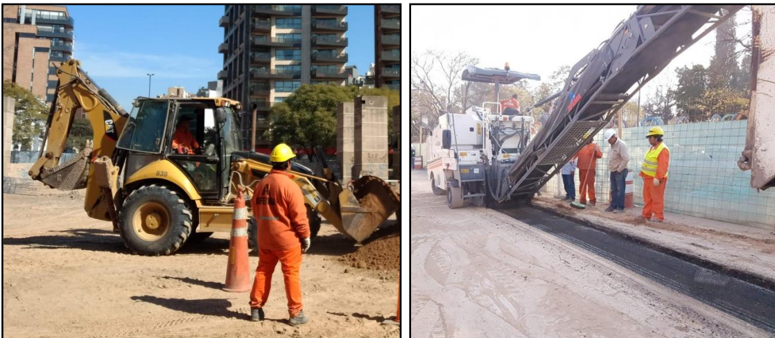
Fig. 3.26. Maquinarias trabajando en la preparación del terreno.
