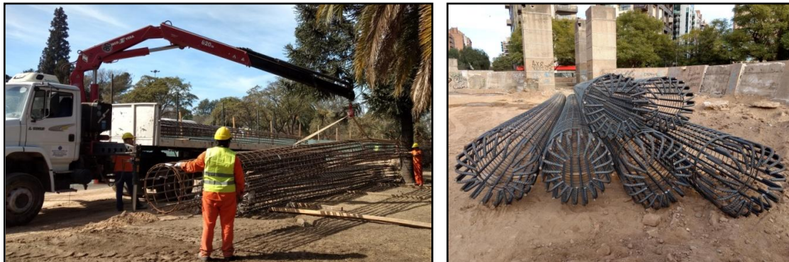
Fig. 3.30. Acopio de armadura.
