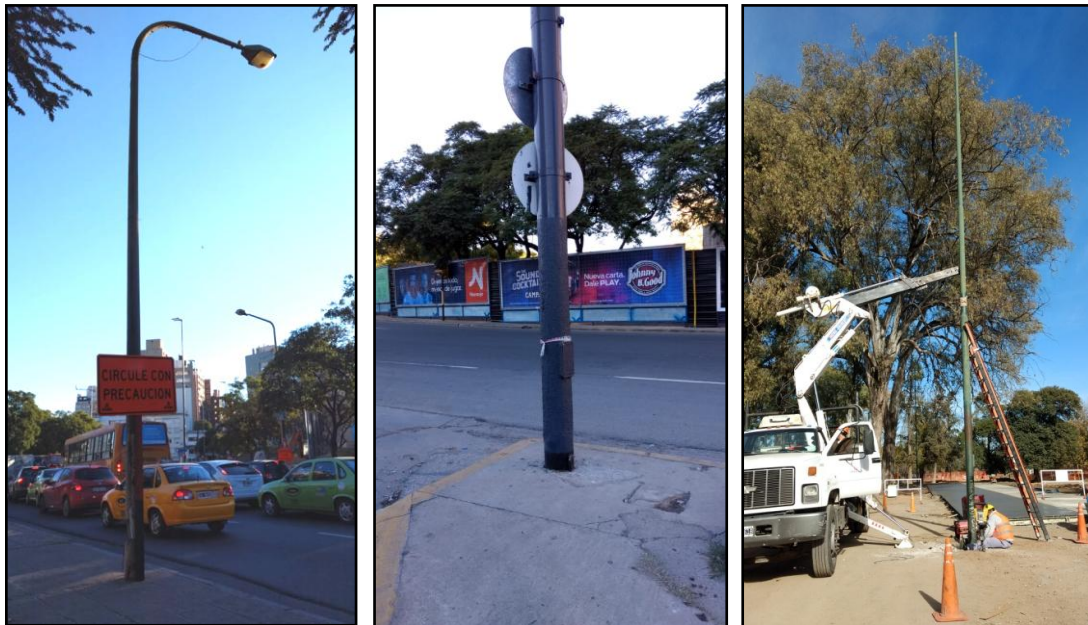
Fig. 3.9. Luminarias existentes afectadas – Operarios retirando poste de luz.
