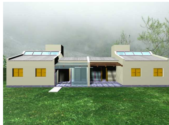
Figura 3: Frente de la vivienda, situación invierno (galería protegida) y verano (pérgola)
