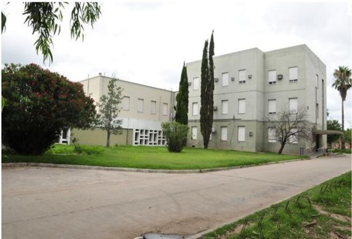
c.- Fachada del ala Sur del Hospital J.B. Iturraspe
