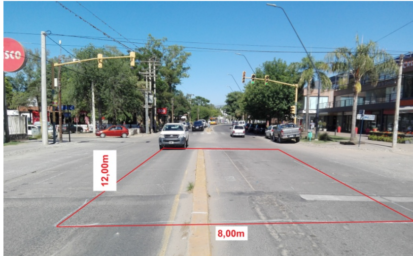
FIGURA N°54: REPLANTEO DE EXCAVACIÓN PARA NEXO CAÑO DE H°A° DN1500MM.
