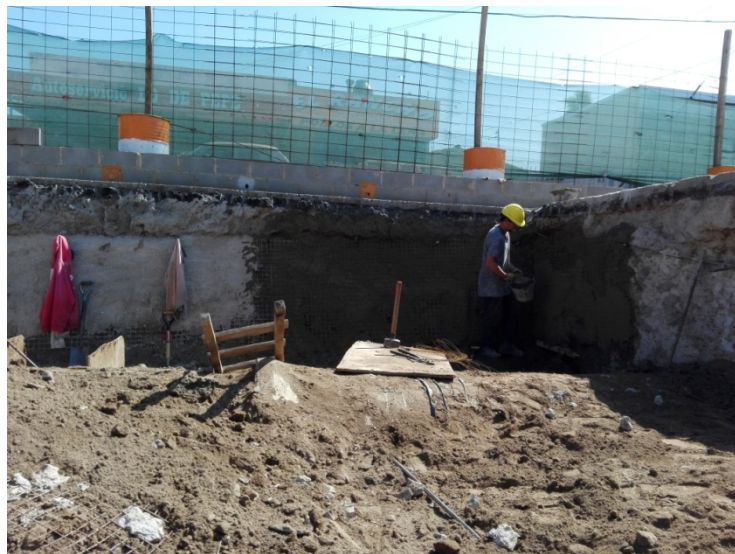
FIGURA N°57: ENTIBACIÓN DE EXCAVACIÓN PARA NEXO CAÑO DE H°A° DN1500MM.
