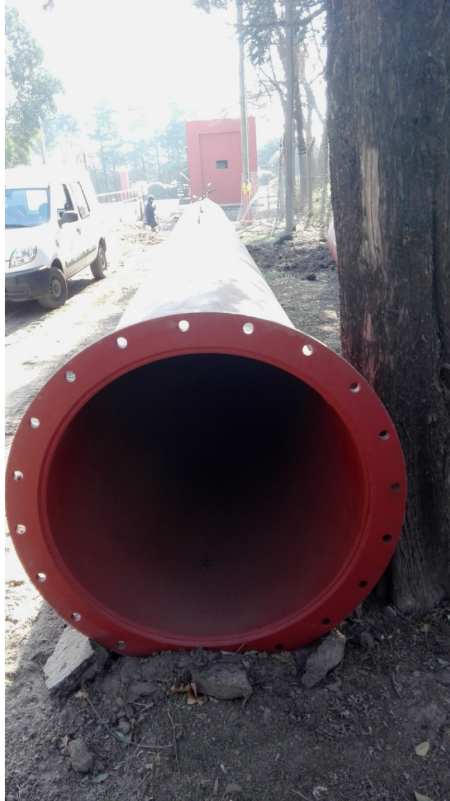
FIGURA N°16: FOTO DE PIEZA ESPECIAL TUBO DE ACERO EMPLEADO PARA CAÑO CAMISA.
