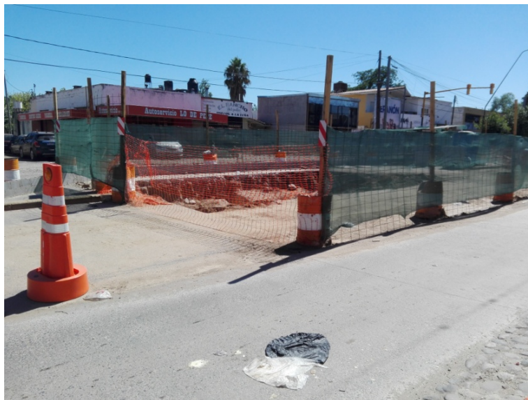
FIGURA N°55: SEÑALIZACIÓN Y ASERRADO PARA NEXO CAÑO DE H°A° DN1500MM.
