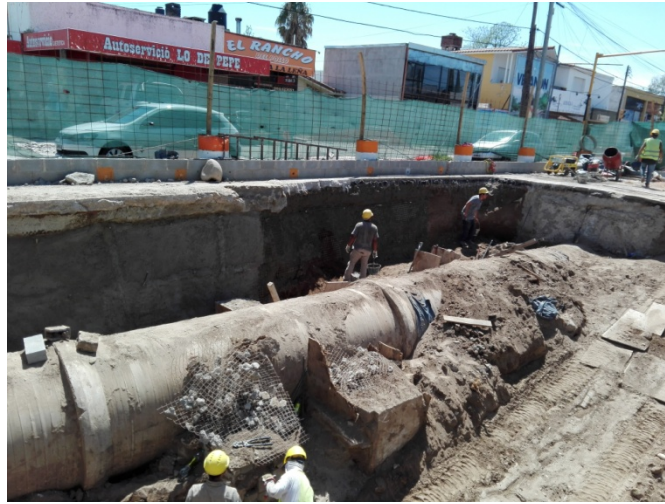
FIGURA N°60: EXCAVACIÓN y ENTIBADO PARA NEXO CAÑO DE H°A° DN1500MM.
