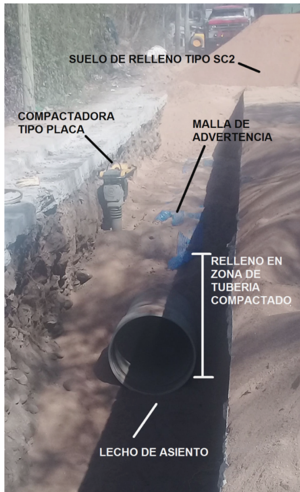
FIGURA N°50: COMPACTACION EN PROCESO DE INSTALACION DE CAÑERIA.
