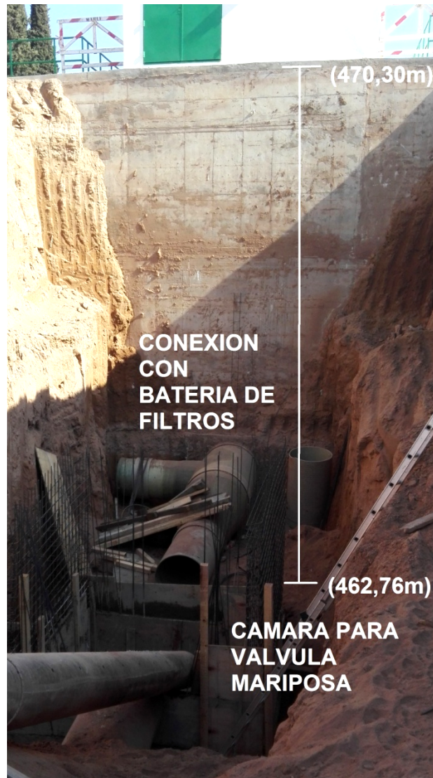
FIGURA N°42: FOTO DE EXCAVACION PARA EMPALME CON SALIDA DE BATERIAS DE FILTROS, CAMARA PARA VALVULA MARIPOSA.
