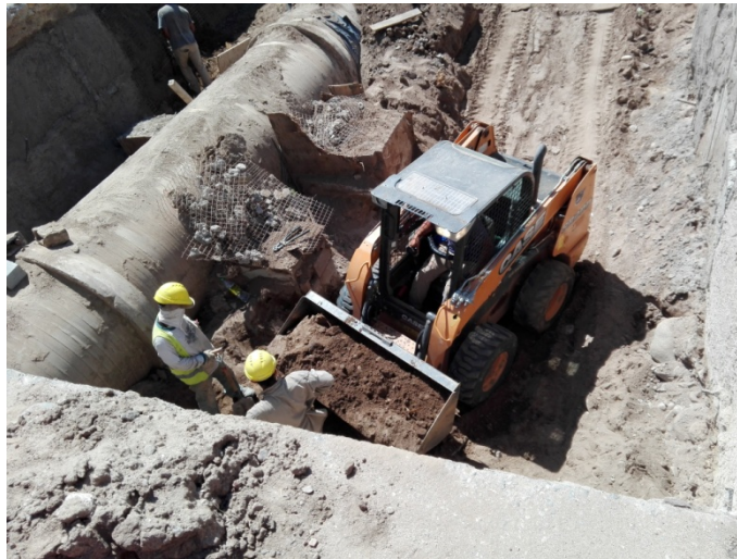
FIGURA N°59: EXCAVACION PARA NEXO CAÑO DE H°A° DN1500MM.
