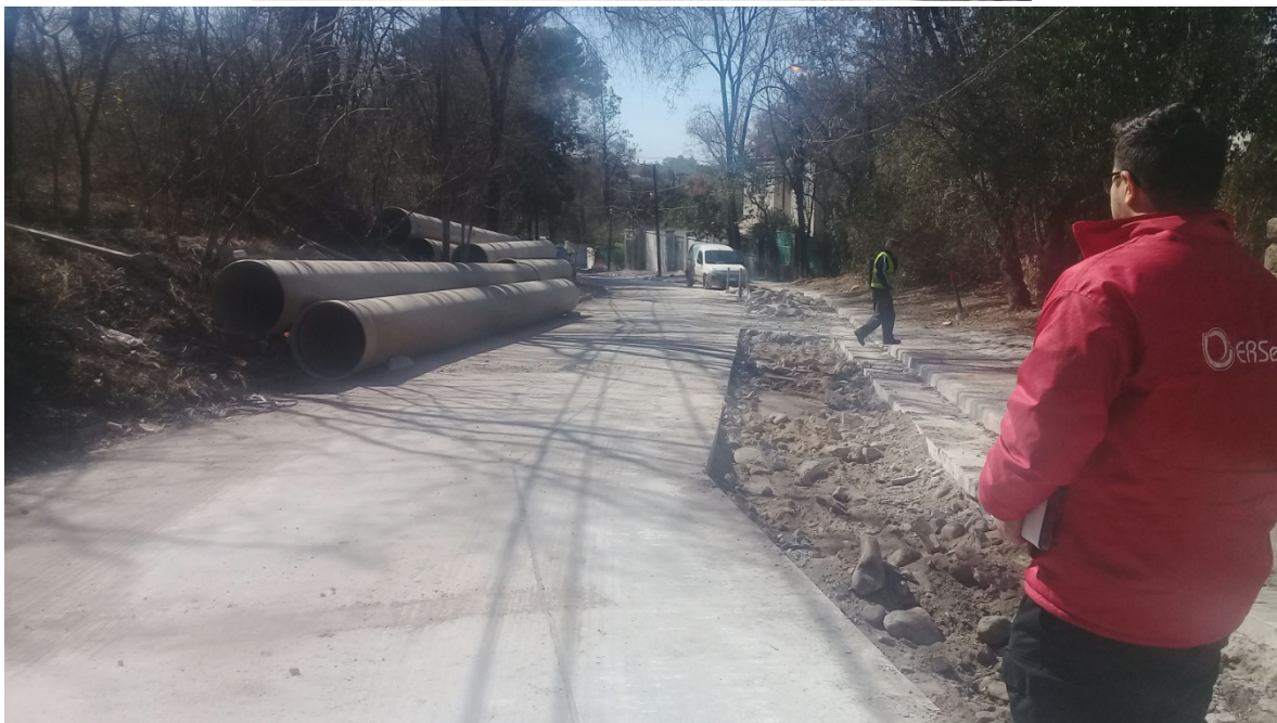
FIGURA N°27: ACOPIO DE MATERIALES EN ZONA URBANA.
