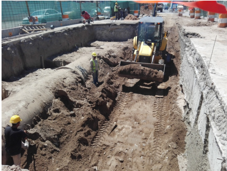
FIGURA N°56: DESCUBRIMIENTO DE CAÑO DE H°A° DN1500MM.
