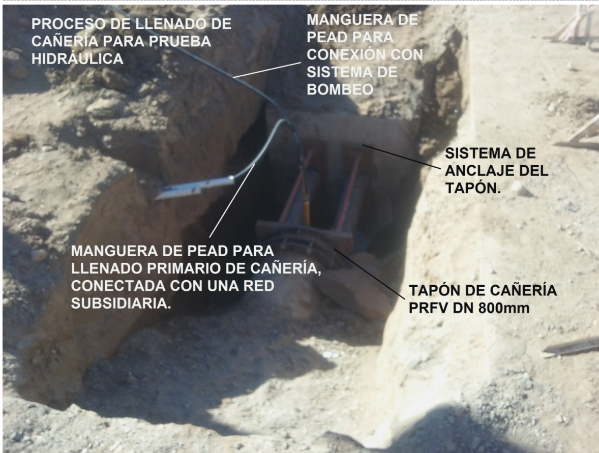
FIGURA N°44: FOTO DE TOMA EN CARGA PARA LLENADO DE CAÑERÍA EN PRUEBA HIDRÁULICA.
