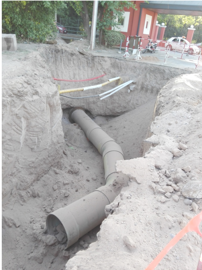
FIGURA N°26: ACCESORIOS DE LA CAÑERÍA PRFV DN800mm.
