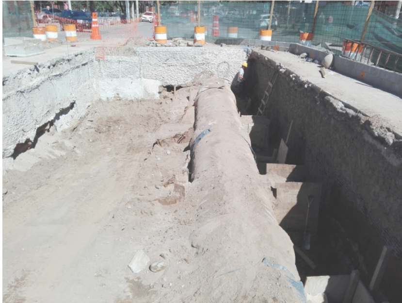
FIGURA N°58: CONSTRUCCION DE SILLETAS DE ASIENTO PARA NEXO CAÑO DE H°A° DN1500MM.
