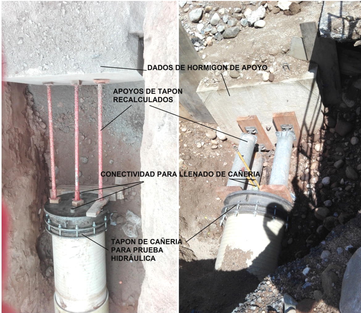
FIGURA N°43: FOTO DE TAPONES PARA CAÑERÍA EN PRUEBA HIDRÁULICA.
