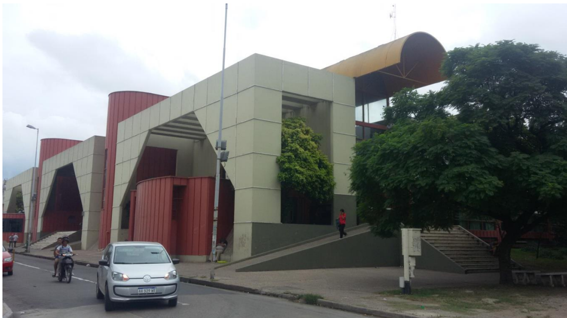
Fig.12 Imagen rampa de acceso sobre Bv. Guzmán
