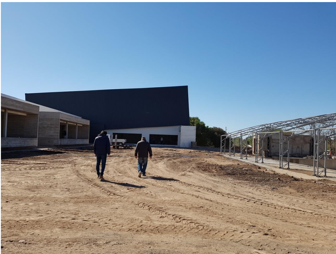
Fig.59 Imagen de ingreso al parque noroeste con vista al SUM al fondo de la imagen
