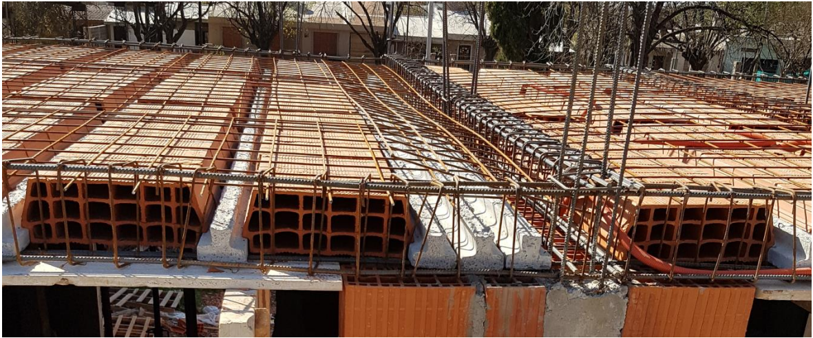
Fig.49 Imagen de armado de losas de viguetas, tomada en parque zona este
