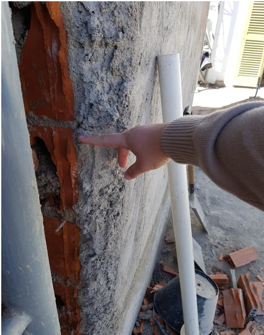
Fig.57 Imagen de revoque de la sala de máquinas – parque noroeste
