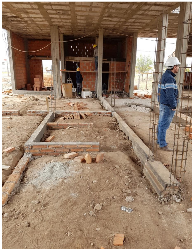
Fig.78 Imagen de zona de obra zona administrativa – parque este
