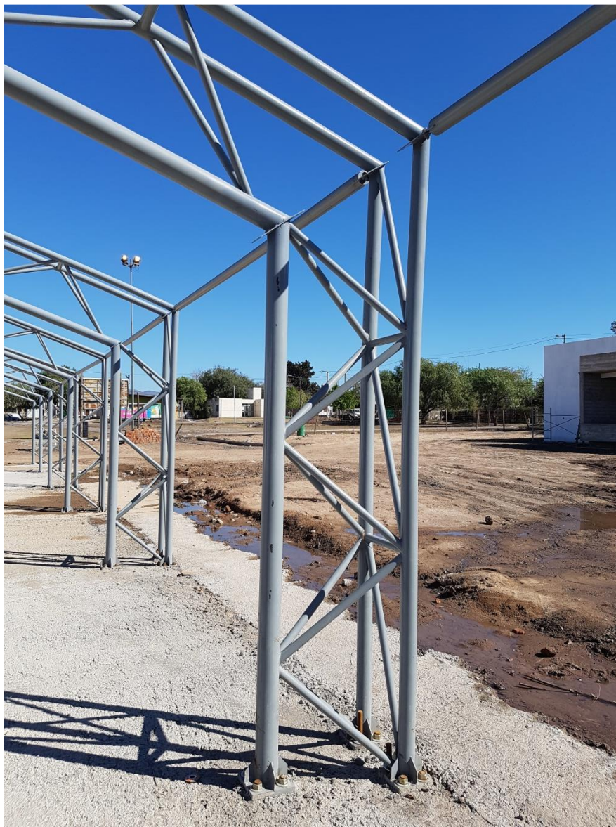
Fig.45 Imagen de columna reticulada tomada en el parque noroeste
