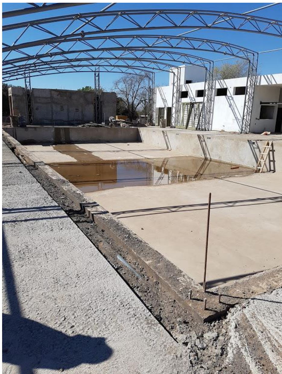
Fig.54 Imagen de la estructura de pileta y vestuarios tomada en el parque noroeste
