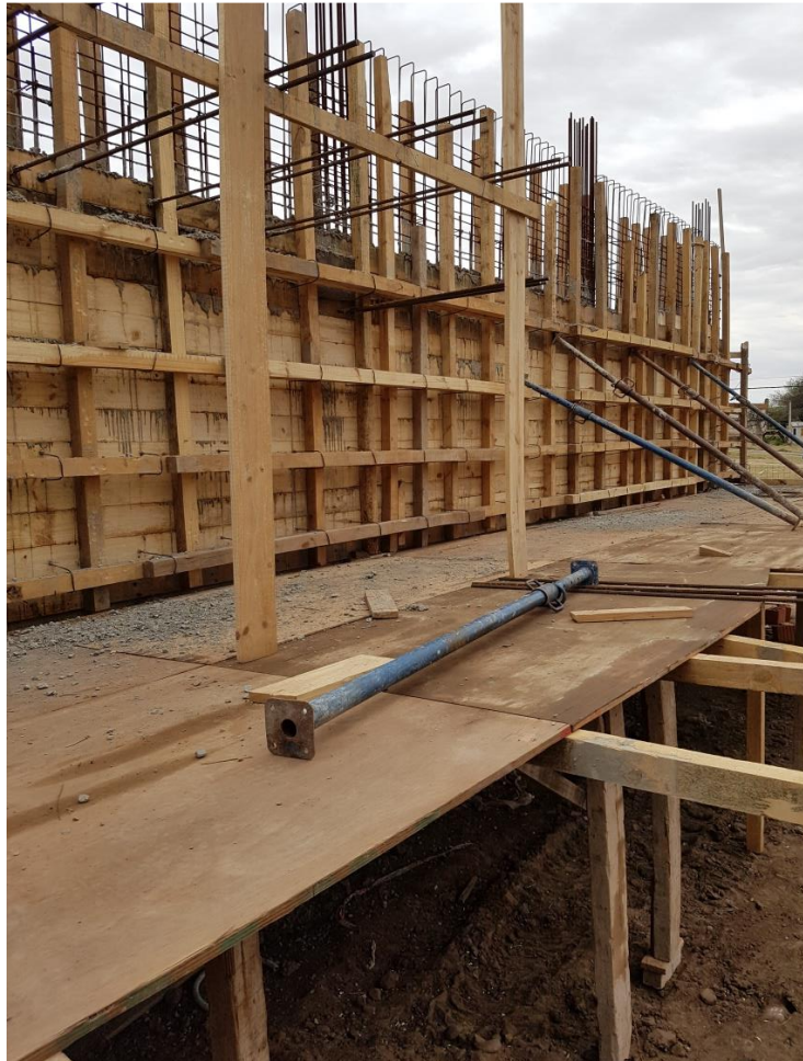
Fig.80 Imagen de encofrados para tabiques de hormigón con armadura en espera
