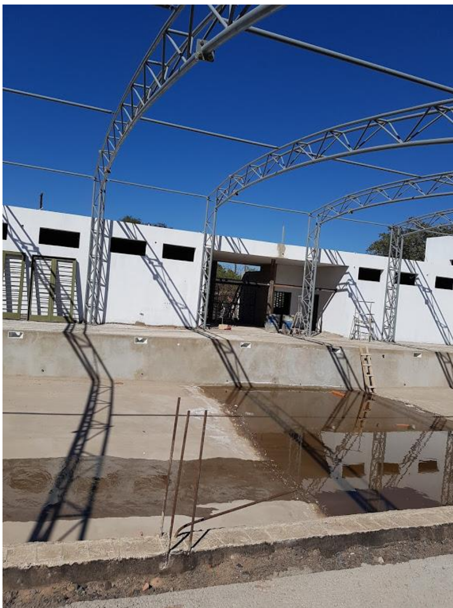
Fig.43 Imagen de cubierta metálica de pileta tomada en el parque noroeste
