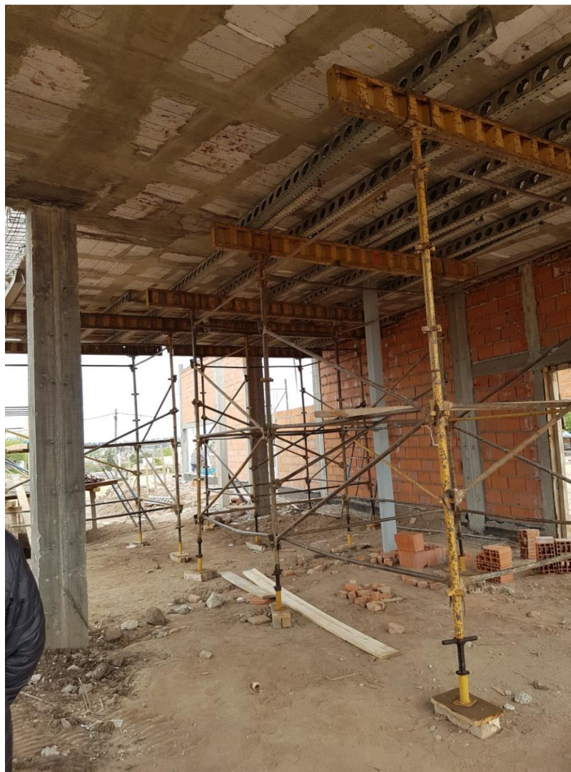
Fig.79 Imagen de encofrados tipo efco y losa nervurada en dos direcciones – parque este
