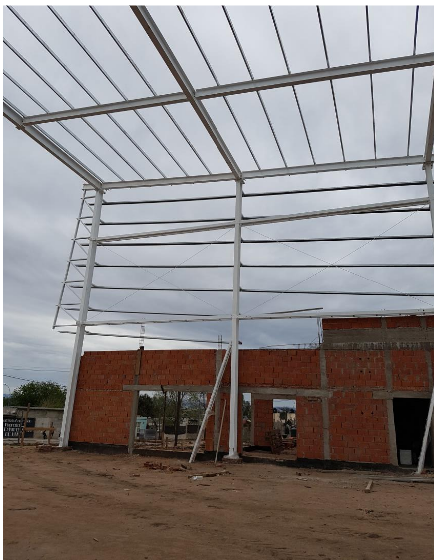
Fig.67 Estructura metálica y cerramiento de mampostería – SUM parque este
