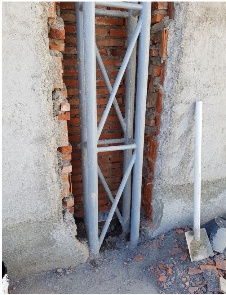
Fig.58 Imagen de columna empotrada dentro de la pared tomada en el parque noroeste
