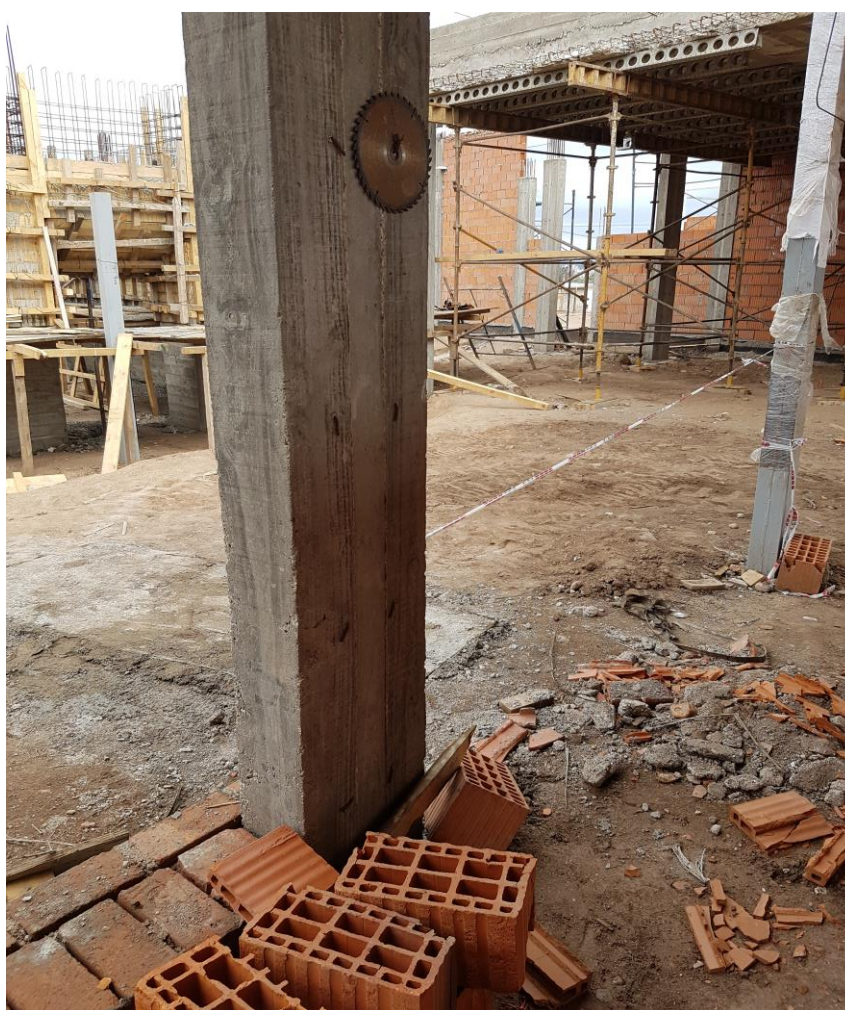
Fig.71 columnas de H°A° y metálicas en el parque de zona este
