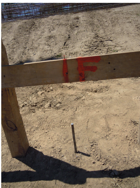
Fig. 3.7 y 3.8 Trabajos de replanteo – Fuente: Fotografía propia
