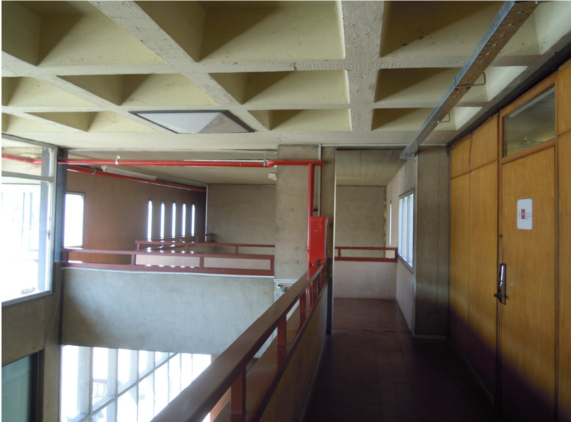
Fig. 2.3 Emplazamiento – Fuente: Fotografía propia
