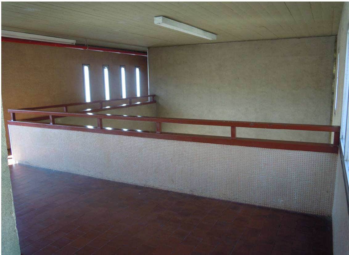
Fig.2.4 Emplazamiento – Fuente: Fotografía propia
