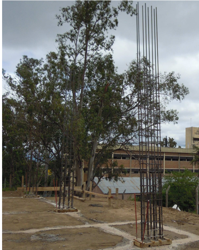
Fig. 3.23 Armadura de columnas – Fuente: Fotografía propia
