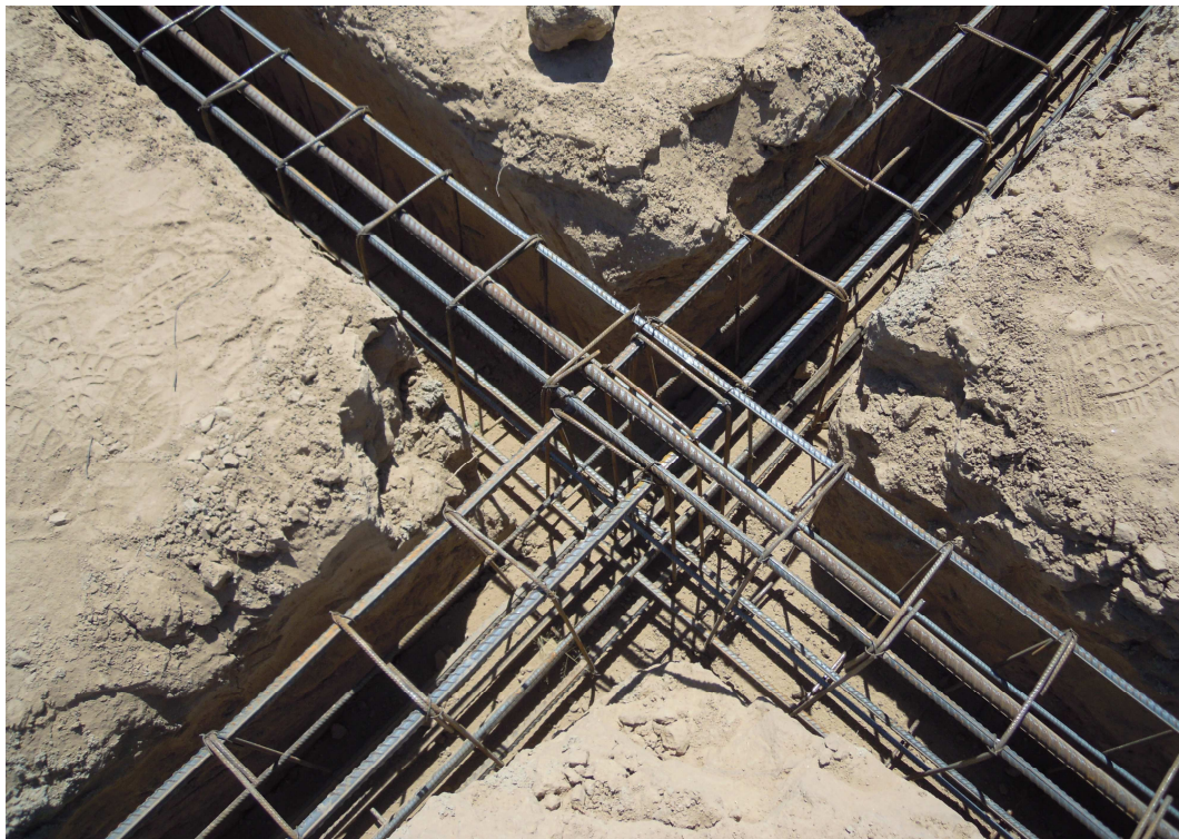
Fig. 3.18 Vigas riostras – Fuente: Fotografía propia
