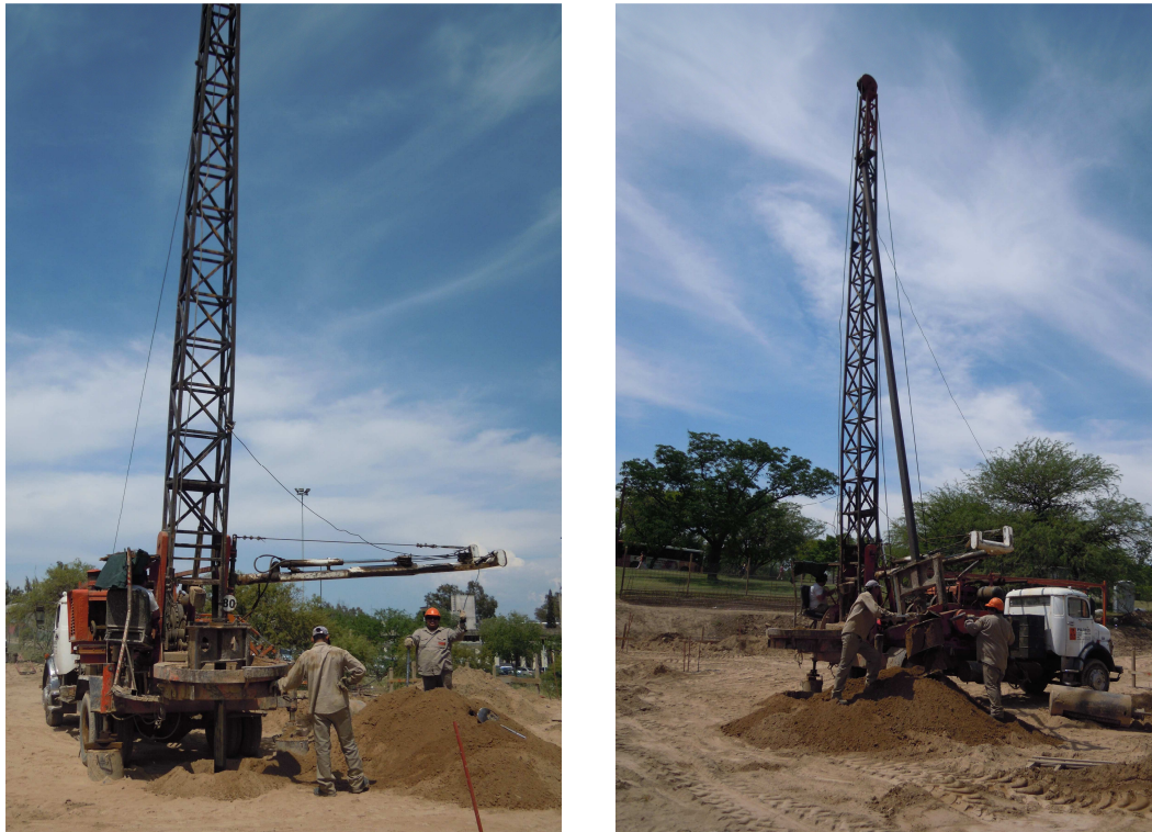
Fig. 3.9 y 3.10 Excavado de pozos – Fuente: Fotografía propia
