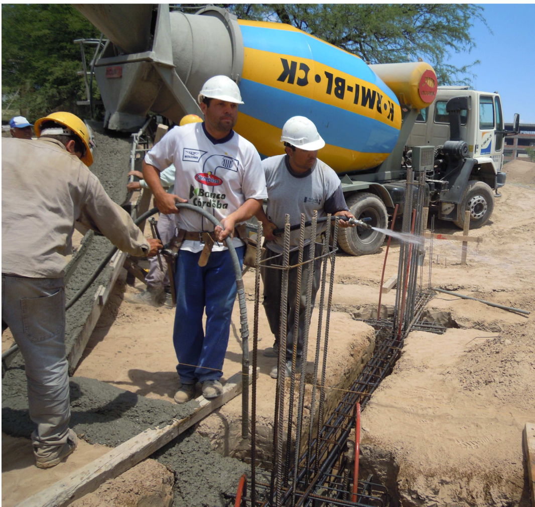
Fig. 3.20 Hormigonado de cabezales y vigas riostras – Fuente: Fotografía propia
