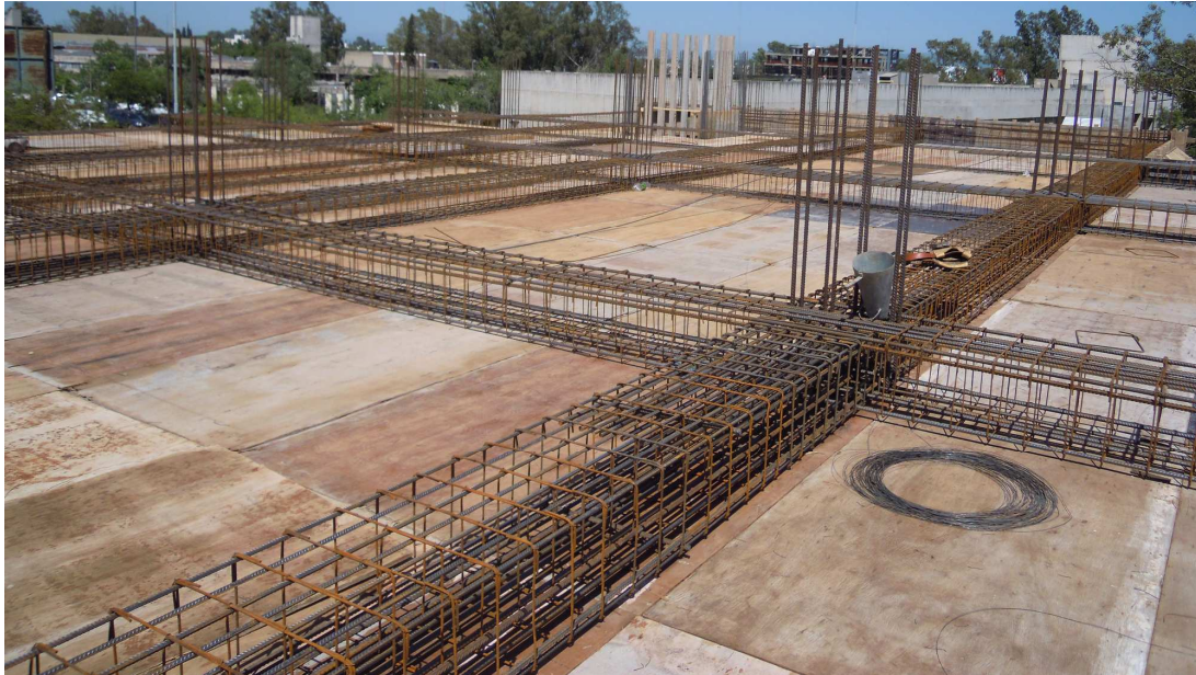
Fig. 3.30 Armaduras de losa – Fuente: Fotografía propia
