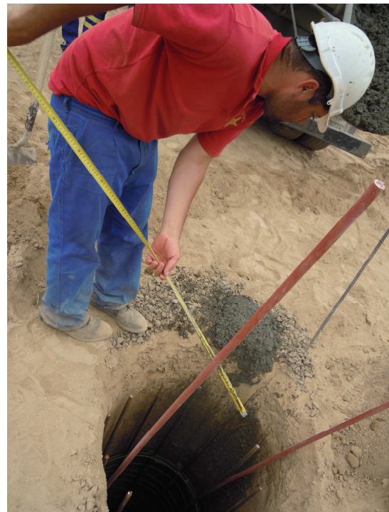
Fig. 3.15 y Fig. 3.16 Hormigonado de pilotes – Fuente: Fotografía propia
