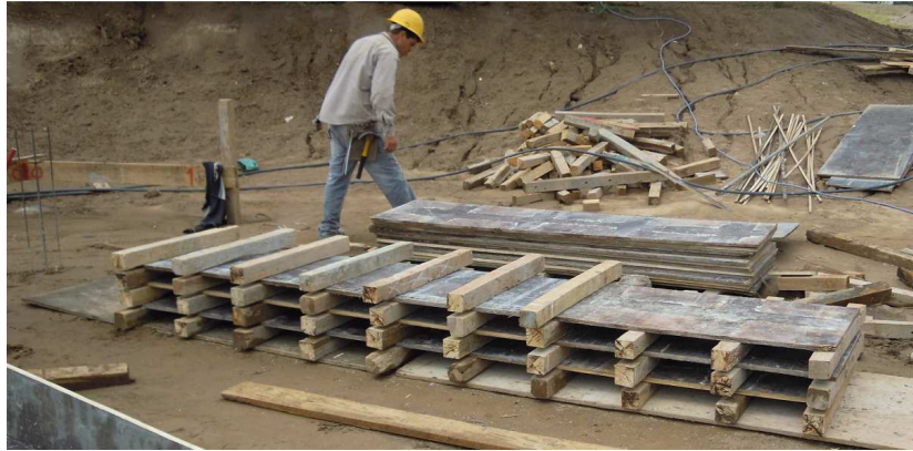
Fig. 3.24 Encofrado para columnas – Fuente: Fotografía propia
