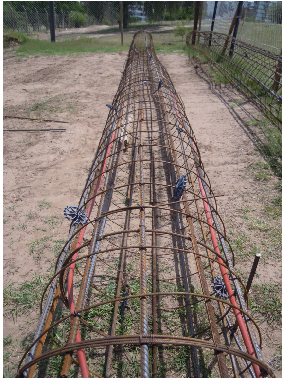
Fig. 3.12 Armadura para pilotes – Fuente: Fotografía propia
