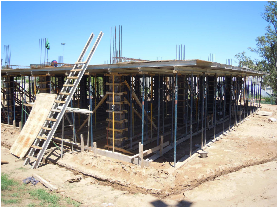
Fig. 3.28 Encofrado de losa – Fuente: Fotografía propia
