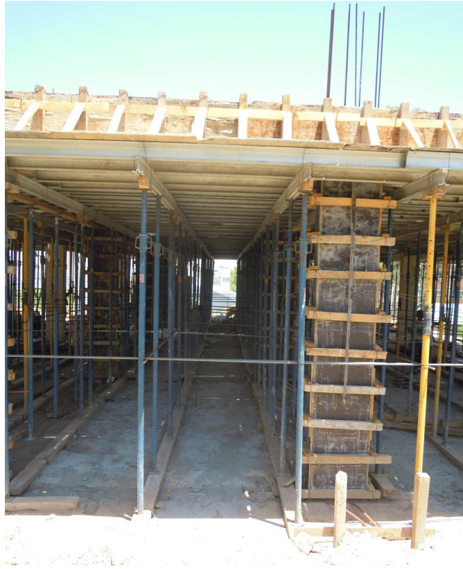
Fig. 3.29 Encofrado de losa – Fuente: Fotografía propia
