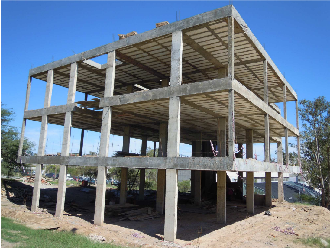
Fig. 3.34 Estructura terminada – Fuente: Fotografía propia
