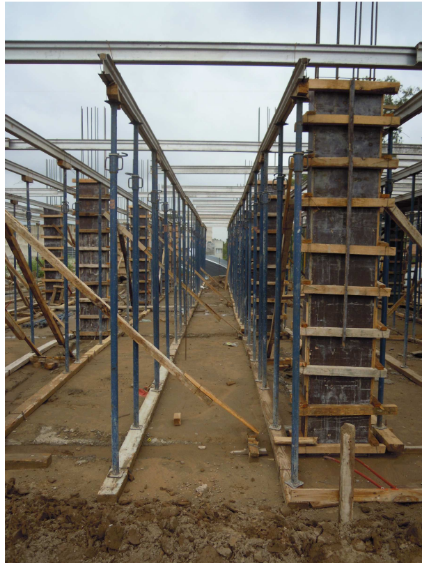
Fig. 3.26 Encofrado de losa – Fuente: Fotografía propia
