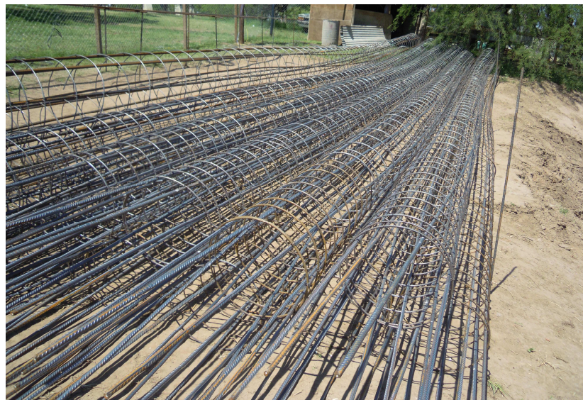
Fig. 3.11 Acopio de armaduras para pilotes – Fuente: Fotografía propia
