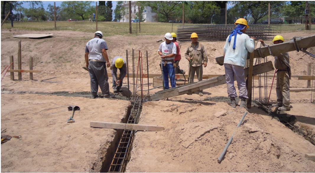
Fig. 3.19 Hormigonado de cabezales y vigas riostras – Fuente: Fotografía propia
