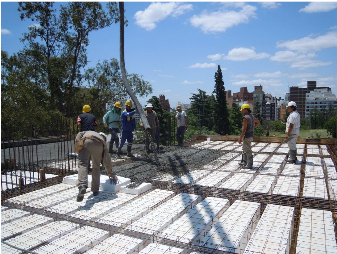
Fig. 3.33 Hormigonado de losa – Fuente: Fotografía propia
