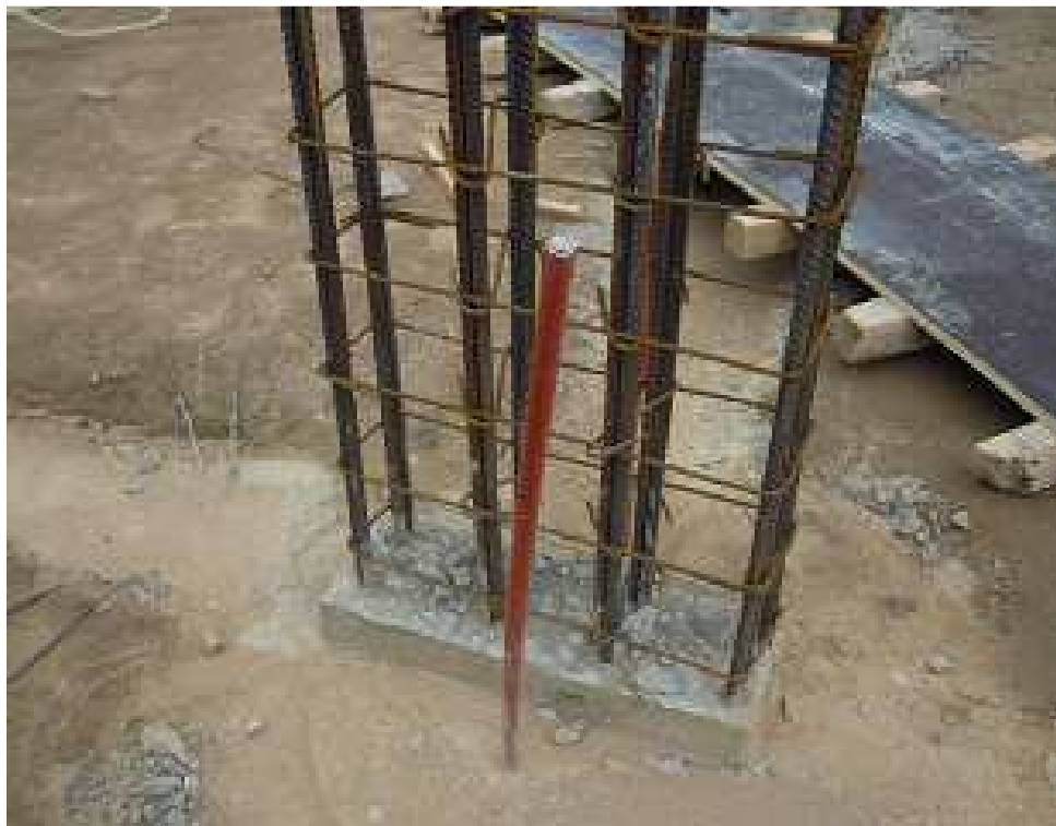
Fig. 3.22 Dado de columnas – Fuente: Fotografía propia
