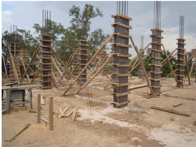
Fig. 3.25 Columnas encofradas – Fuente: Fotografía propia
