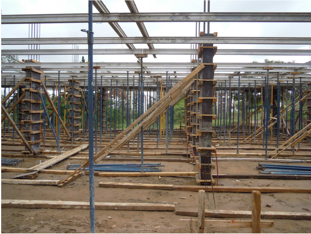
Fig. 3.27 Encofrado de losa – Fuente: Fotografía propia
