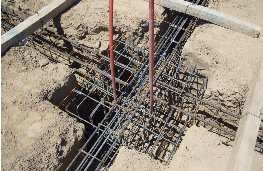
Fig. 3.17 Cabezales y vigas riostras – Fuente: Fotografía propia
