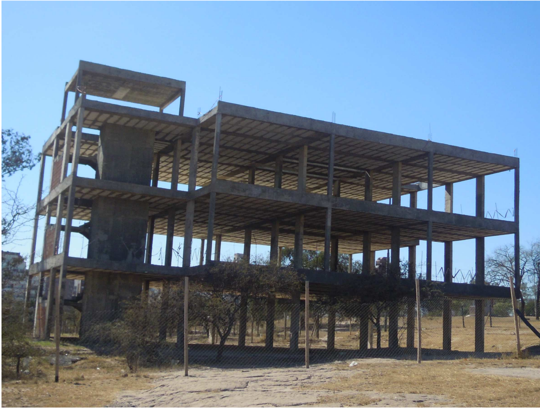
Fig. 3.36 Estructura terminada – Fuente: Fotografía propia
