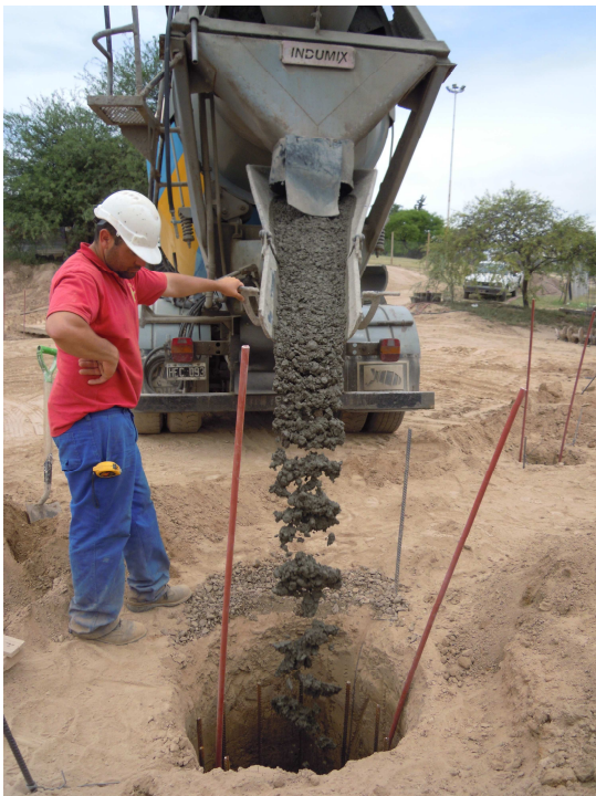
Fig. 3.15 y Fig. 3.16 Hormigonado de pilotes – Fuente: Fotografía propia
