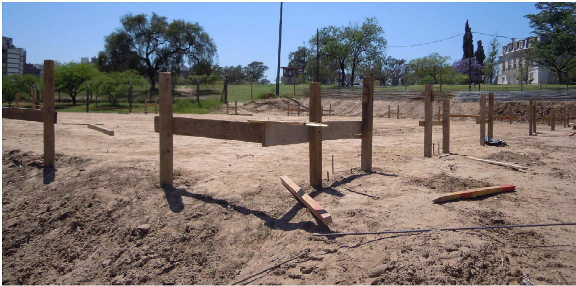
Fig. 3.6. Trabajos de replanteo – Fuente: Fotografía propia
