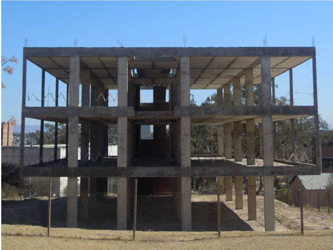
Fig. 3.35 Estructura terminada – Fuente: Fotografía propia
