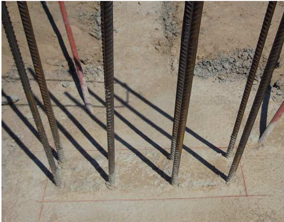
Fig. 3.21 Replanteo de columnas – Fuente: Fotografía propia
