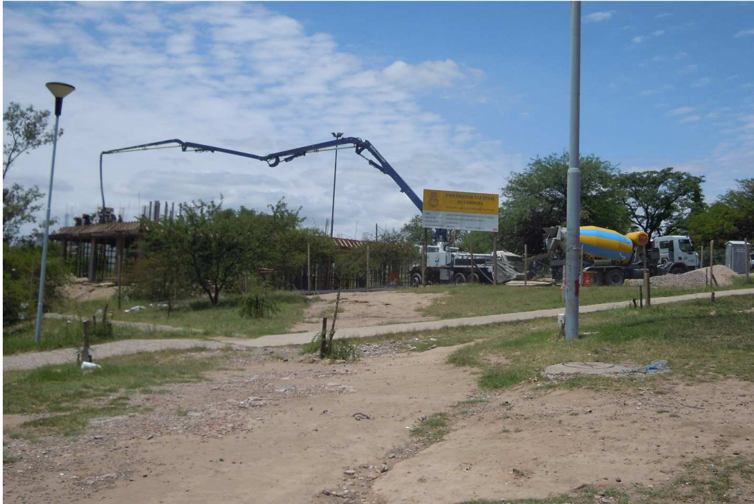
Fig. 3.32 Hormigonado de losa – Fuente: Fotografía propia
