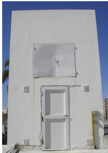
Figura 3.8: Sala de máquinas
