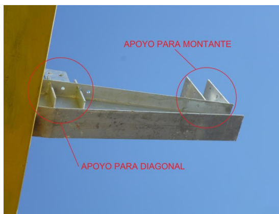
Fotografía N° 10 “Ménsula con rigidizadores”
