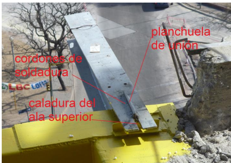
Fotografía N° 3 "ménsula sujeta a viga metálica"
