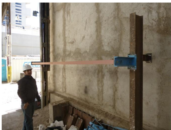
Fotografía N° 5 "Lama montada para realizar ensayo en obra"
