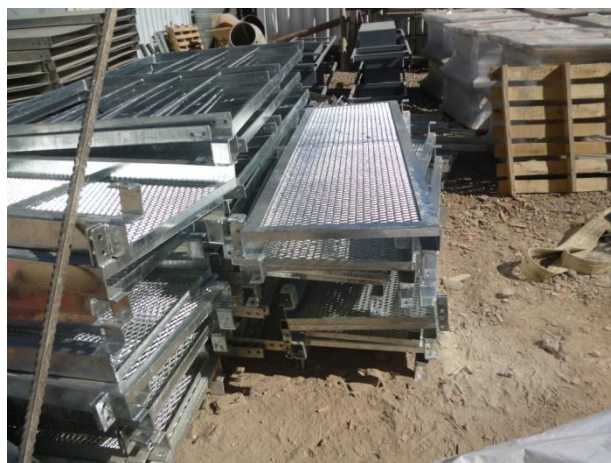
Fotografía N° 7 "Pasarelas antes del montaje"
