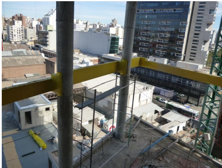
Fotografía Nº 9 "VM6 en el nivel 6"
