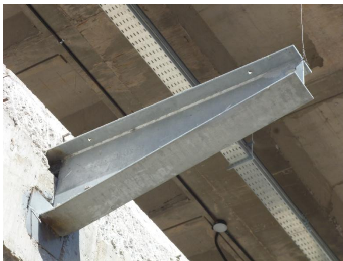
Fotografía Nº 4 "Ménsula sujeta a viga perimetral de hormigón"
