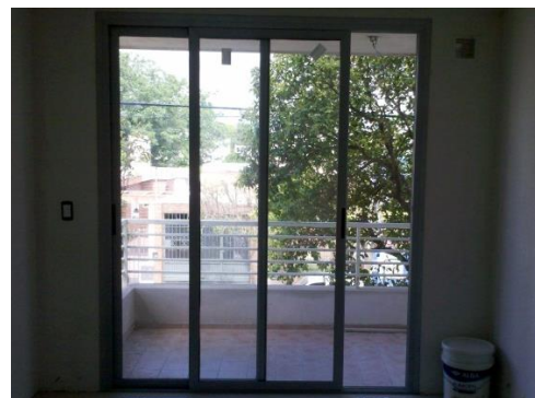
Figura 21: Colocación de aberturas (2)
