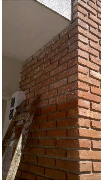
Figura 126: Trabajo de limpieza de ladrillo visto
