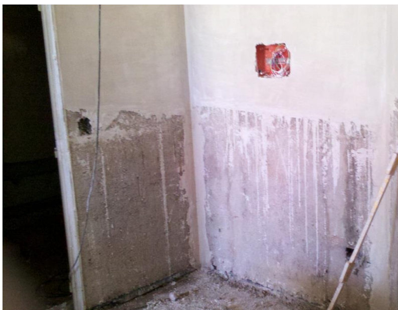
Figura 7: Trabajos de enlucido de yeso
