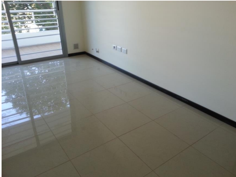
Figura 19: Colocación de porcelanato
