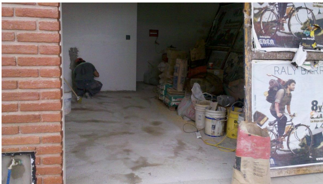
Figura 9: Colocación de cerámicos, limpieza previa – Local comercial
