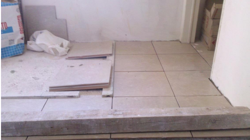
Figura 10: Colocación de cerámicos - Palier
