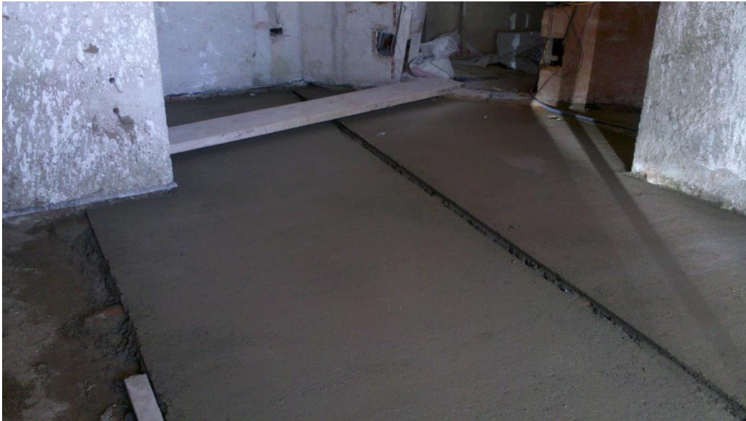
Figura 8: Carpeta de nivelación en local comercial
