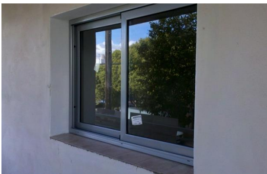
Figura 20: Colocación de aberturas (1)
