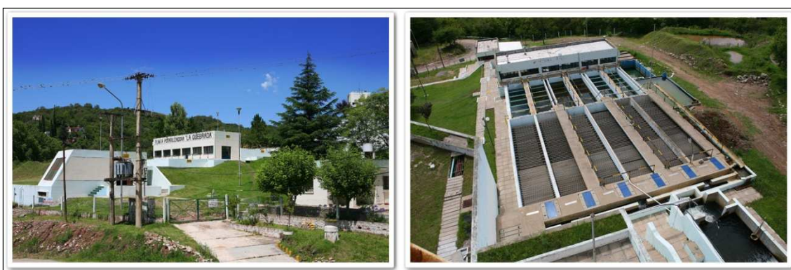
Foto 1: Planta Potabilizadora “La Quebrada”
