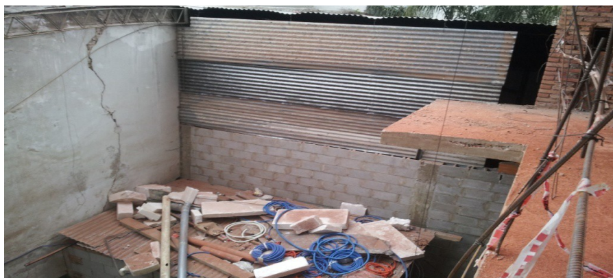
Aquí se observa la solución provisoria para cerrar la propiedad vecina
