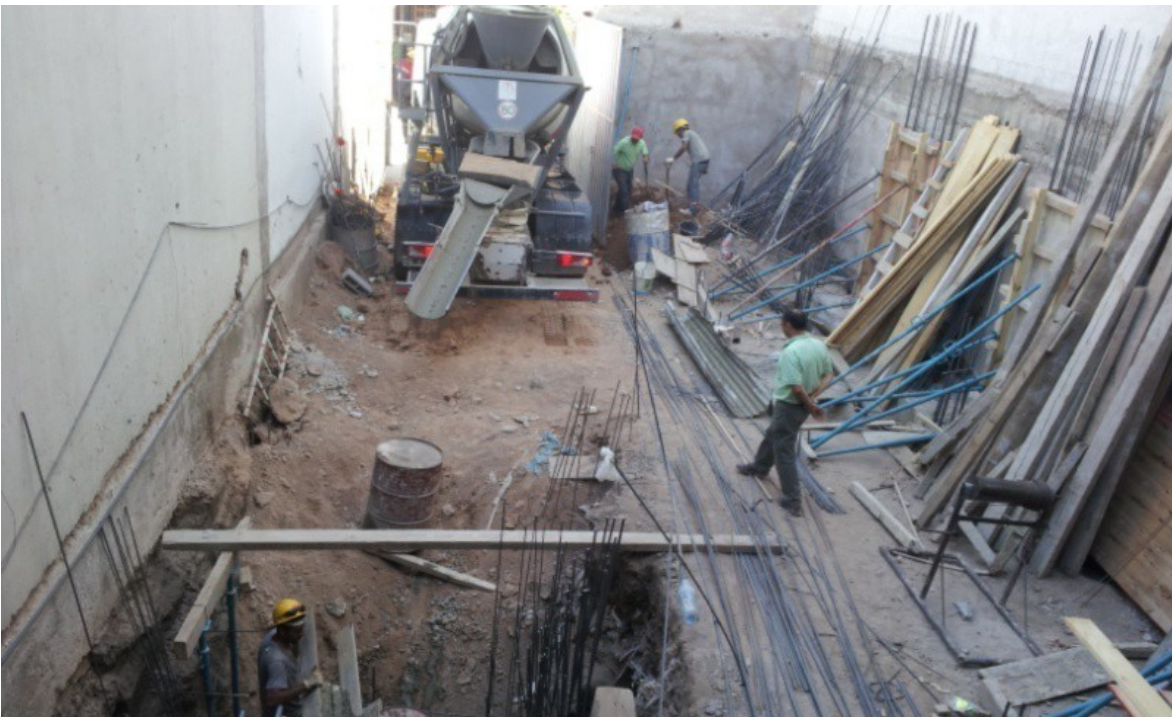
En esta imagen se observa el ingreso de los camiones moto hormigoneros a la obra
