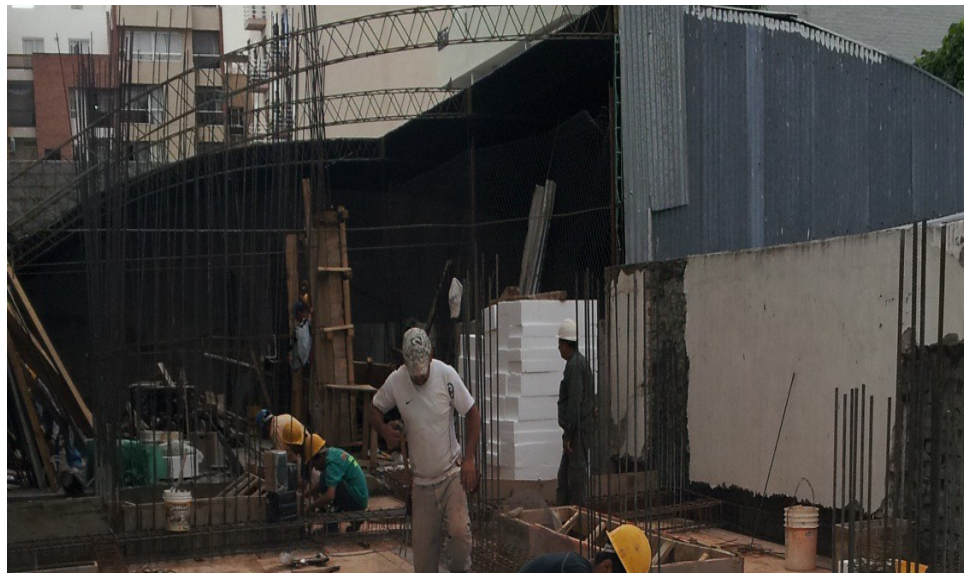
En esta imagen se observa cómo se desmonta y se corta el tinglado
