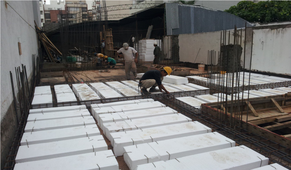
En esta imagen se observa detalle de la disposición de las armaduras en losas casetonadas
