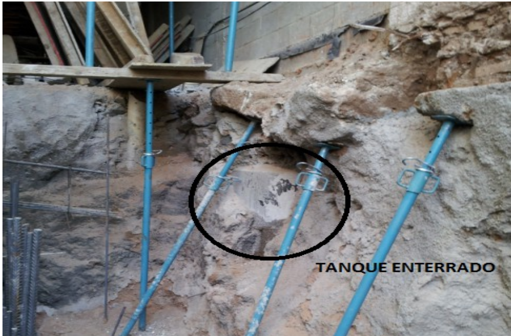
Imagen en donde se muestra la posición del tanque de plástico enterrado
