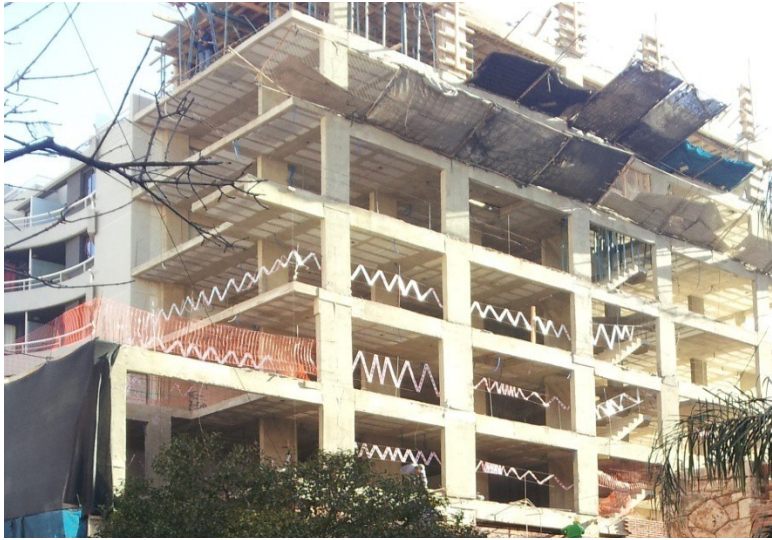
En esta imagen se observa las medidas de protección en altura
