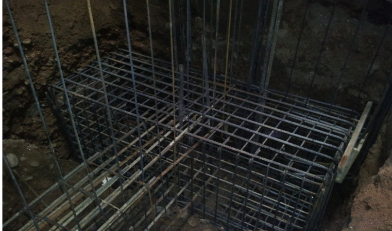
En la siguiente imagen se observa la disposición de las armaduras en los cabezales y vigas riostras del subsuelo
