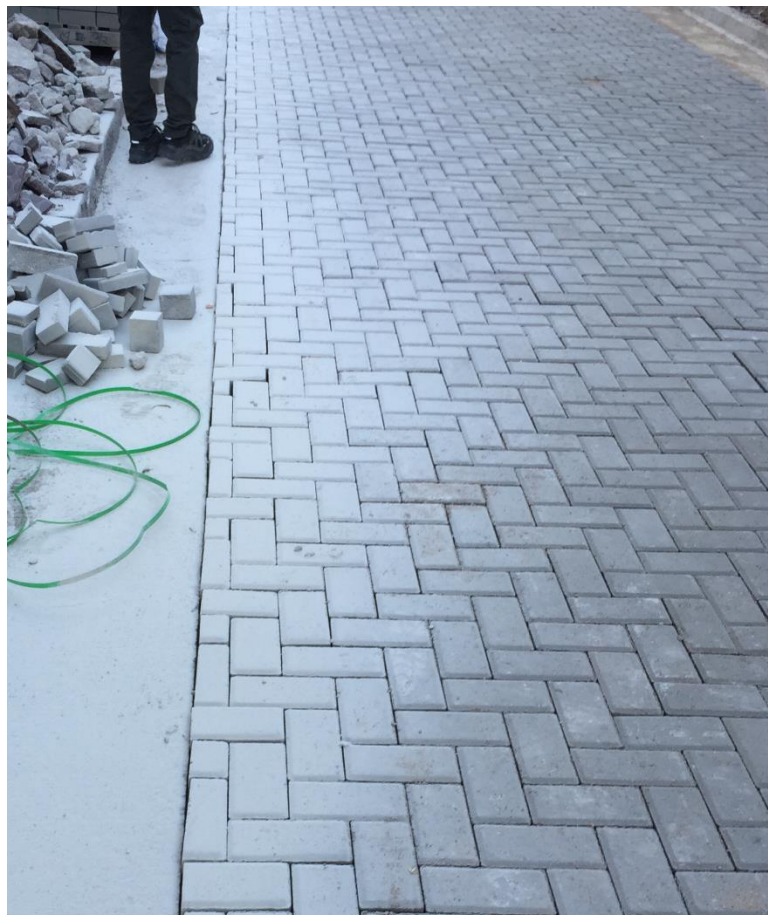
Vemos también como los cortes se realizaron con amoladora equipada con un disco para Hormigón.
