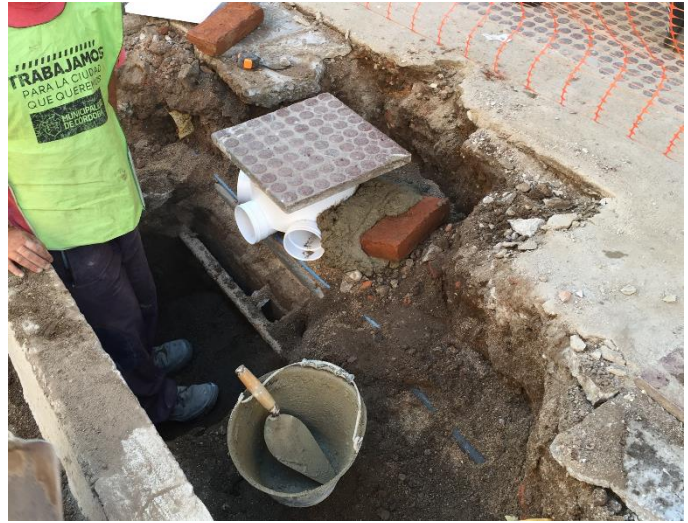
Disposición de las cámaras de inspección. Para dejarlas a nivel, se dispusieron reglas metálicas entre el cordón y la línea de edificación.
