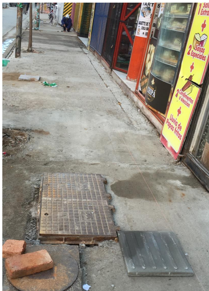
Debió ejecutarse primero la línea de vainillas, las rampas con su perímetro de mosaicos de puntos para luego incorporar los mosaicos estándar en el resto del área, con sus cortes correspondientes.
