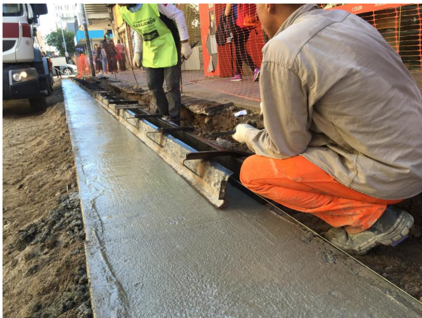
Imagen de la cuneta hormigonada, con el anti-sol ya rociado.
