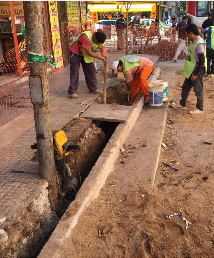
Disposición de las cámaras de inspección. Para dejarlas a nivel, se dispusieron reglas metálicas entre el cordón y la línea de edificación.
