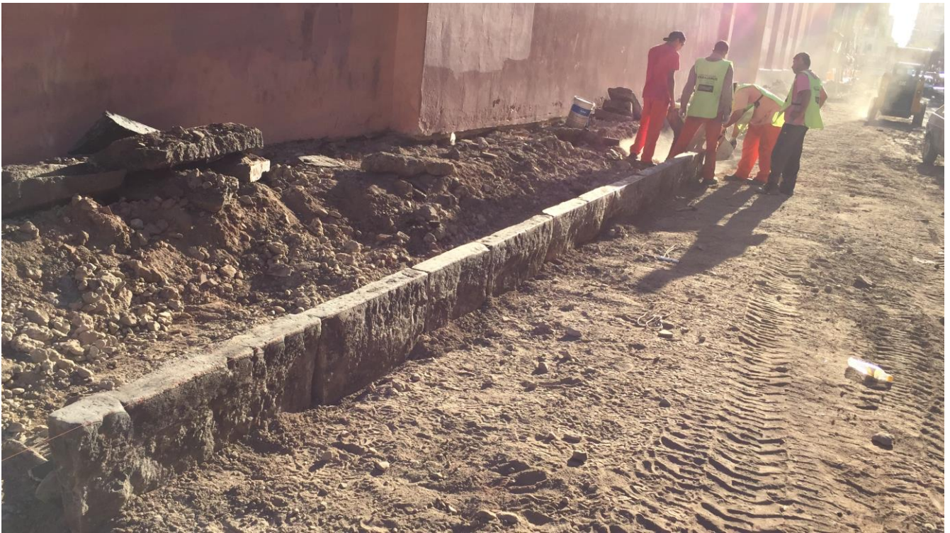
Esta tarea llevó su tiempo, debido al gran peso de cada piedra que requería ser levantada por 4 operarios, calzandola y dejándola a nivel.
