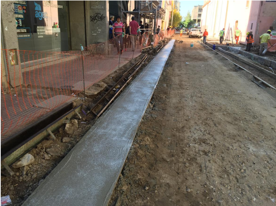
Imagen de la cuneta hormigonada, con el anti-sol ya rociado.
