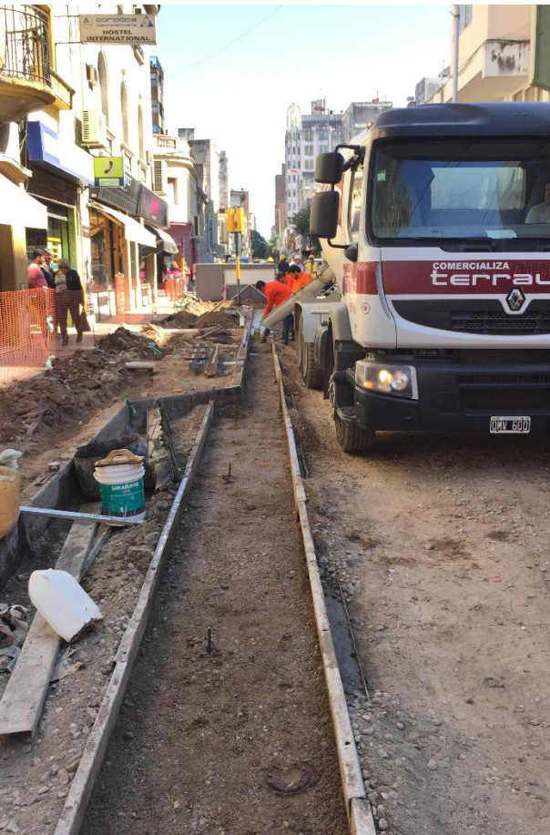
Se realizaron las juntas de dilatación clavando vainas, y luego se rellenaron los moldes del cordón, penetrando con la cuchara para evitar hoquedades.
