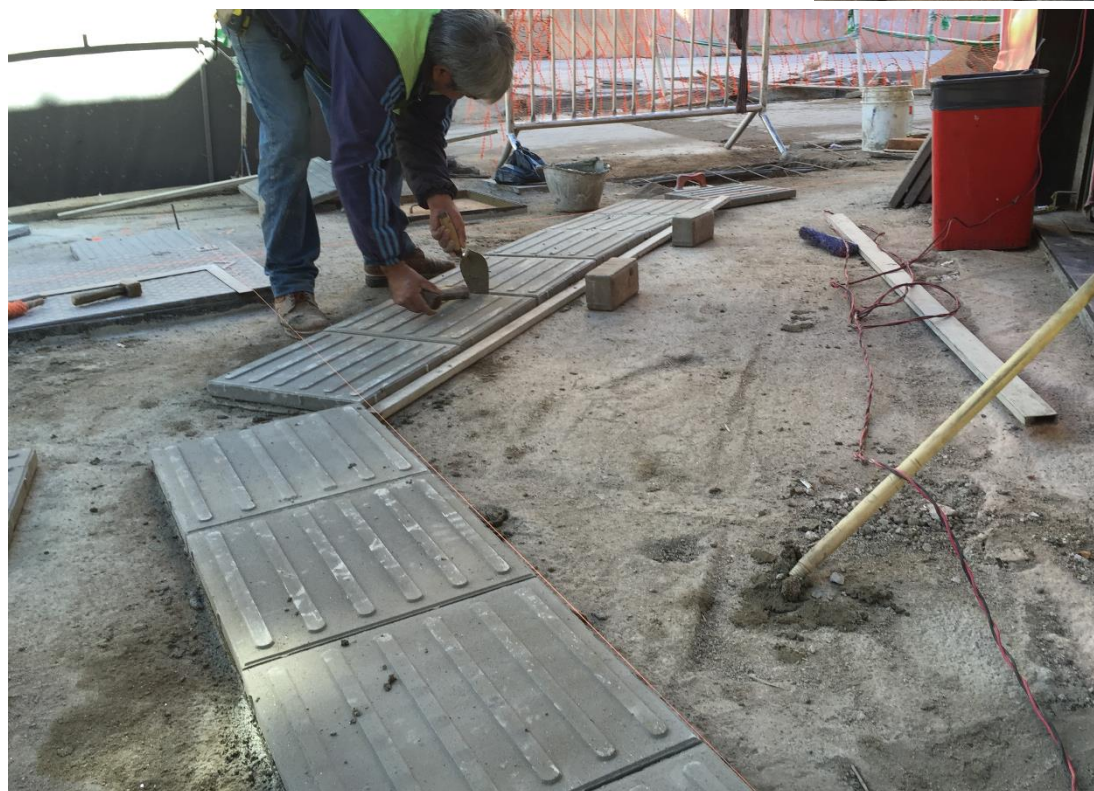
Debió ejecutarse primero la línea de vainillas, las rampas con su perímetro de mosaicos de puntos para luego incorporar los mosaicos estándar en el resto del área, con sus cortes correspondientes.
