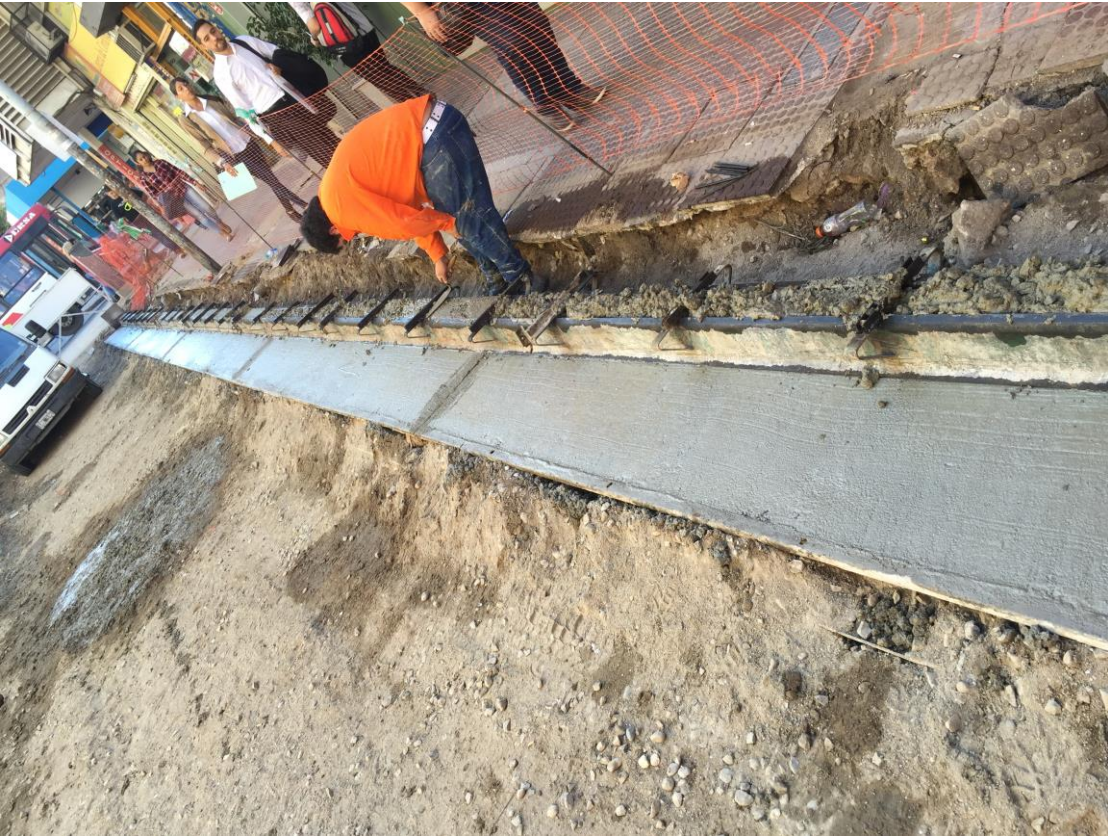
Se realizaron las juntas de dilatación clavando vainas, y luego se rellenaron los moldes del cordón, penetrando con la cuchara para evitar hoquedades.
