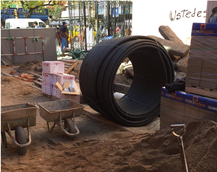
Rollo de tritubo entregado por la empresa encargada de la instalación de luminarias contratada por Estudio Roganti.
