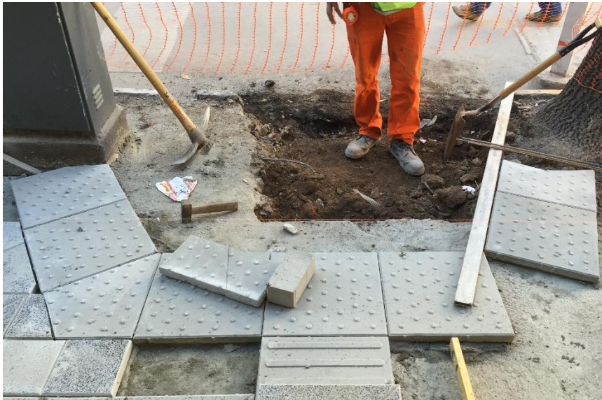
En las siguientes imágenes se puede ver el replanteo y elaboración de las rampas.
