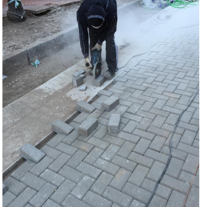
Vemos también como los cortes se realizaron con amoladora equipada con un disco para Hormigón.
