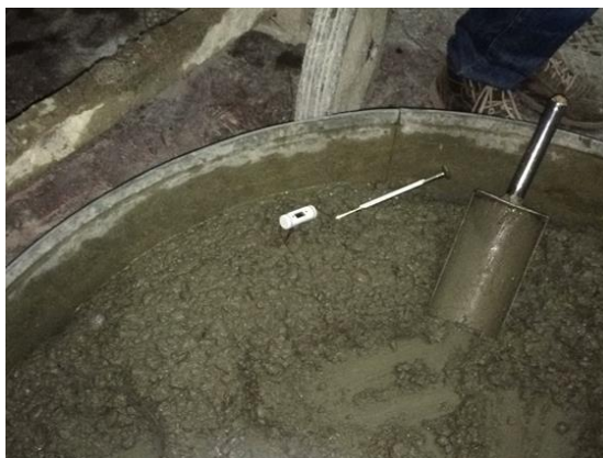
Figura N°18: Medición de la Temperatura del Hormigón en estado fresco.
