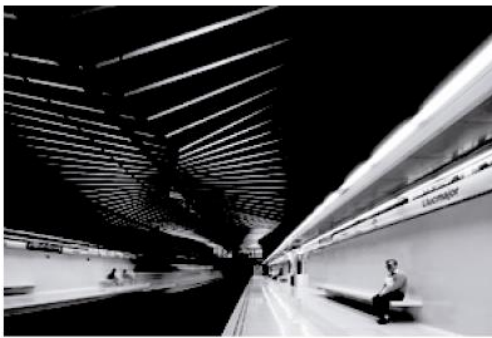
22. Estación de Metro de Lluçmajor | Barcelona | 2006 | 71.
