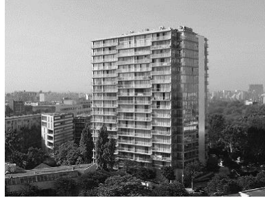
Lacaton & Vassal Torre de viviendas Bois-le-Prete París, Francia 2005-2011
