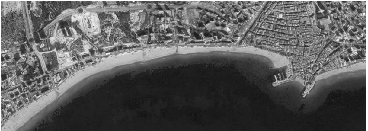
Figura 47: Fotografía aérea del Paseo Marítimo.
