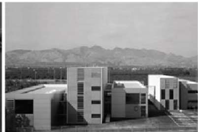
21: u: Castellón. d: PARQUE TECNOLÓGICO IMPIVA. a: C. Ferrater, C. Bento y J. Sanahuja. EPU p: 1993. r: 1995.
