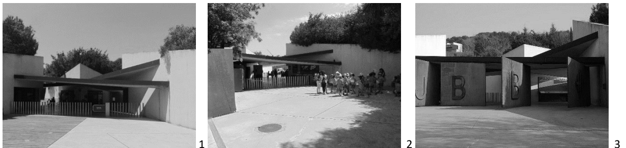
Figura 42: 1-3. Fotografías de edificio de ingreso al Jardín Botánico.
