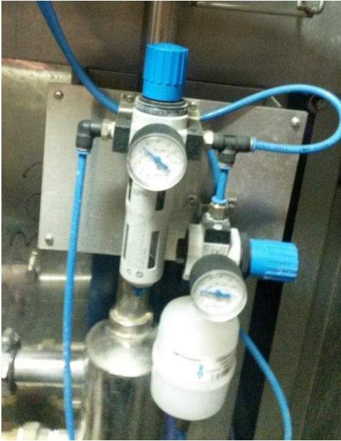
Ilustración 9.1.8 Fotografía del regulador de presión de aire comprimido de línea y puerta.
