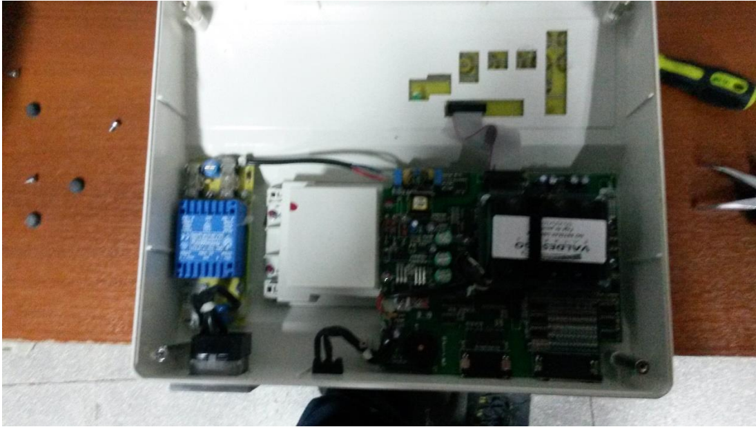
Ilustración 9.6.7 Limpieza interna del ecg.
