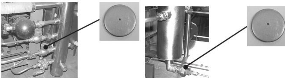
Ilustración 9.1.5 Limpieza de los pasos restringidos de la cañería
