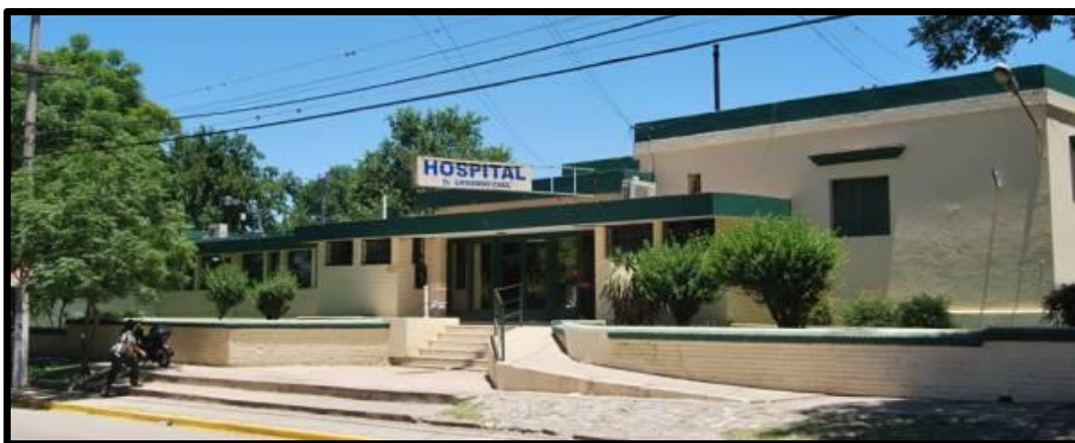
Figura 5.2 - Fachada del Hospital.
