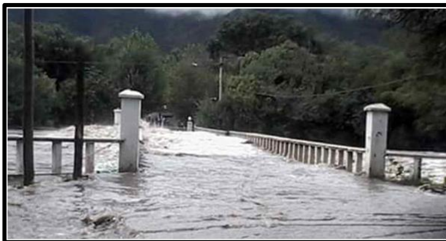
Figura 3.5 - Puente que conecta al Hospital Domingo Funes rebalsado.
