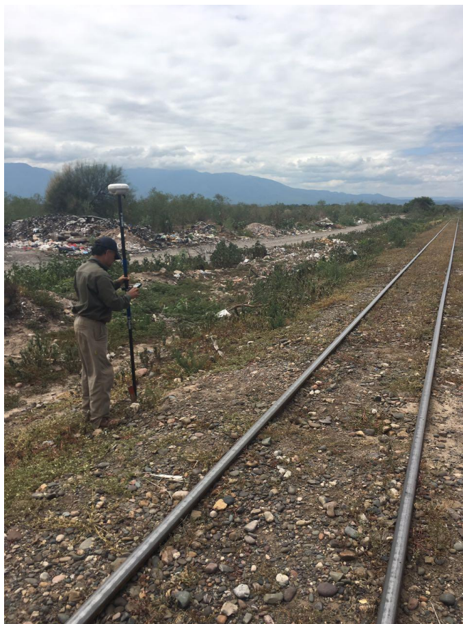
Figura 5.9: Ejecución del relevamiento planialtimétrico de los piquetes.
