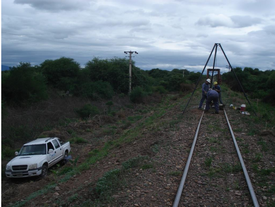
Figura 5.4: Ejecución del ensayo de SPT.
