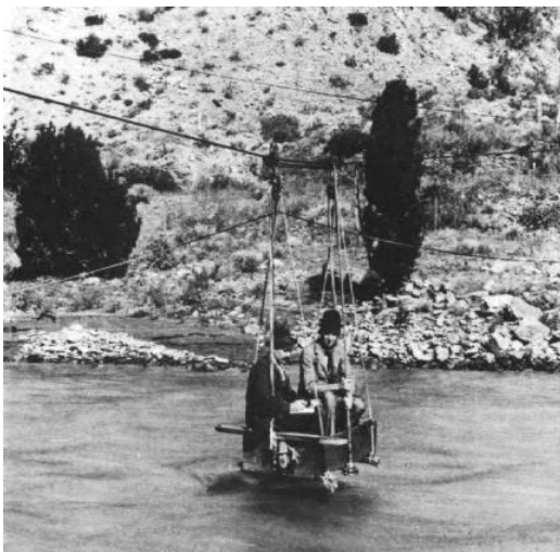
Figura I.8 Aforo con molinete desde un cable carril en 1880 a la izquierda, en 1996 a la derecha (imágenes USGS).
