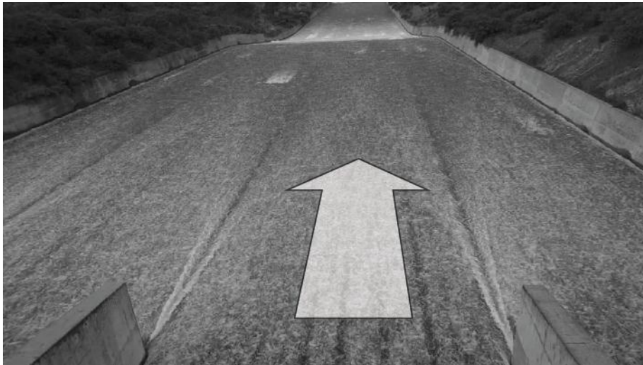
Figura IX.2 Sitio de medición utilizado para la cuantificación y caracterización del campo de velocidad de flujo en la estructura de descarga de excedentes hídricos de la Presa Arroyo Corto.
