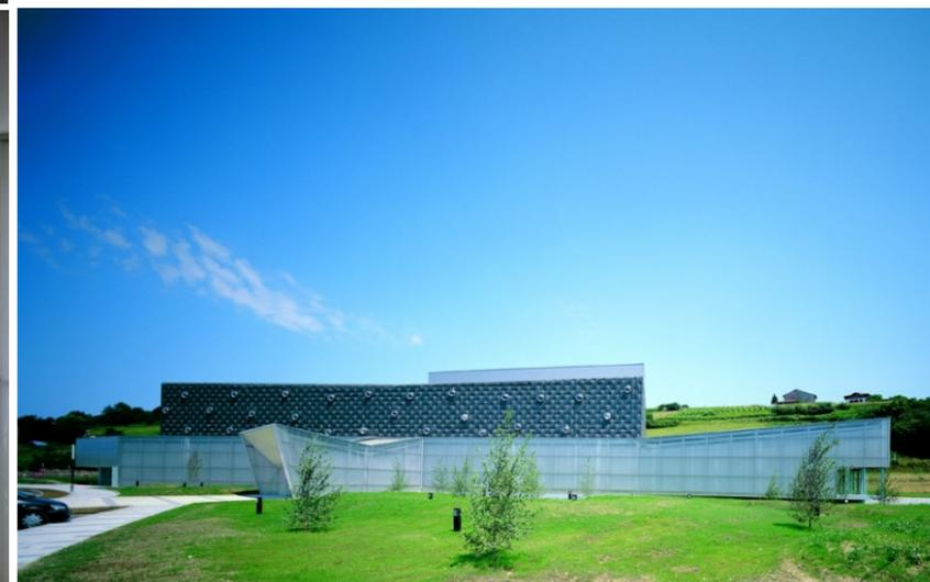
Para el volumen superior se utiliza un sistema tipo cubierta deck con un aislamiento de baja densidad y 10 cms de espesor que, anclado mecánicamente a la chapa, ofrece un aspecto de sofá "chester" durante el día y de cielo estrellado durante la noche gracias a la luz tamizada por las claraboyas.
