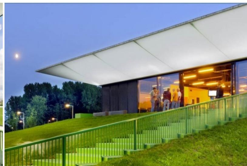
El espacio final del edificio es traslúcido y consta de un techo en voladizo. Este techo filtra la luz solar directa e ilumina y proporciona luz a la noche gracias a la integración de la iluminación LED.
