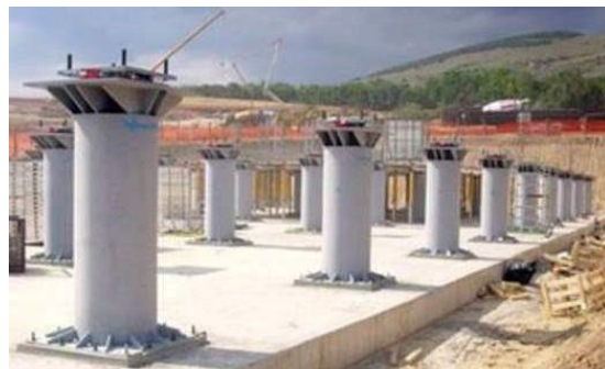
Figuras 20, 21. Sistema de fundación. Placas de hormigón, columnas prefabricadas de acero y aisladores sísmicos.
