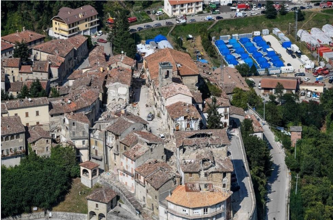
Figura 11. Tiendas instaladas en Arquata del Tronto, Marcas, para refugiar a los afectados a diez días del terremoto del 24 de agosto de 2016.
