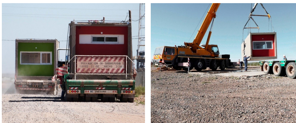
Figuras 51. Traslado e instalación de las viviendas.
