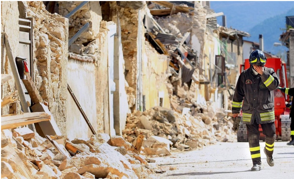
Figura 14. Tareas de los bomberos entre los escombros del centro de la ciudad de L'Aquila luego del terremoto de abril de 2009.
