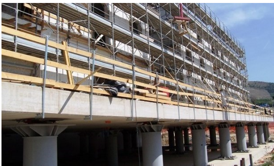
Figuras 20, 21. Sistema de fundación. Placas de hormigón, columnas prefabricadas de acero y aisladores sísmicos.
