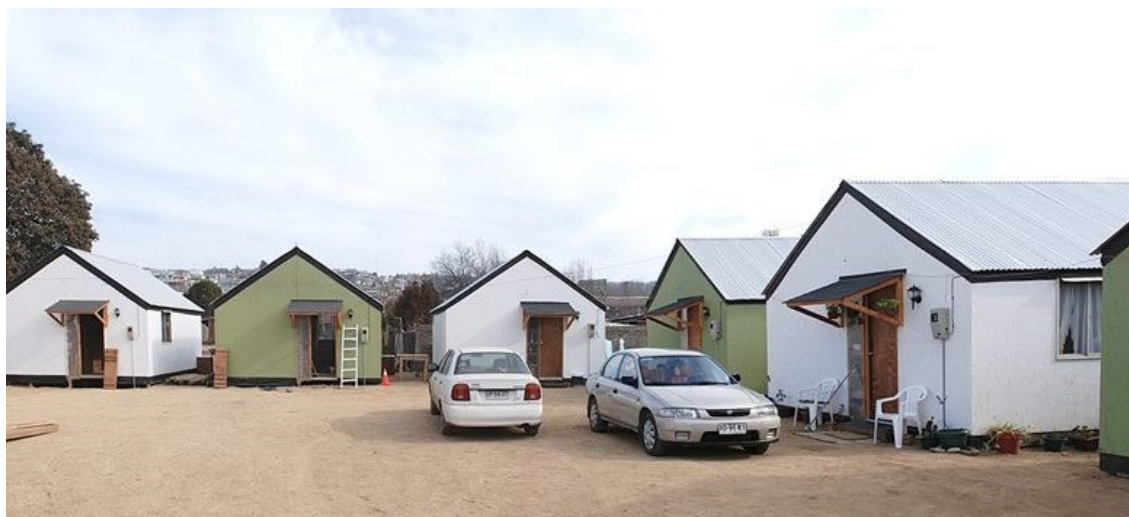
Figura 42. Casas Elemental Tecnopanel, Constitución, Chile, 2010.
