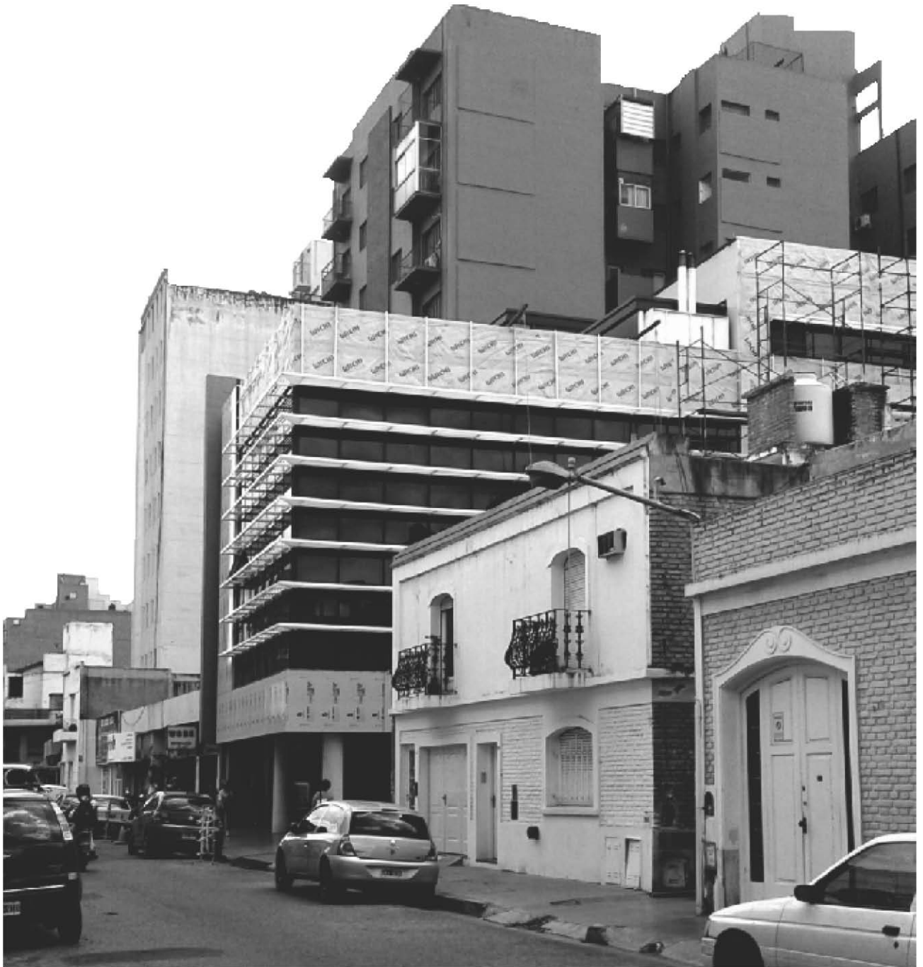
Vista peatonal desde calle Santa Rosa hacia Av. Colon sobre calle Mendoza | B° Alberdi - Ciudad de Córdoba
