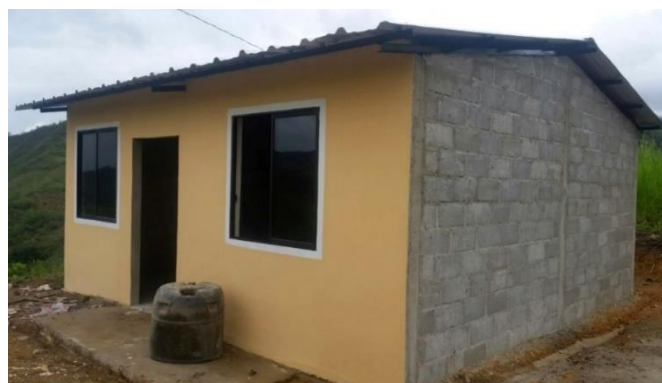
Imagen 36. Vivienda del Proyecto de Vivienda Gestión del Riesgo. Fuente: MIDUVI.
