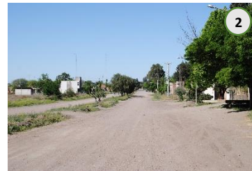
Bv San Martín, no consolidado. Falta de vegetación. Aguaribays no apobados por normativa municipal.
