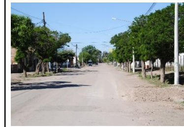
Arboleda en mal estado y no idónea para la habitabilidad y el confort térmico necesario del espacio urbano de los asentamientos mendocinos
