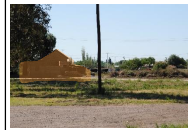
Antigua estación ferroviaria usurpada como vivienda con avanzado estado de deterioro. Baldíos en el eje central de la urbanización.
