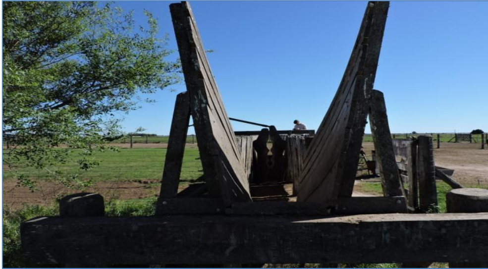
Ilustración 73: Vista de frente del cargadero libre y clara para el embarque y desembarque de animales.
