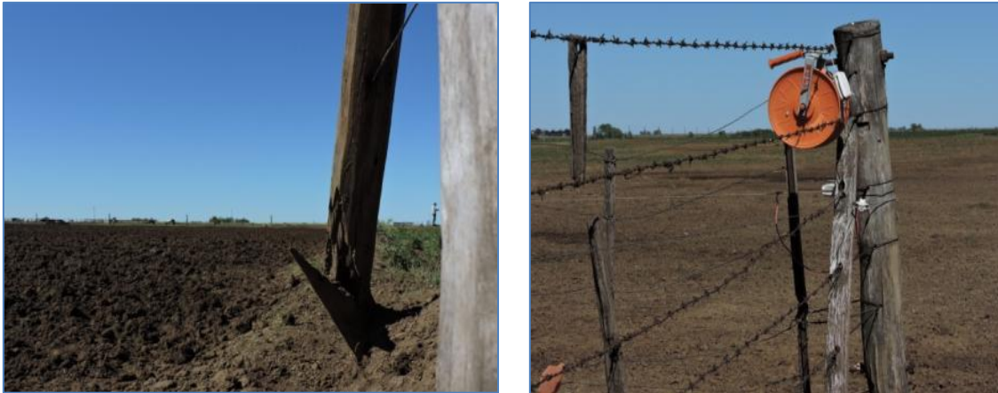
Ilustración 113: Roturas de postes y varillas en corrales de engorde. (Fuente: elaboración propia)
