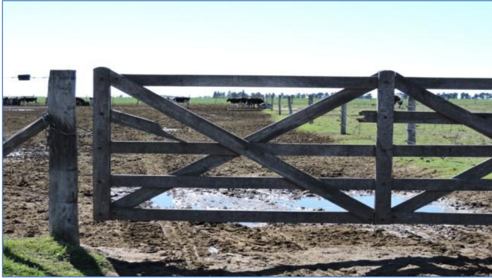
Ilustración 57: Tranqueras de ingreso a los corrales de engorde en malas condiciones.
