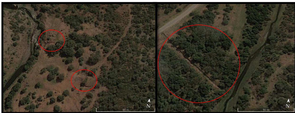
Fig. 28: imagen satelital donde se observan patrones de la erosión en cárcavas en los caminos de los animales hacia el arroyo (izquierda) y en la salida de las alcantarillas (derecha).
