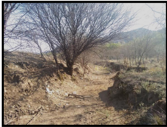
Fig. 23: Erosión en los bordes de la ruta. (Foto: Moisés Fara)
