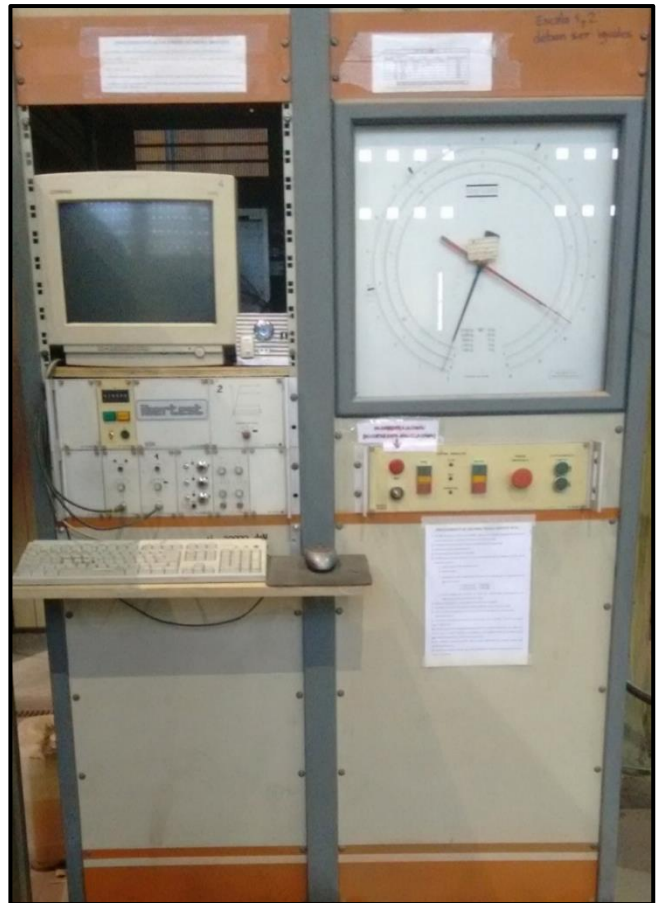
Figura 8.1.2 (b) Elementos de control y maniobras
