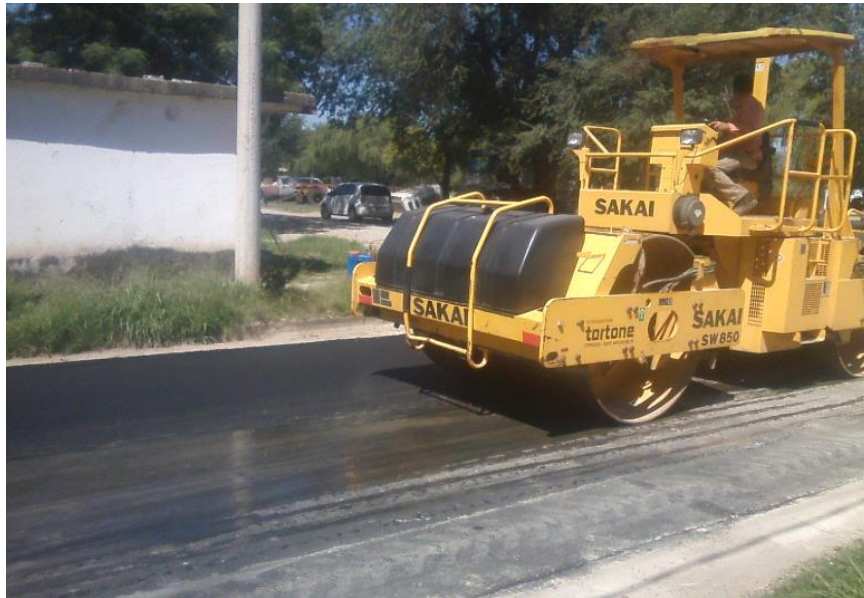
Figura N° 69: Rodillo compactador vibratorio de doble tambor. (Fuente: Elaboración Propia).
