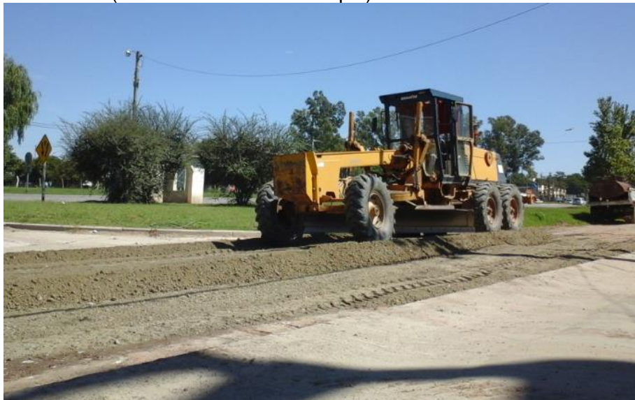
Figura N° 62: Extendido con motoniveladora. (Fuente: Elaboración Propia).
