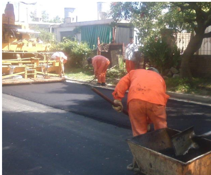
Figura N° 68: Extensión de la mezcla asfáltica. (Fuente: Elaboración Propia).
