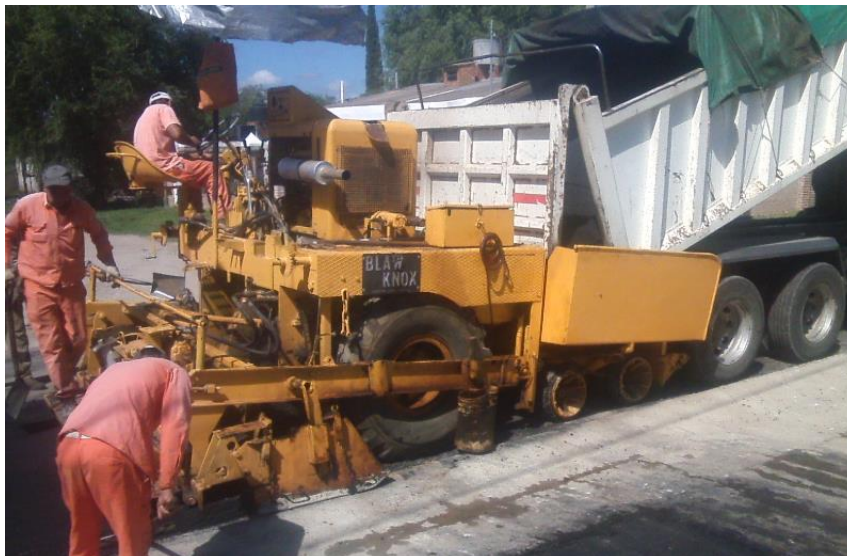
Figura N° 67: Entrega de la mezcla a la terminadora. (Fuente: Elaboración Propia).
