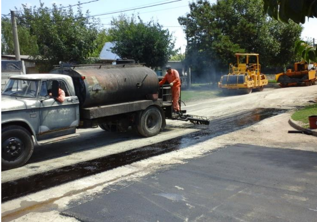
Figura N° 65: Riego de imprimación. (Fuente: Elaboración Propia).
