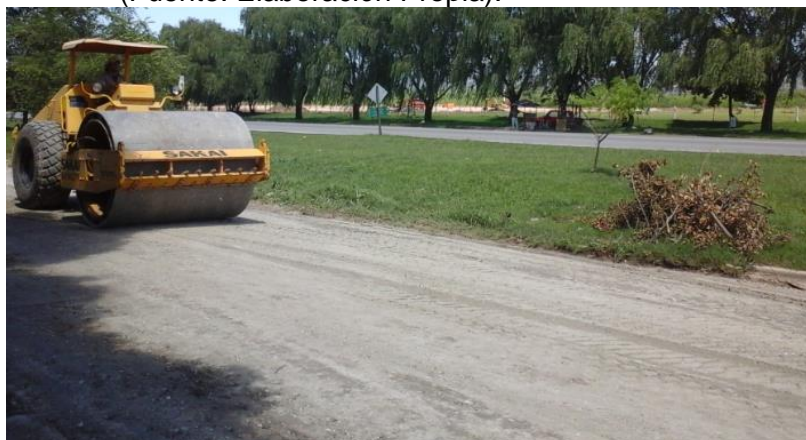
Figura N° 64: Compactación de la subbase granular. (Fuente: Elaboración Propia).
