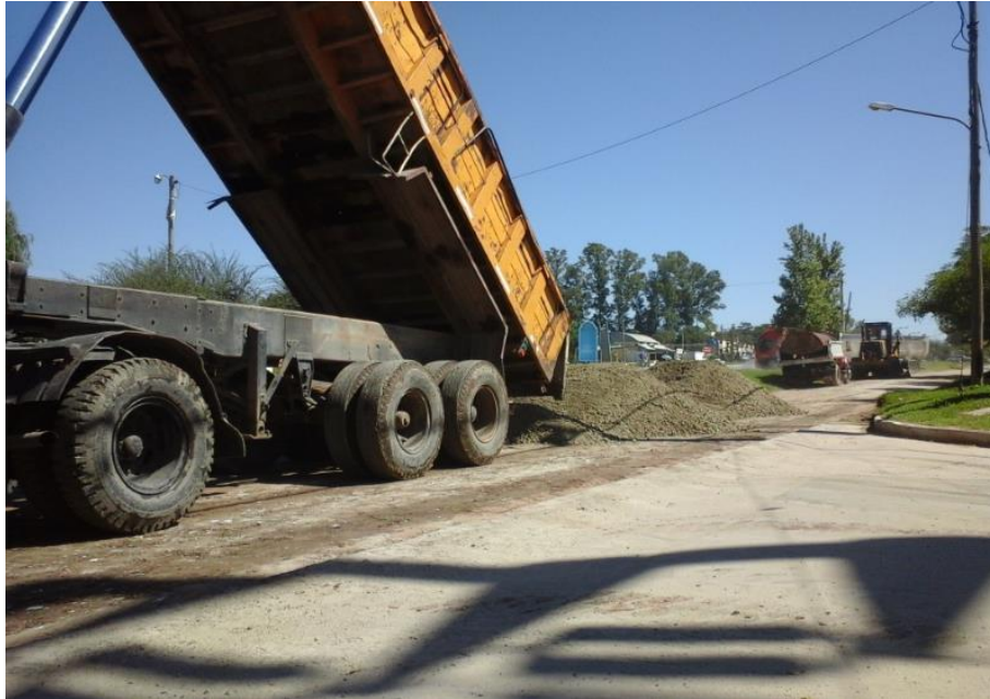
Figura N° 61: Descarga del material 0-20. (Fuente: Elaboración Propia).
