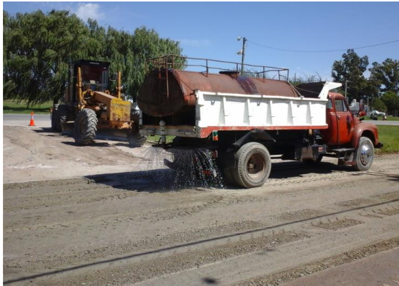
Figura N° 63: Humectación del material. (Fuente: Elaboración Propia).
