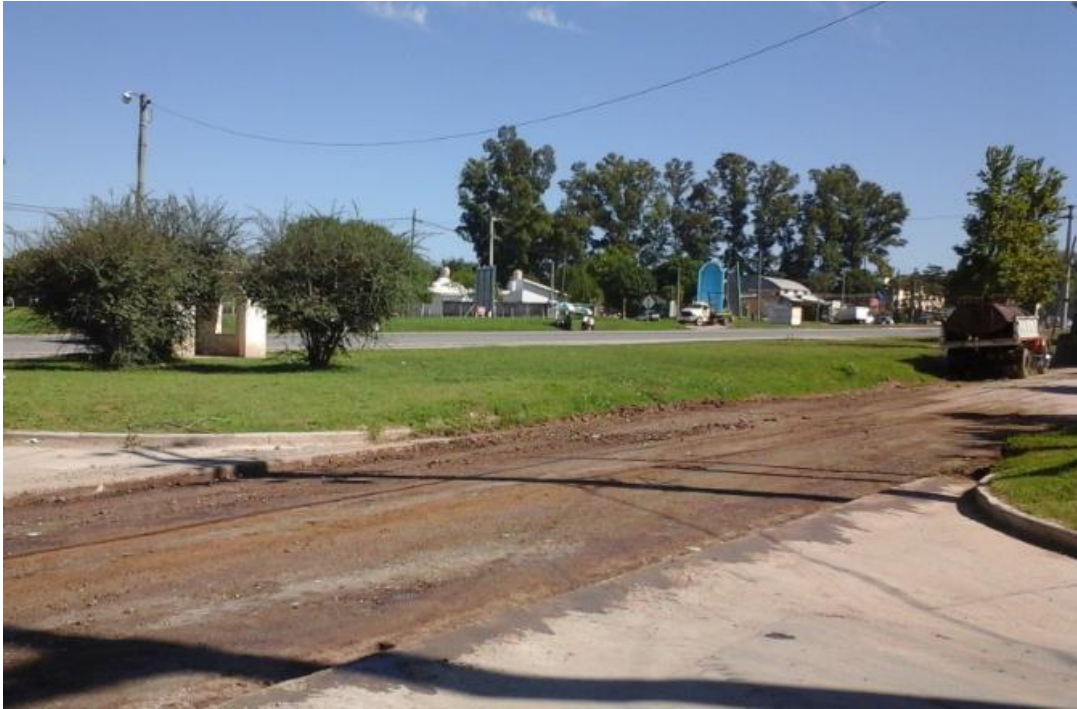
Figura N° 59: Humectación de la superficie. (Fuente: Elaboración Propia).
