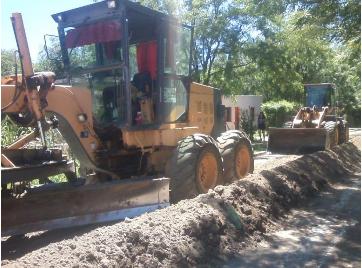
Figura N° 58: Desmote con motoniveladora y cargadora frontal. (Fuente: Elaboración Propia).
