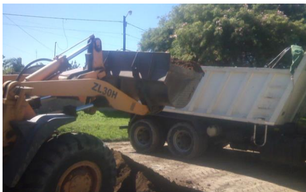
Fig 3.16 – Retiro de material
