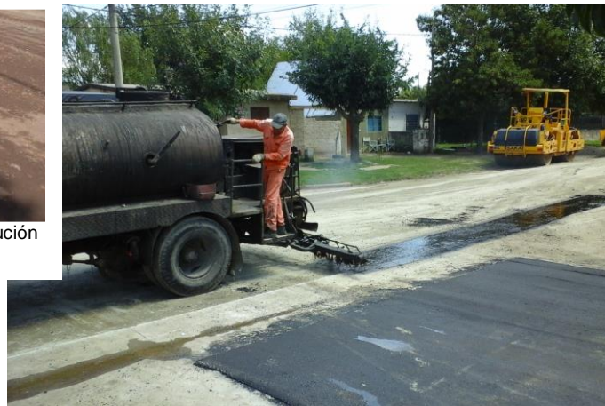
Fig 3.24 – Riego de imprimación sobre base granular.
