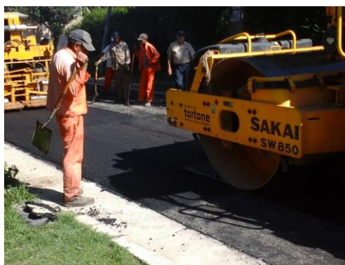
Fig 3.27 – Compactación – Rolo vibratorio.
