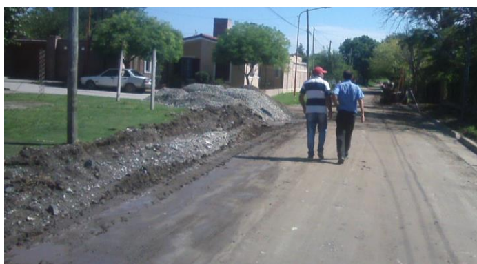
Fig 4.11 – Apertura de cajón para ejecución de cordón cuneta.
