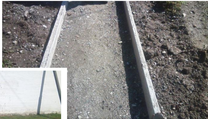
Fig 4.9 – Equipos: Moldes para losa de hormigón.
