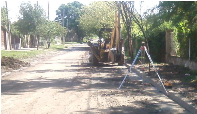
Fig 4.8 – Equipos: Retropala excavadora y Nivel óptico.
