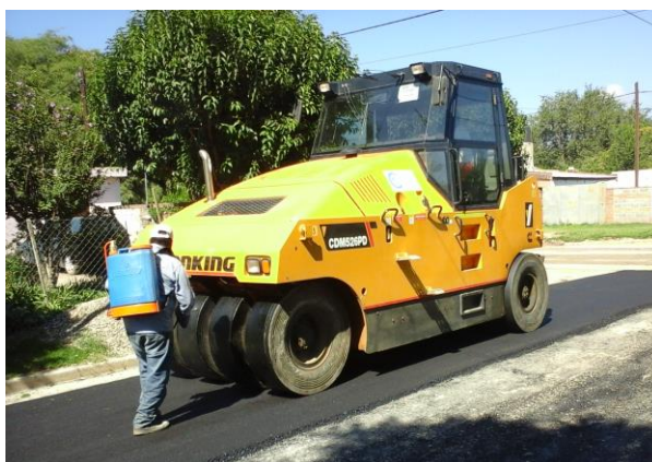
Fig 3.29 – Compactación – Rodillo neumático.
