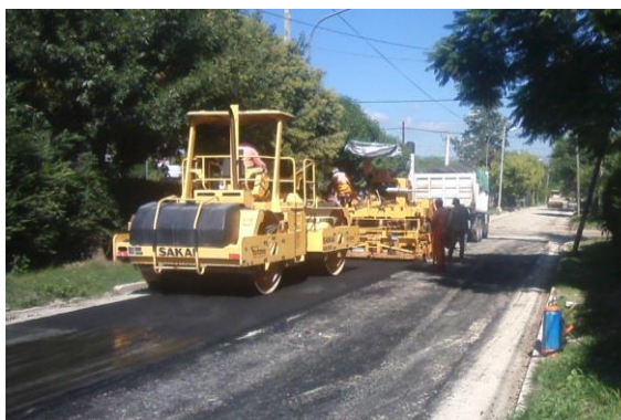
Fig 3.28 – Compactación – Rolo vibratorio.
