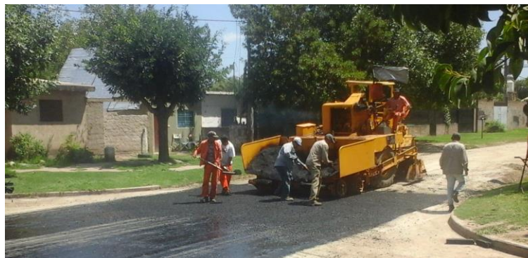
Fig 3.25 – "Granzeado" manual sobre riego de imprimación.
