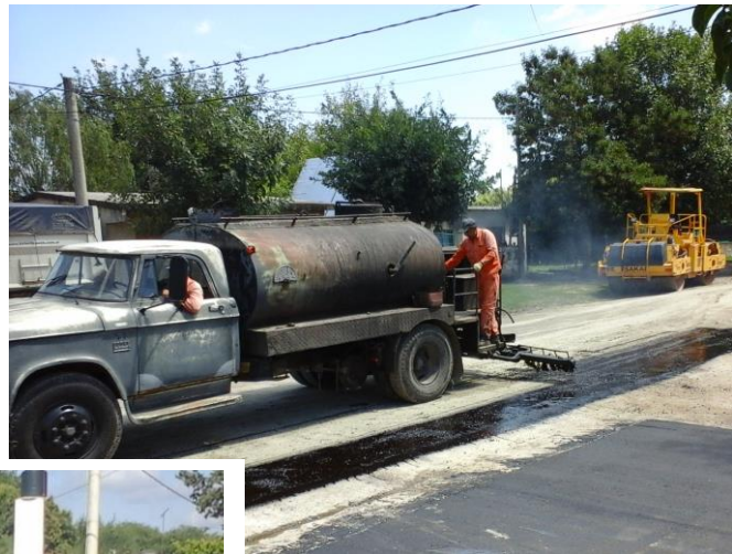
Fig 3.11 – Equipos: Camión regador de asfalto.
