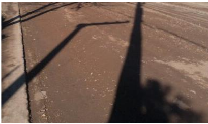
Fig 3.23 – Diente para posterior ejecución de carpeta asfáltica.
