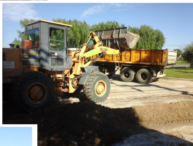
Fig 3.8 – Equipos: Cargadora Frontal
