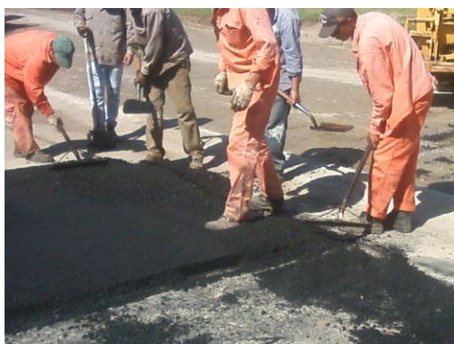
Fig 3.30 – Junta entre carpeta asfáltica y badenes de hormigón.
