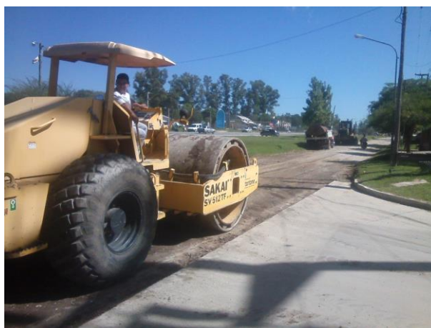
Fig 3.17 – Compactación de subrasante
