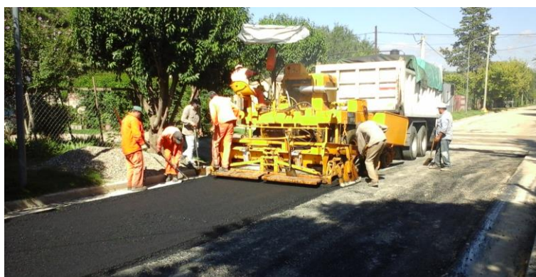
Fig 3.26 – Ejecución de carpeta asfáltica – Pavimentadora.
