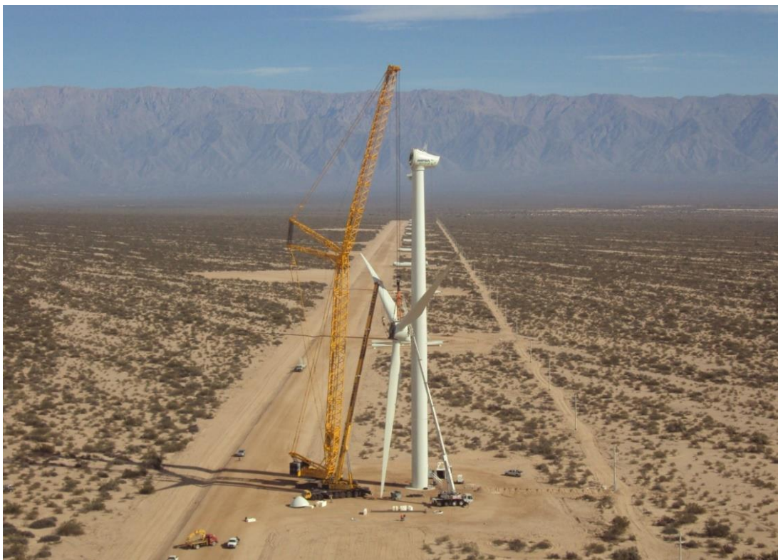
Figura 28 Ubicación Montaje de turbina de viento en Parque Eólico Arauco
